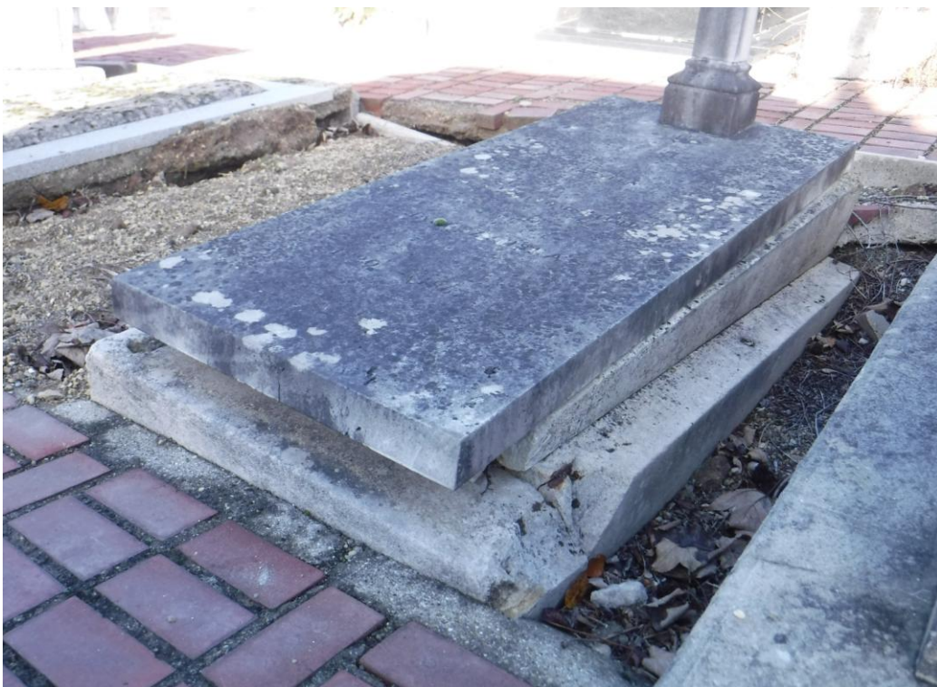
Fot. 5. Nagrobek Matyldy Jaroszyńskiej na cmentarzu Champaux w Montmorency, Francja. Widok trzy czwarte od strony południowo wschodniej. Stan na 2024r.
