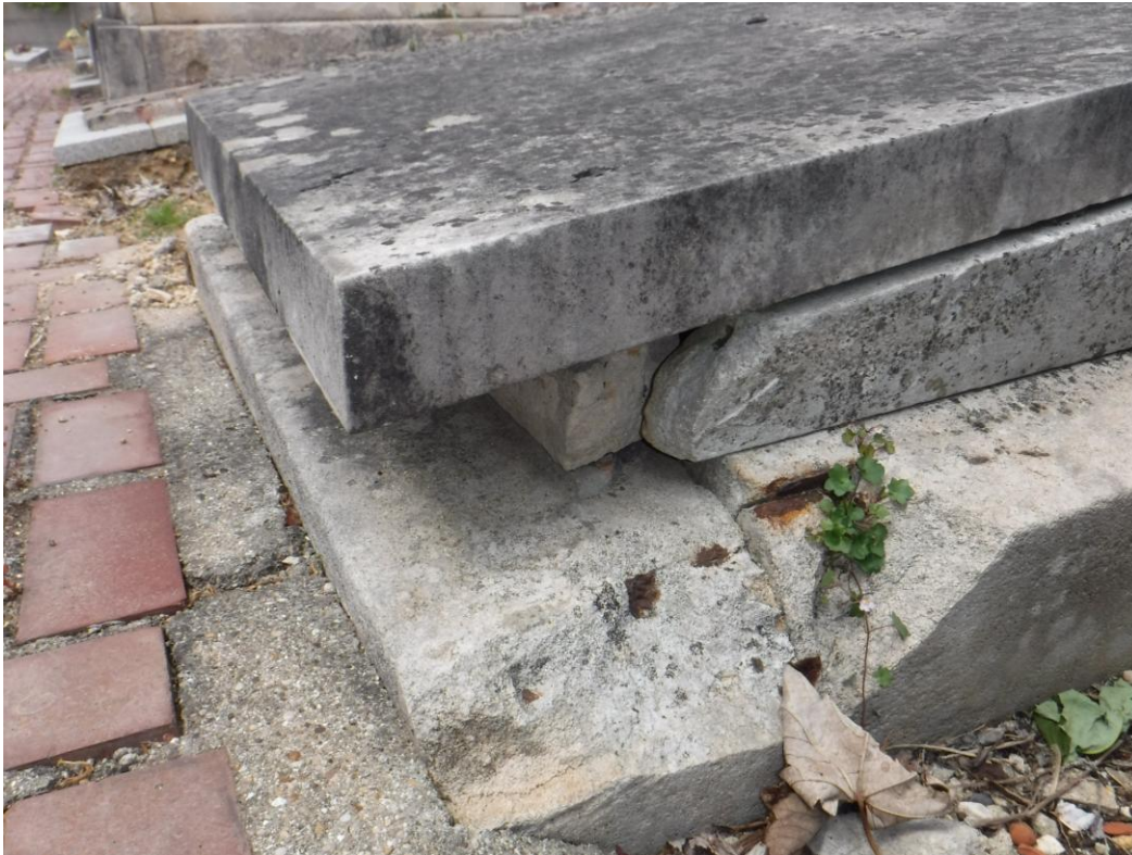
Fot. 12. Nagrobek Matyldy Jaroszyńskiej na cmentarzu Champaux w Montmorency, Francja. Zbliżenie na duże ubytki w cokole. Stan na maj 2025r..
