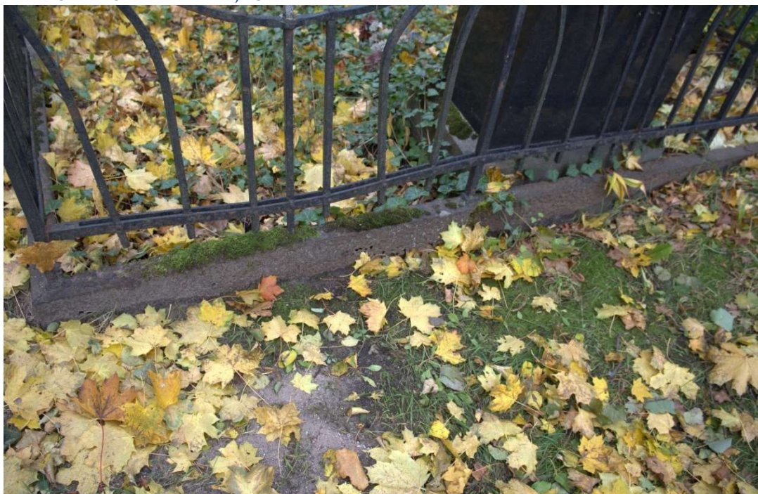
Fot. nr 21. Ogrodzenie nagrobka Aleksandra Rudzińskiego oraz Maryi Wyrzykowskiej z cmentarza św. Michała w Rydze, Łotwa, tył. Widoczna zdestruowana ława, październik 2023 r. Autor fot. Marta Butkiewicz.
