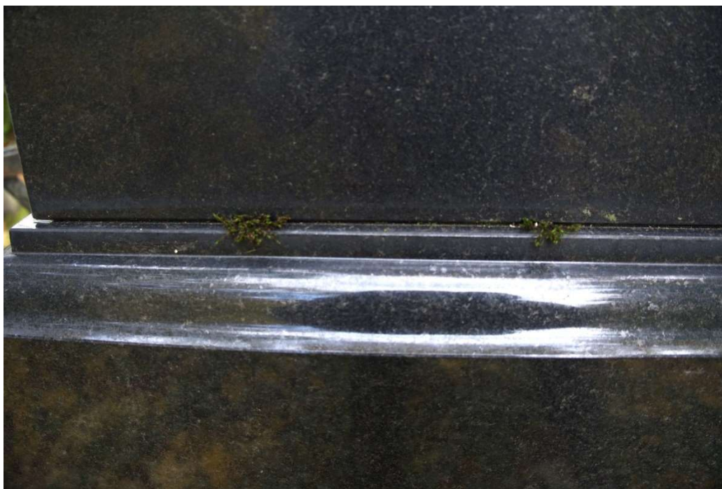
Fot. nr 16. Nagrobek Aleksandra Rudzińskiego oraz Maryi Wyrzykowskiej z cmentarza św. Michała w Rydze, Łotwa. Widoczne porażenia mikroorganiczne w miejscu spoiny, tył, październik 2023 r. Autor fot. Marta Butkiewicz.
