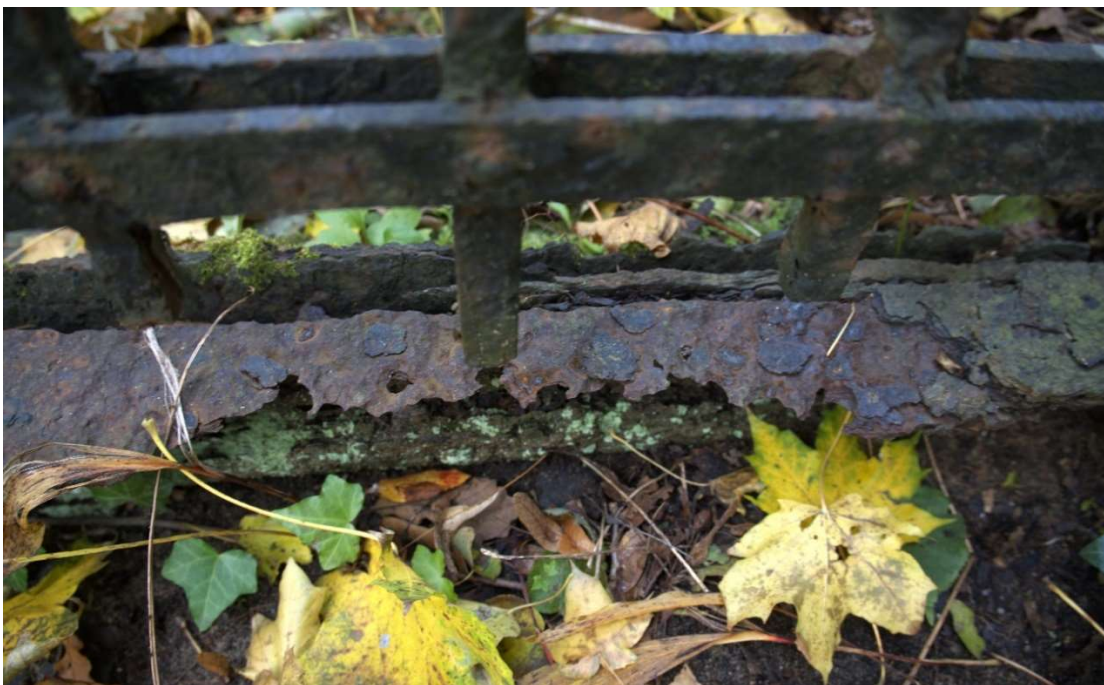
Fot. nr 25. Ogrodzenie nagrobka Aleksandra Rudzińskiego oraz Maryi Wyrzykowskiej z cmentarza św. Michała w Rydze, Łotwa, tył bok. Widoczny fragment zdestruowanej ławy, październik 2023 r. Autor fot. Marta Butkiewicz.
