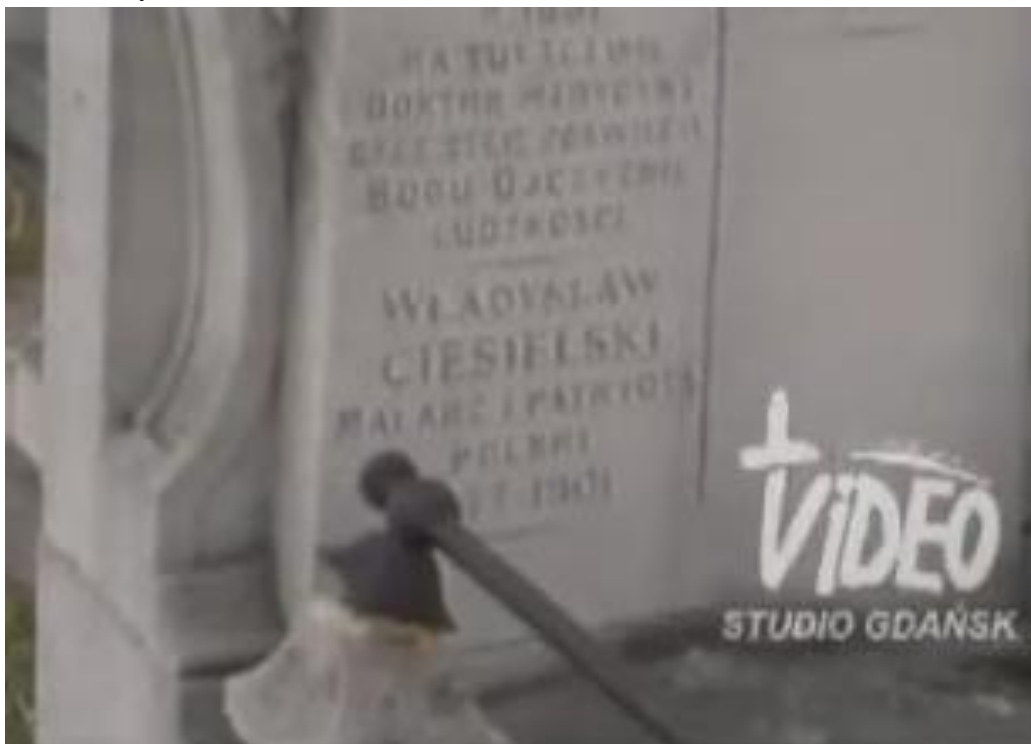
Fot. 7. Stop-klatka z filmu dokumentalnego "Cmentarz Polski w Montmorency". Zbliżenie na skorodowany element mocujący. Stan na 1991 rok
