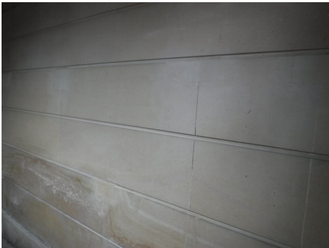
Fot. 9. Kaplica grobowa Mikołaja Jaroszyńskiego na cmentarzu Champaux w Montmorency, Francja, po 1890r. Widok na boczną boniowaną ścianę we wnętrzu kaplicy. Widoczne wysolenia w dolnej partii.
