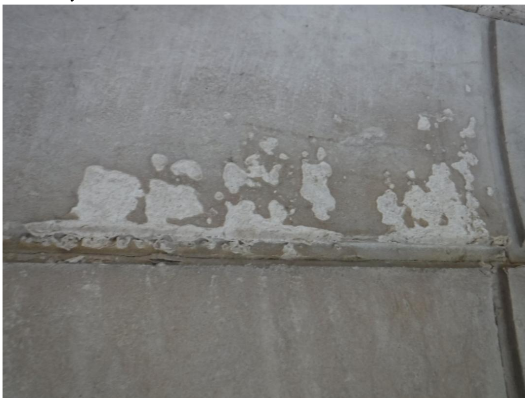
Fot. 8. Kaplica grobowa Mikołaja Jaroszyńskiego na cmentarzu Champaux w Montmorency, Francja, po 1890r. Widok sklepienia we wnętrzu kaplicy, nad wejściem. Stan na luty 2024 roku. Zbliżenie na pudrującą się powierzchnię kamienia
