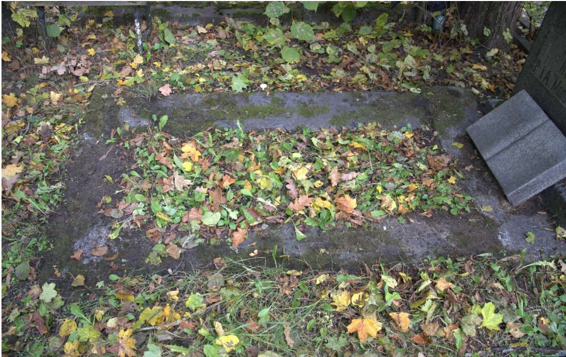
Fot nr 8. Nagrobek rodziny Monkiewiczów z cmentarza św. Michała w Rydze, Łotwa. Widoczna opaska betonowo- lastrykowa, lewy bok obiektu, październik 2023 r. Autor fot. Marta Butkiewicz.
