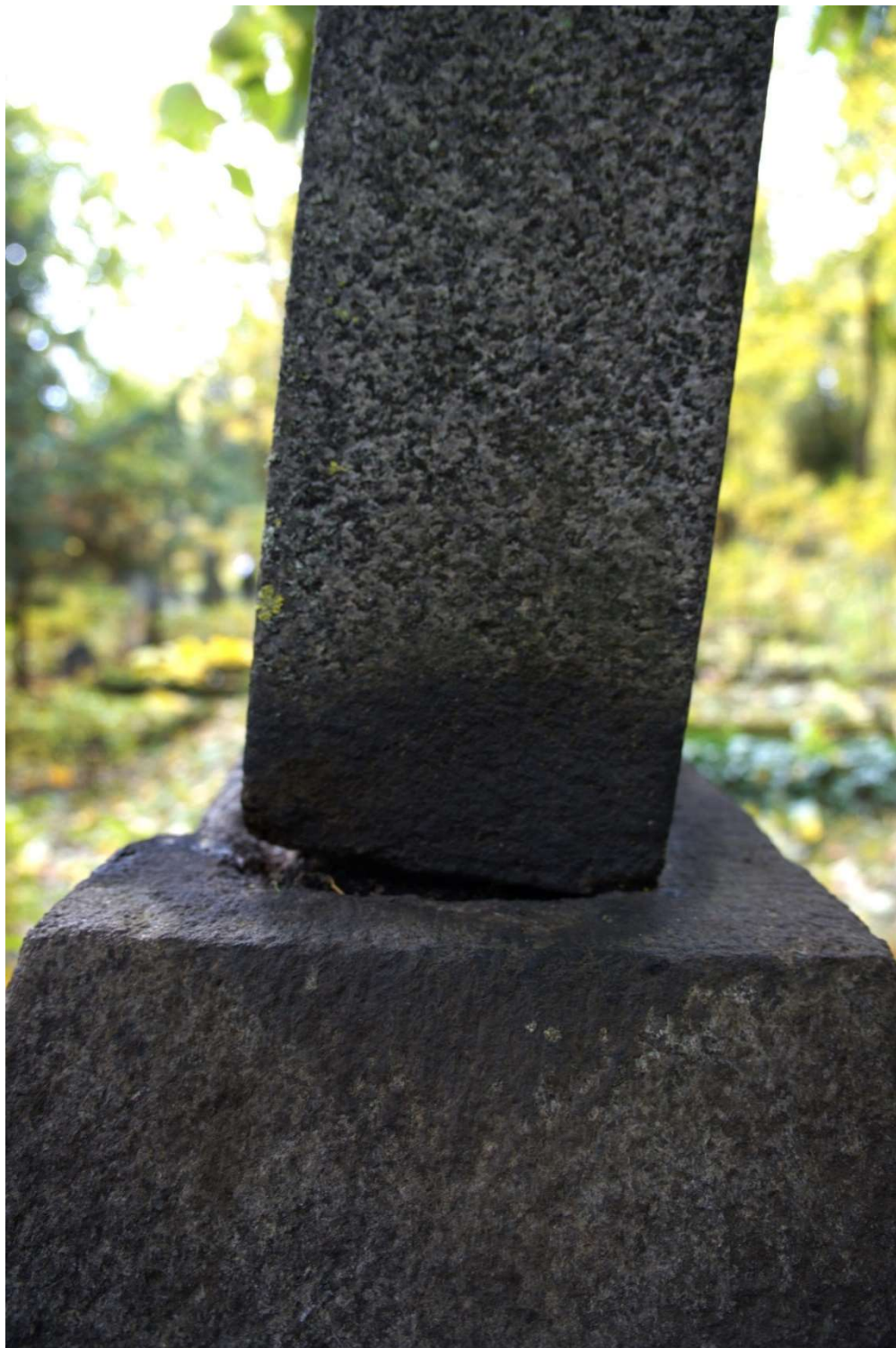
Fot nr 17. Nagrobek rodziny Monkiewiczów z cmentarza św. Michała w Rydze, Łotwa. Widoczne odchylenie krzyża od cokołu, prawy bok obiektu, październik 2023 r. Autor fot. Marta Butkiewicz.
