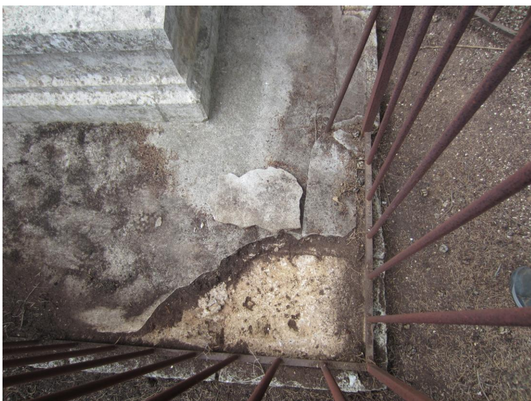
Fot. 8,9. Nagrobek Karola Święckiego i jego rodziny na cmentarzu w Cournonterral we Francji. Zbliżenie na pękającą wtórną warstwę betonu. Stan na kwiecień 2023 roku.
