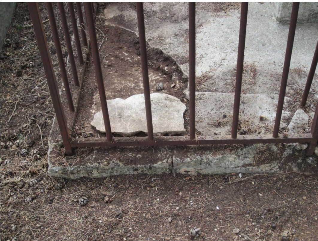
Fot. 7. Nagrobek Karola Święckiego i jego rodziny na cmentarzu w Cournonterral we Francji. Zbliżenie na pękającą wtórną warstwę betonu. Stan na kwiecień 2023 roku.
