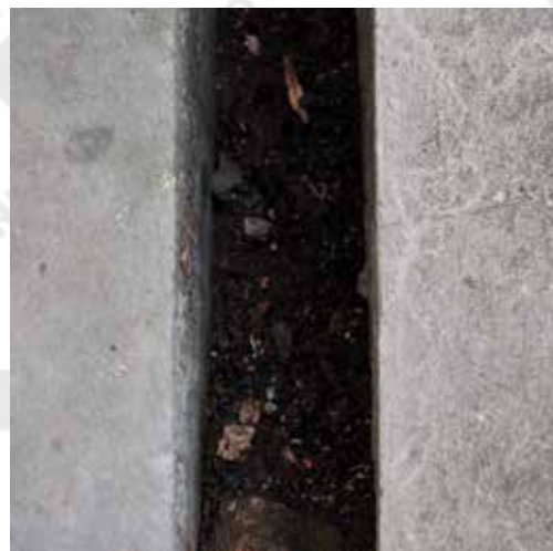
іл. 55 б Надгробок виготовлений з пісковика (ліворуч) і бетону (праворуч) з подібною текстурою, що ускладнює ідентифікацію матеріалу
