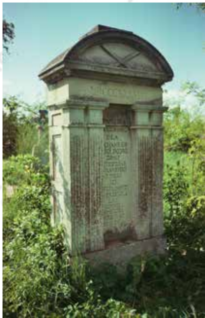
іл. 21 Едикула, обрамлена двома парами встановлених на постаменті канелюрованих стовпів, що підтримують спрощений антаблемент з фронтоном
