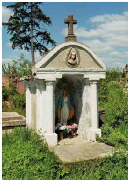
іл. 24 Капличка із втпленою фронтальною стіною, обрамлена колонами в тосканському стилі, що підтримують фронтон, завершена хрестом на плінтусі
