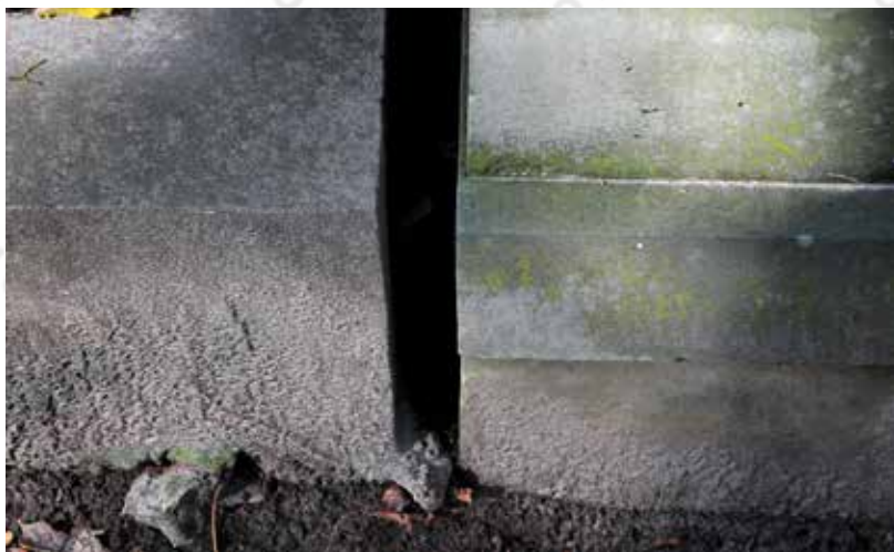
іл. 55 а Відмінності між надгробком виготовленим із бетону (ліворуч) та з пісковика (праворуч)
