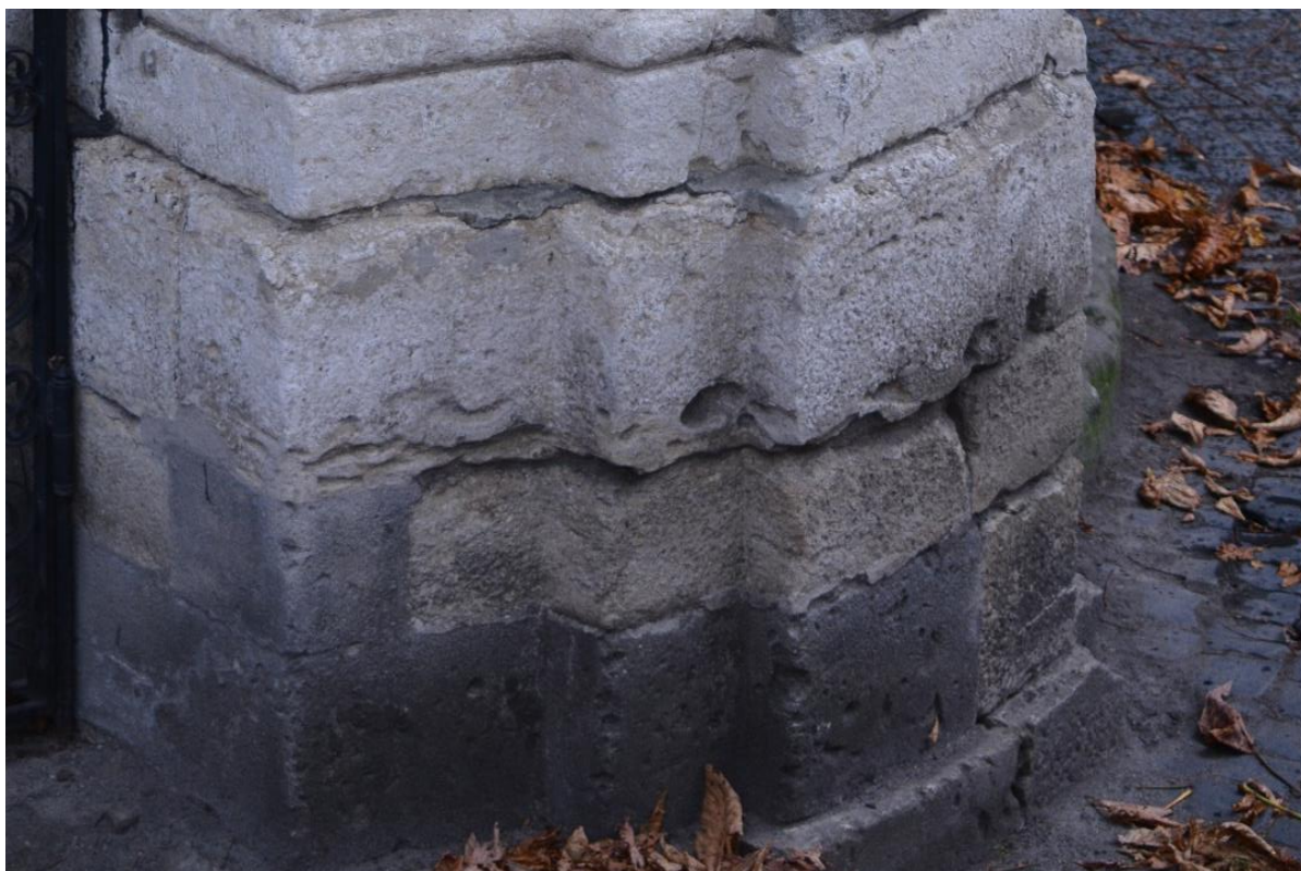
Fot. 81. Widoczne charakterystyczne wypłukania, wyługowania materiału skalnego, powstałe przez wody opadowe i działanie soli z podsiąkania kapilarnego.
