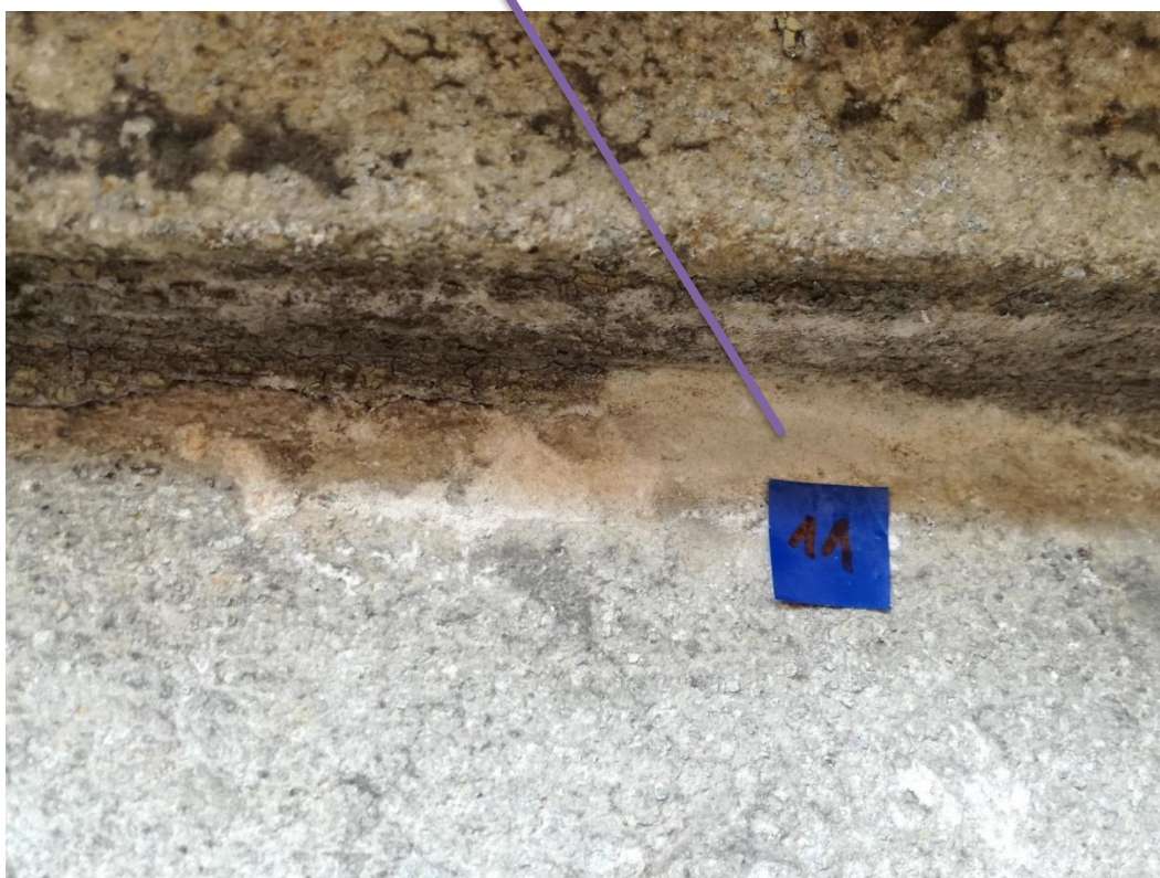
Fot. 28, 29 i 30. Pozostałości wtórnej warstwy zaprawy oraz dwóch jasnych warstw malarskich na fryzie. Miejsce pobrania próby na gzymsie pod dachem, od strony płd.
