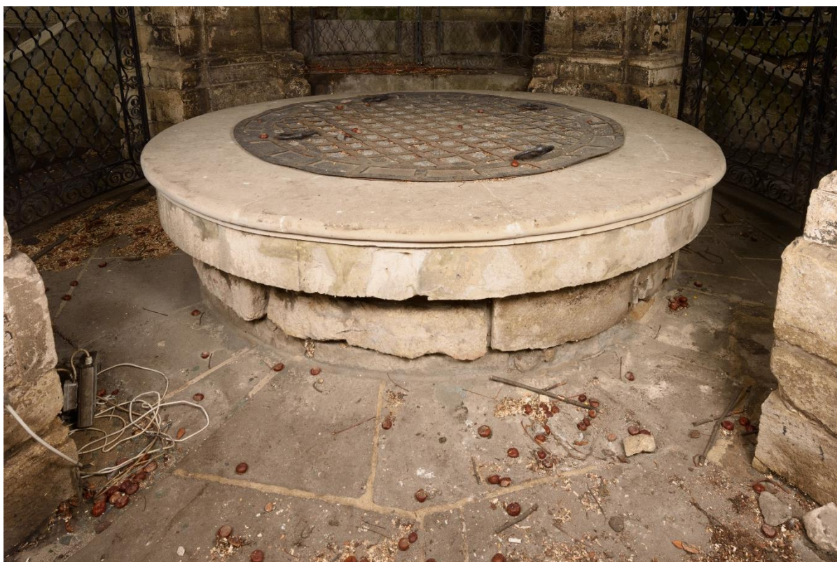
Fot. 46. Widok ogólny na cembrowinę studni.
