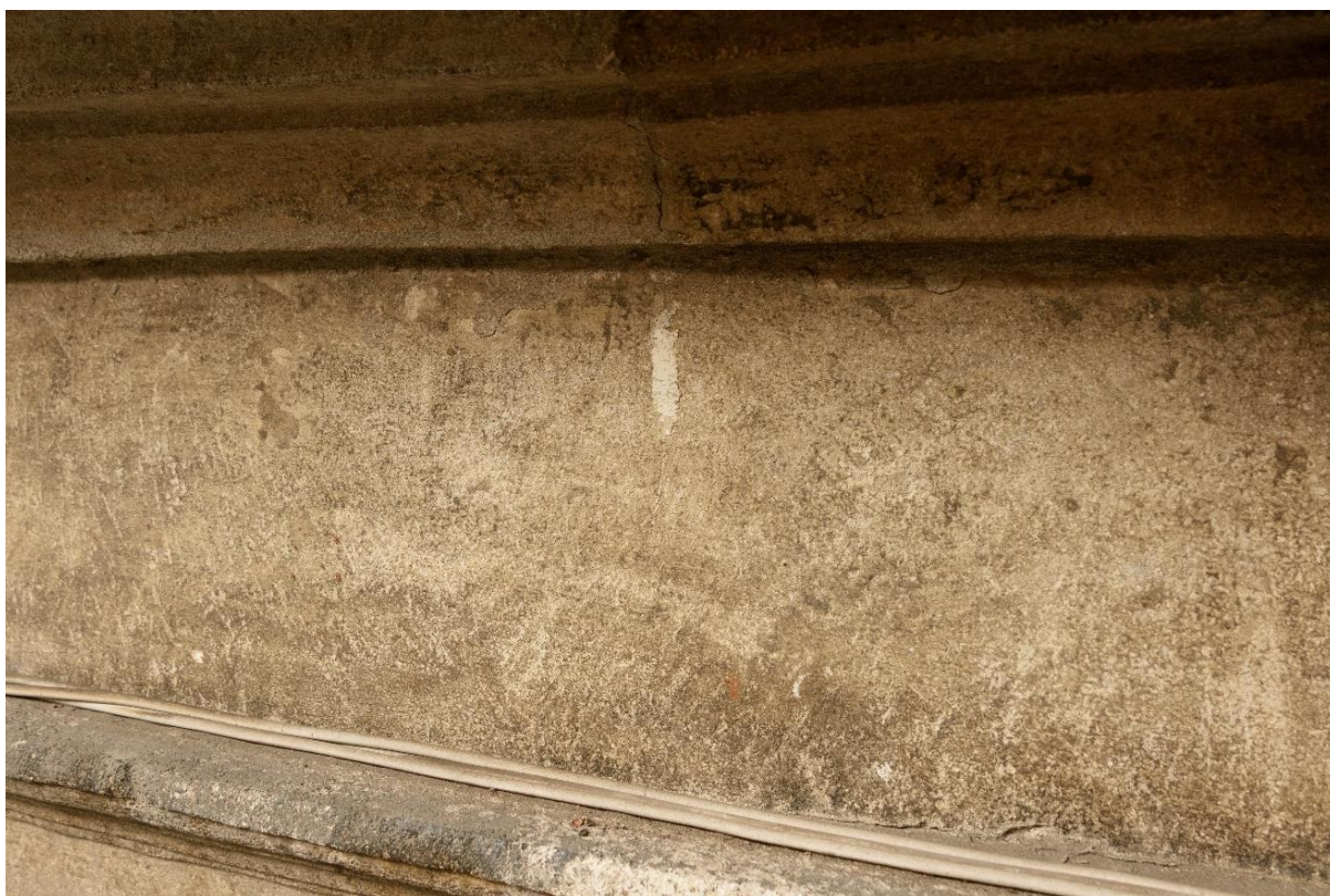
Fot. 22. Widoczne na powierzchni kamienia ślady po dłucie płaskim, którym prawdopodobnie opracowano powierzchnię fryzu w celu usunięcia zniszczeń powierzchniowych i nawarstwień.
