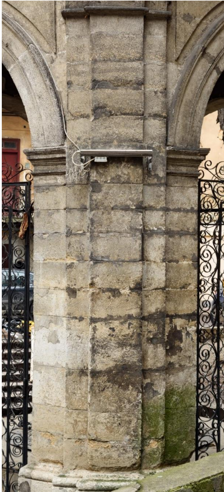
Fot. 9. Budowa filara ze zdwojonym pilastrem z monolitowych wapiennych bloków kamiennych. Cokół płn. - wsch.
