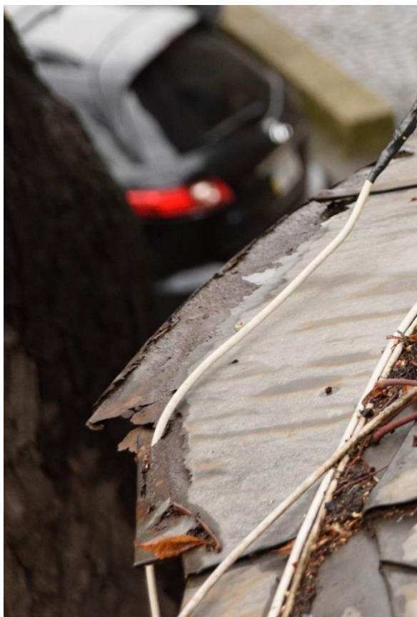
Fot. 115, 116. Skorodowana krawędź dachu.
