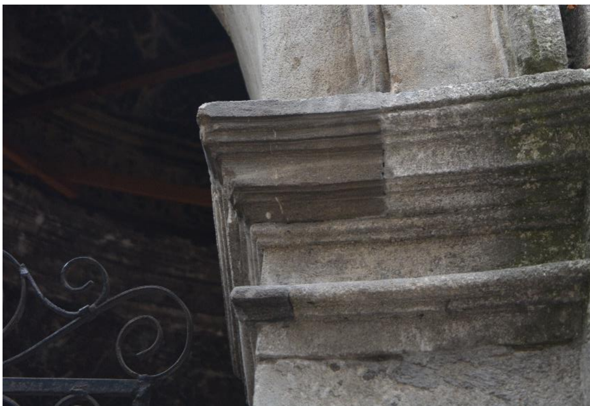
Fot. 34. Uzupelnienie naroznika gzymsu w formie fleka kamiennego oraz naroznika dolnego półokrągłego profilu gzymsu.
