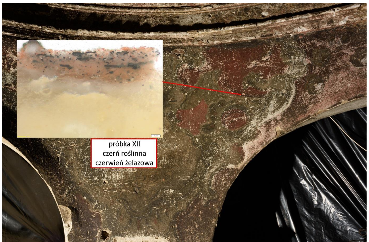
Fot. 49. Warstwa malarska na pendentywach malowana al secco.
