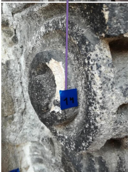
Fot. 31, 32 i 33. Relikt warstwy barwnej mocno zdegradowanej i połączonej z nawarstwieniami czarnymi. Miejsce pobrania próby, ślimacznica. Kapitel pfd. – wsch.
