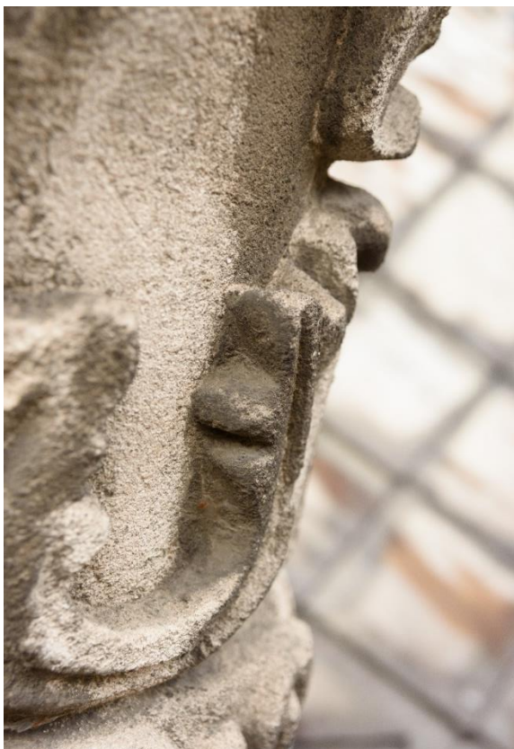
Fot. 74, 75. Zbliżenie skorupiastych, czarnych nawarstwień, które utworzyły się w zagłębieniach formy rzeźbiarskiej na wapiennych wazach wieńczących dach. Widoczna porowata, zwietrzała powierzchnia kamienia.
