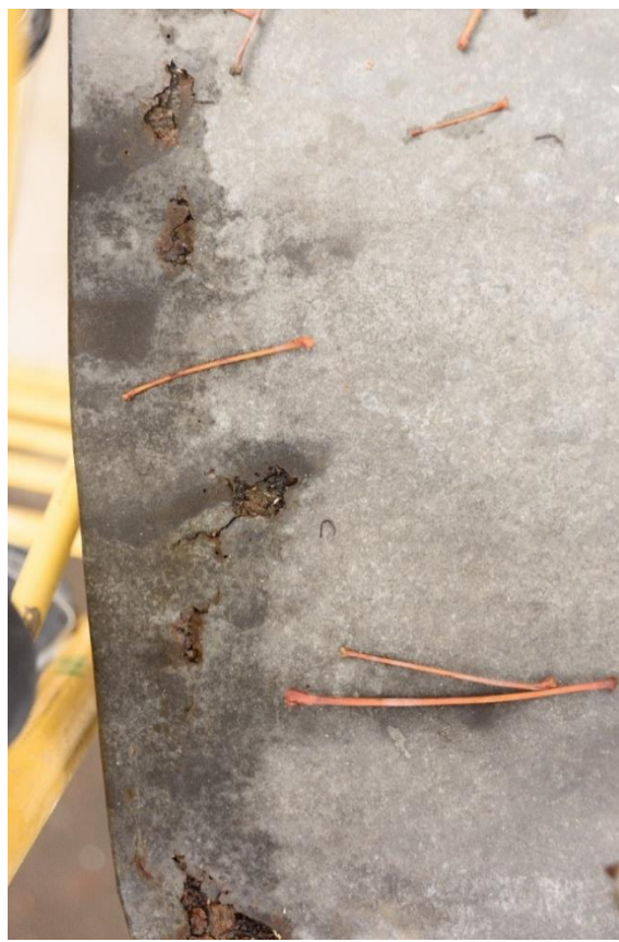
Fot. 115, 116. Skorodowana krawędź dachu.
