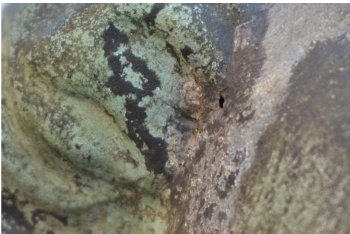
Fot. 120. Widoczny ubytek w blasze z której wykonano figurę.
