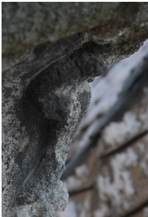
Fot. 74, 75. Zbliżenie skorupiastych, czarnych nawarstwień, które utworzyły się w zagłębieniach formy rzeźbiarskiej na wapiennych wazach wieńczących dach. Widoczna porowata, zwietrzała powierzchnia kamienia.
