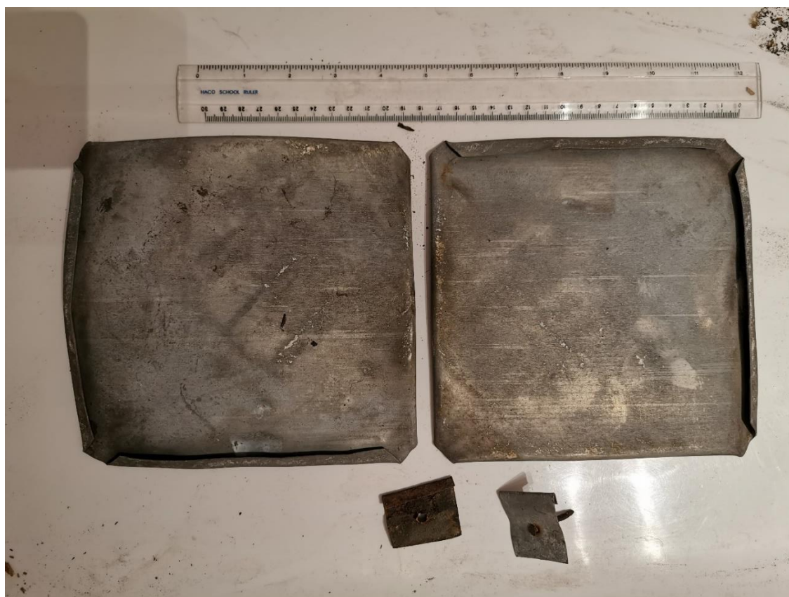
Fot. 57. Zbliżenie dachówek wraz z blaszkami montażowymi, widoczne zagięcia blachy służące do układania dachówek na zakładkę, dachówki pozyskane zostały z połaci pñ. – zach., gdzie dachówki praktycznie nie skorodowane w stosunku do pozostałych dziewięciu pól.
