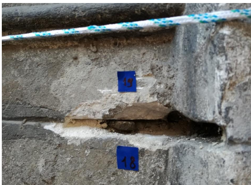
Fot. 8. Miejsce pobrania próby do badań petrograficznych (zał. 3, próba 19). Filar płd. – wsch., pod lewym gzymsiem wieńczącym filar).
