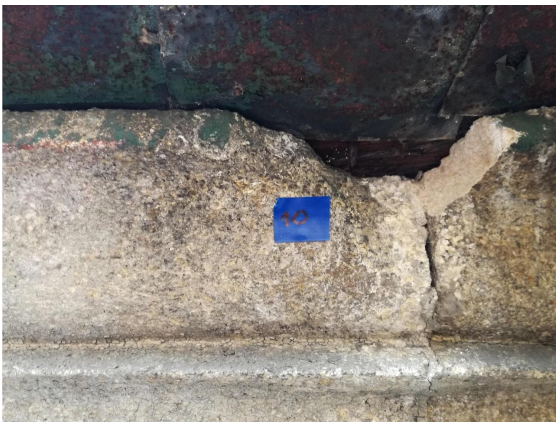
Fot. 20. Miejsce pobrania próby do badań petrograficznych (zał. 3, próba 10). Filar płd. – wsch., ślimacznica na kapitelu.
