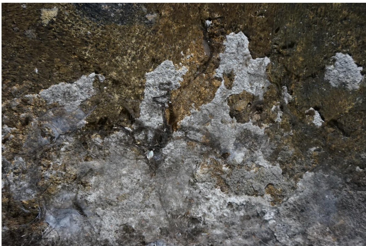
Fot. 102. Zbliżenie na fragment sklepienia z gęstą siecią zanieczyszczeń pochodzenia organicznego.
