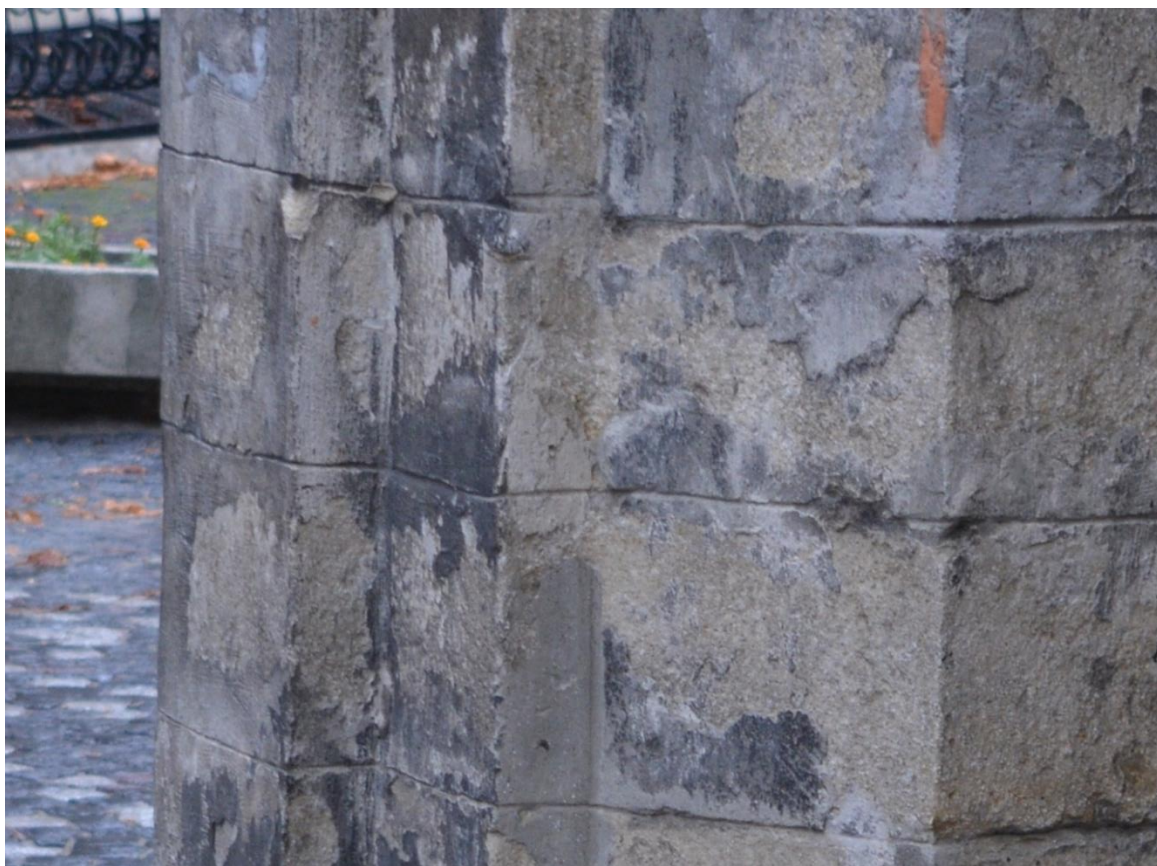
Fot. 21. Widoczne uzupełnienia ubytków filarów i wyrównanie powierzchni zaprawą wapienno – cementową.
