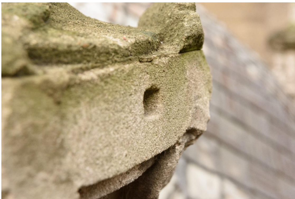
Fot. 44. Pozostałości otworu montażowego, od zachodniej strony wazy płd – wsch.
