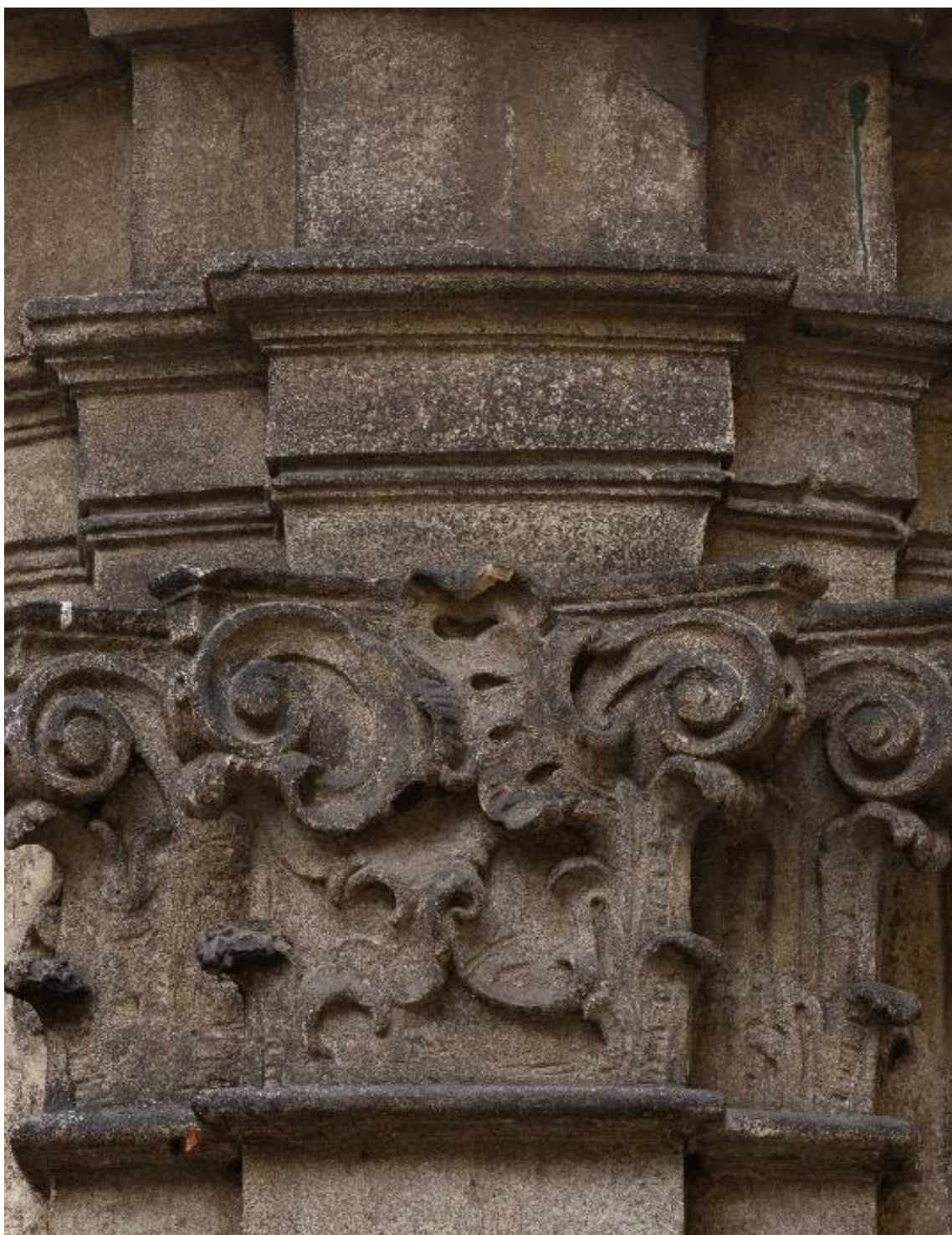
Fot. 73. Nawarstwienia atmosferyczne w postaci czarnych i szarych nawarstwień powstałych z połączenia wytworzonego gipsu z sadzą i smółkami. Najintensywniejsze skupiska znajdują się w miejscach najmniej obmywanych przez wodę: na ślimakach kapiteli i na listwach gzymsów. Nierównomierny charakter ich ułożenia wynika z ponownego gromadzenia się na wtórnej porowatej powierzchni wapienia.
