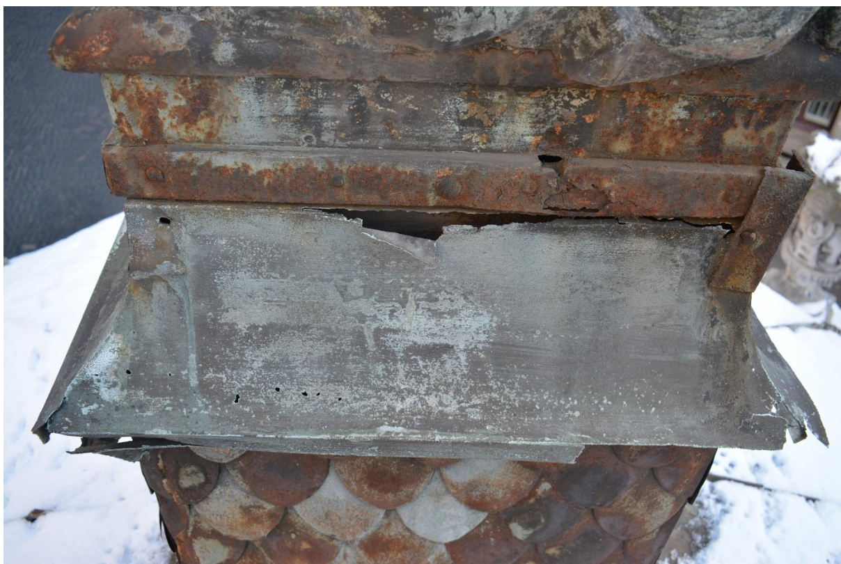
Fot. 119. Widoczne zniszczenia cynkowej blachy z której zbudowany jest gzyms – liczne ubytki, wykruszenia blachy, skorodowana dachówka w formie rybiej łuski oraz stalowe elementy konstrukcyjne łączące podstawę z figurą.
