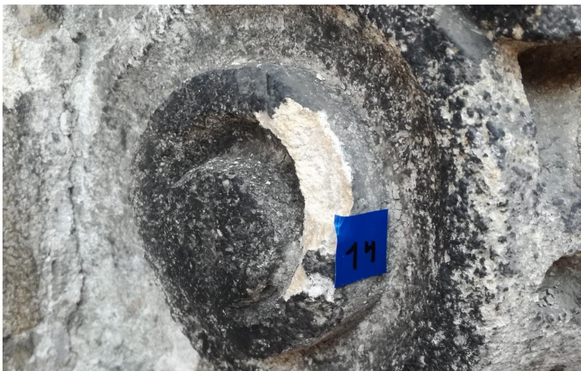
Fot. 19. Miejsce pobrania próby do badań petrograficznych (zał. 3, próba 14). Filar płd. – wsch., ślimacznica na kapitelu.
