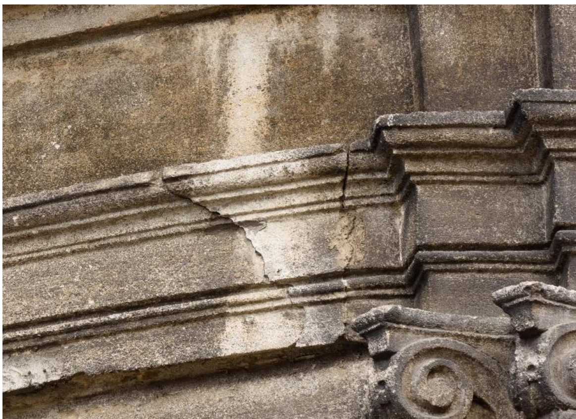
Fot. 77. Widoczny spękany fragment gzymsu na linii zaciekającej wody, który w każdej chwili może ulec całkowitemu odspojeniu.
