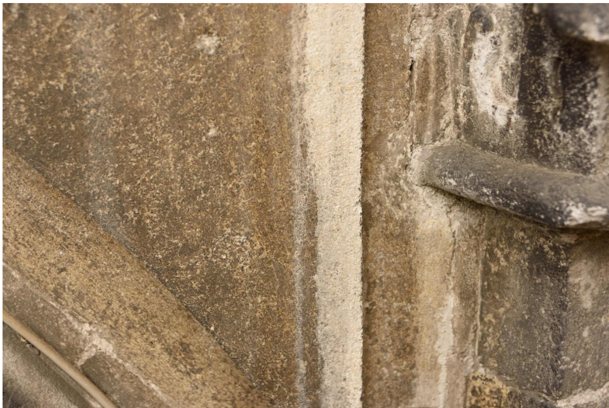
Fot. 16. Spoina łącząca kapitel z pozostałymi blokami kamiennymi.
