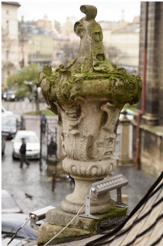
Fot. 68, 69. Nawarstwienia mikrobiologiczne na pokrywach waz wieńczących narożniki dachu.
