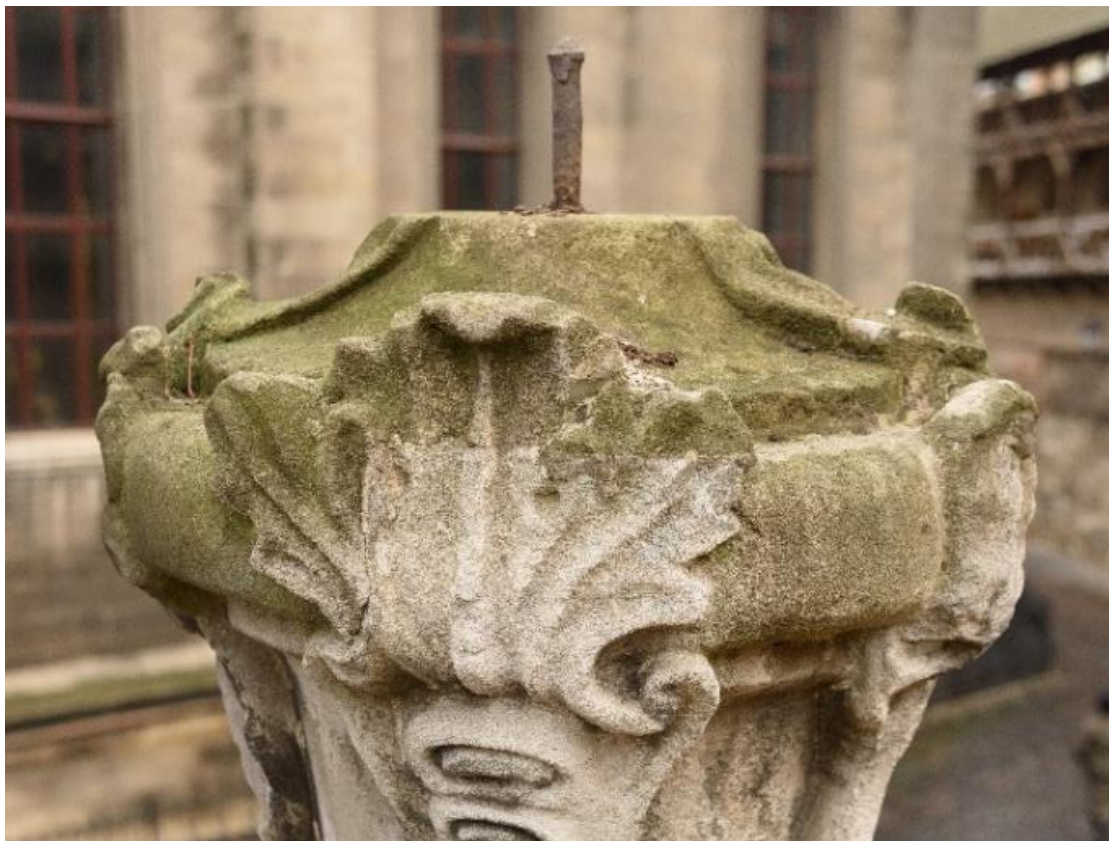
Fot. 43. Widoczny wtórny bolec stalowy, łączący dwa elementy kamienia. Waza od str. płd. – wsch.
