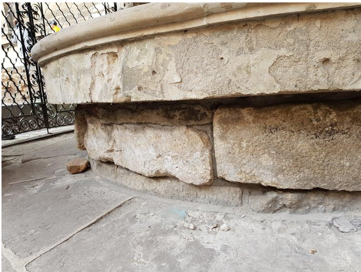
Fot. 47. Widok na posadzkę z piaskowca oraz wapienne bloki zwieńczone piaskowcową ramą, z których zbudowana jest cembrowina.
