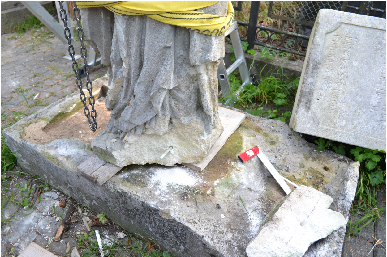
Fot. 11 Obiekt w trakcie prac, wklejanie zachowanych fragmentów
