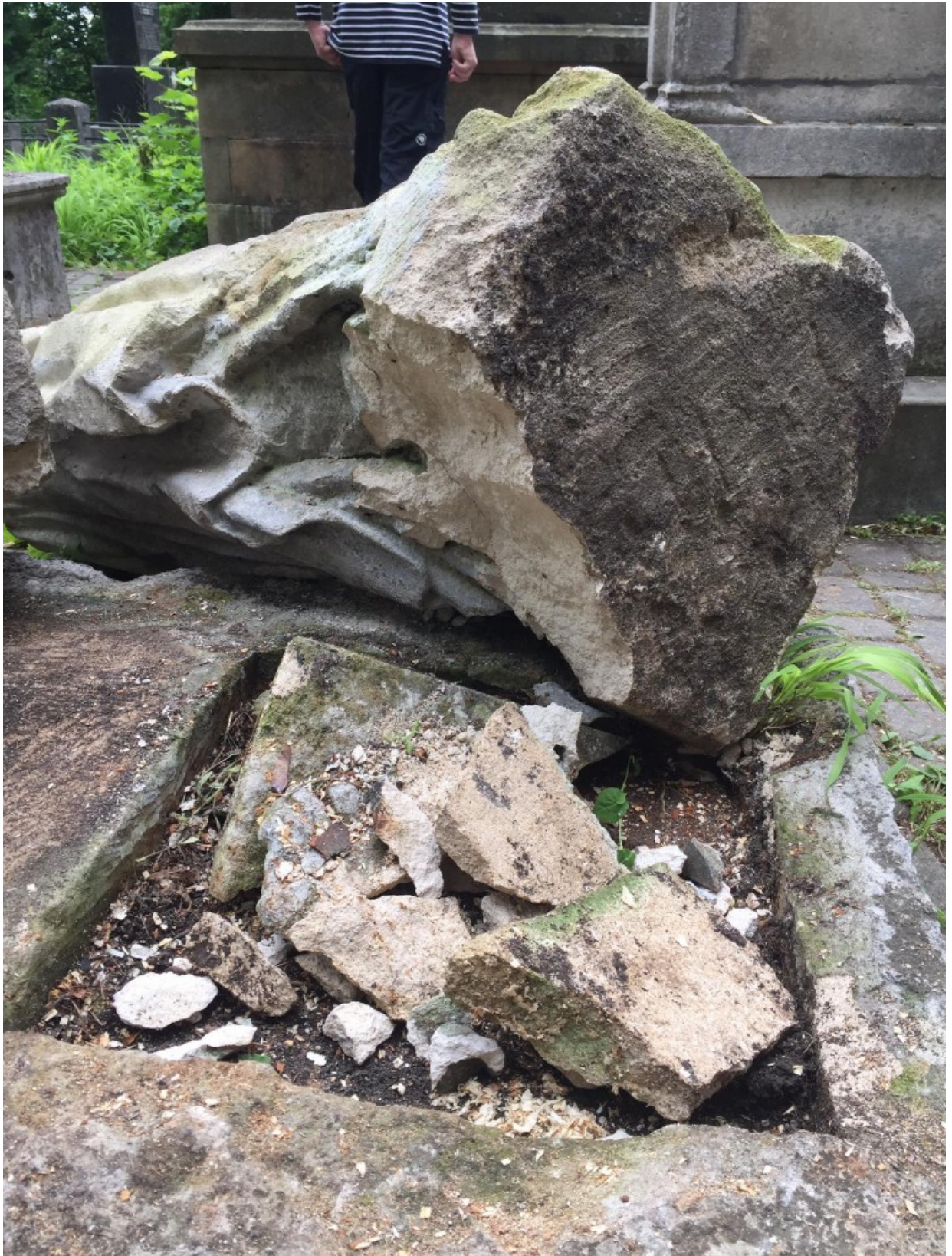
Fot. 4 stan przed przystąpieniem do prac interwencyjnych wykonanych w 2020 r
