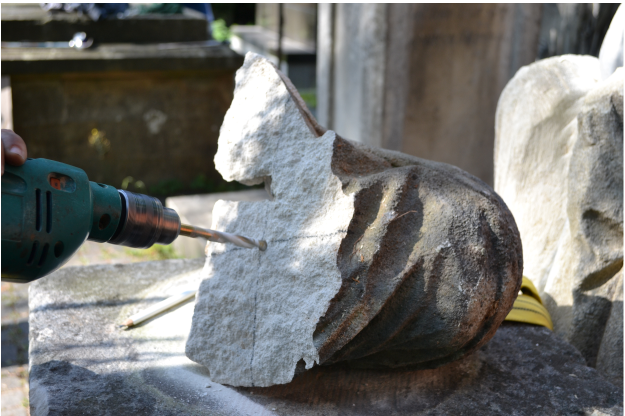
Fot. 12 Obiekt w trakcie prac, wklejanie zachowanych fragmentów
