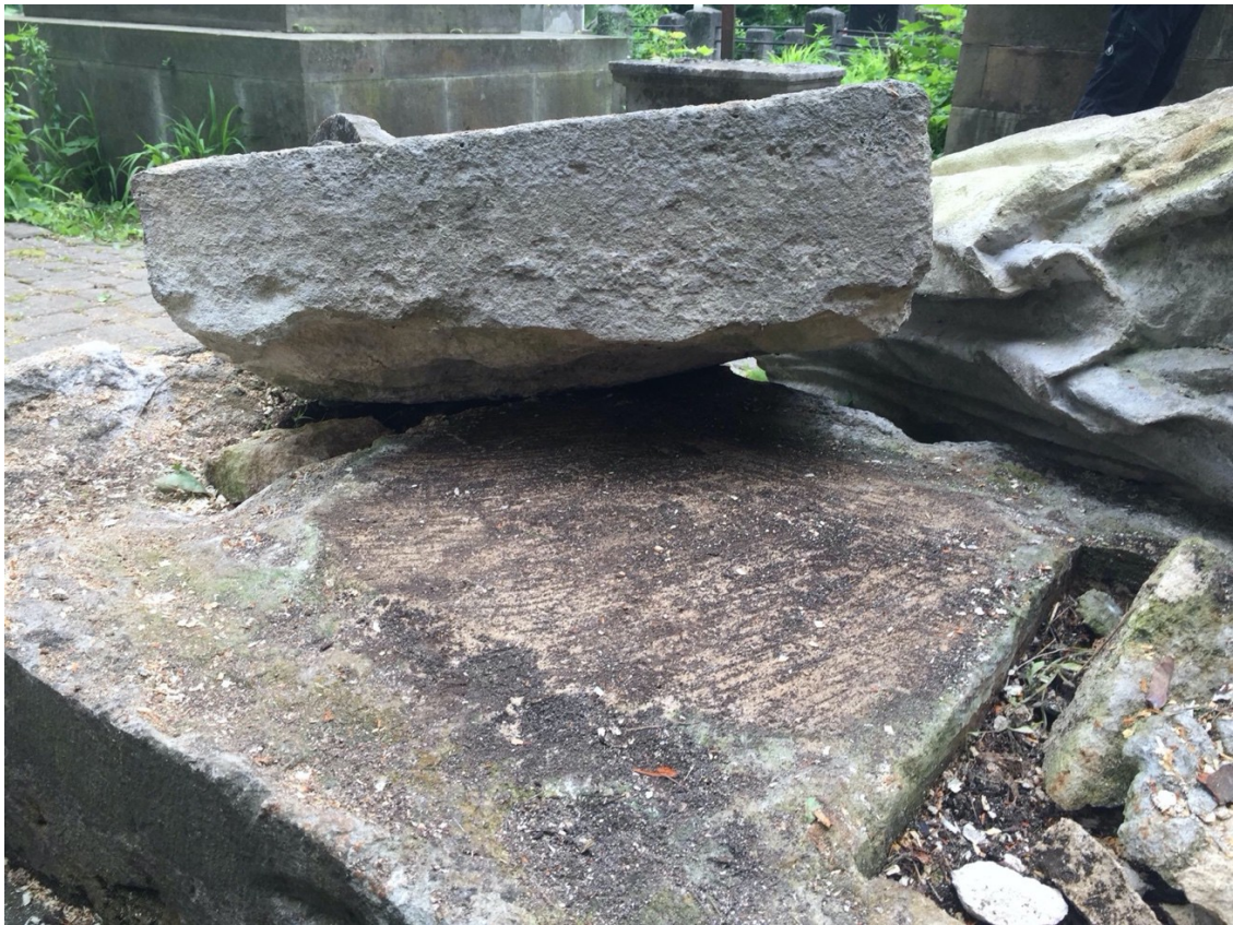
Fot. stan przed przystąpieniem do prac interwencyjnych wykonanych w 2020 r
