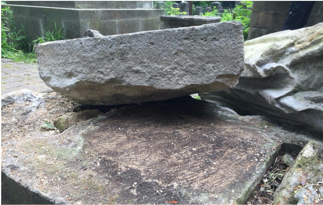
Fot. 9 stan przed przystąpieniem do prac interwencyjnych wykonanych w 2020 r
