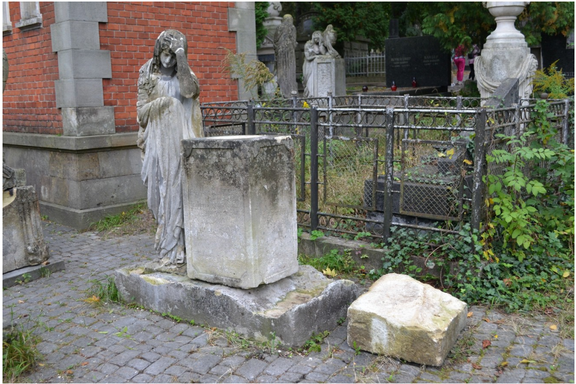
Fot. 18 Stan po wykonaniu prac interwencyjnych
