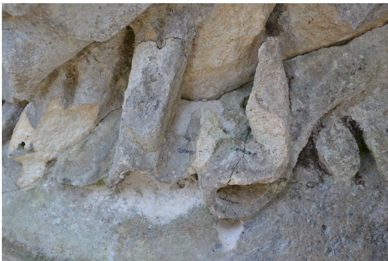
Fot. 14 Obiekt w trakcie prac, wklejanie zachowanych fragmentów szat
