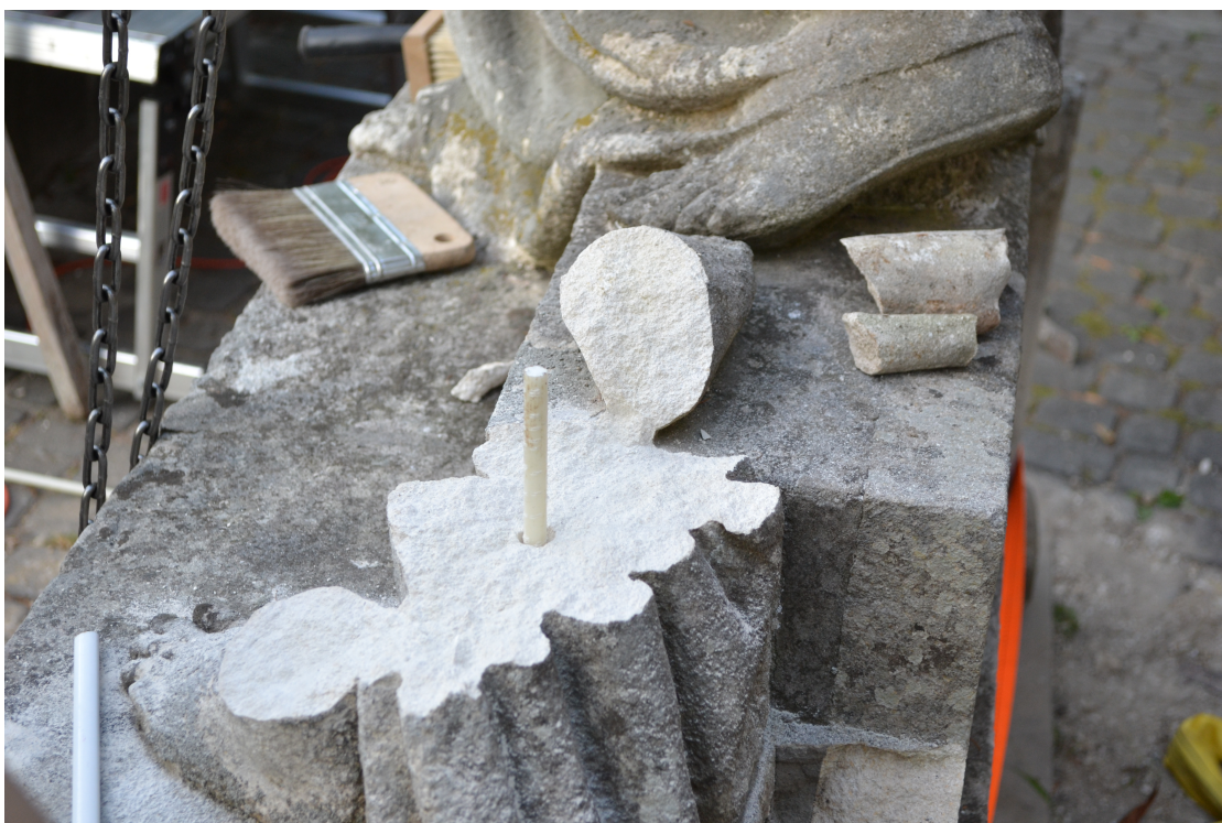
Fot. 11 Obiekt w trakcie prac interwencyjnych
