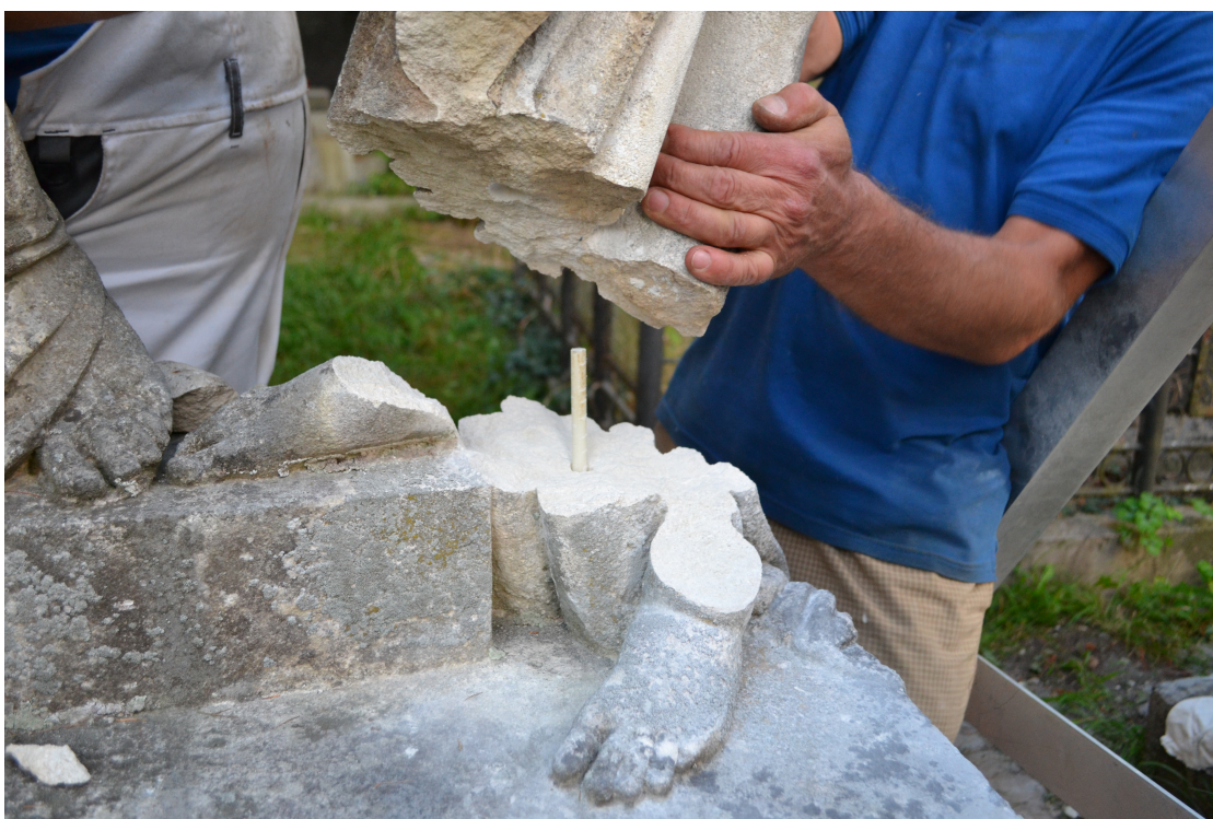
Fot. 12 Obiekt w trakcie prac interwencyjnych
