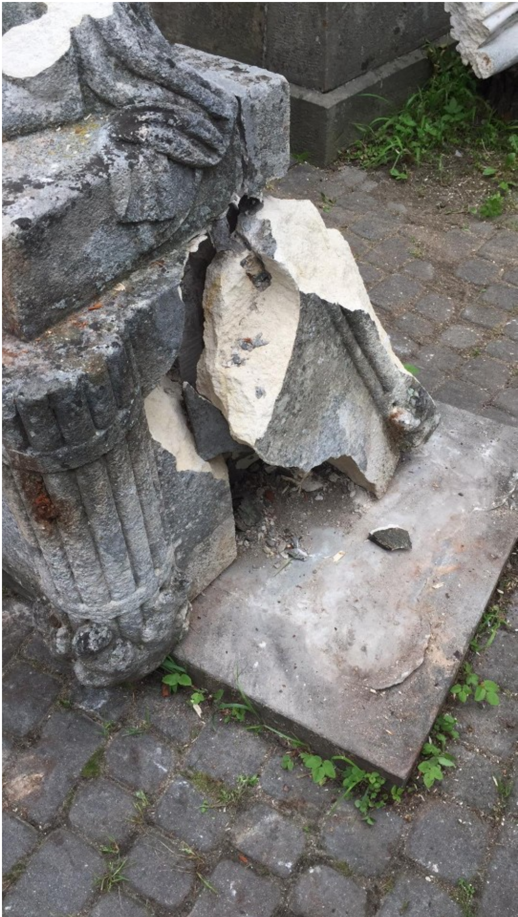
Fot. 2 Obiekt przed pracami interwencyjnymi, stan po uszkodzeniu przez drzewo
