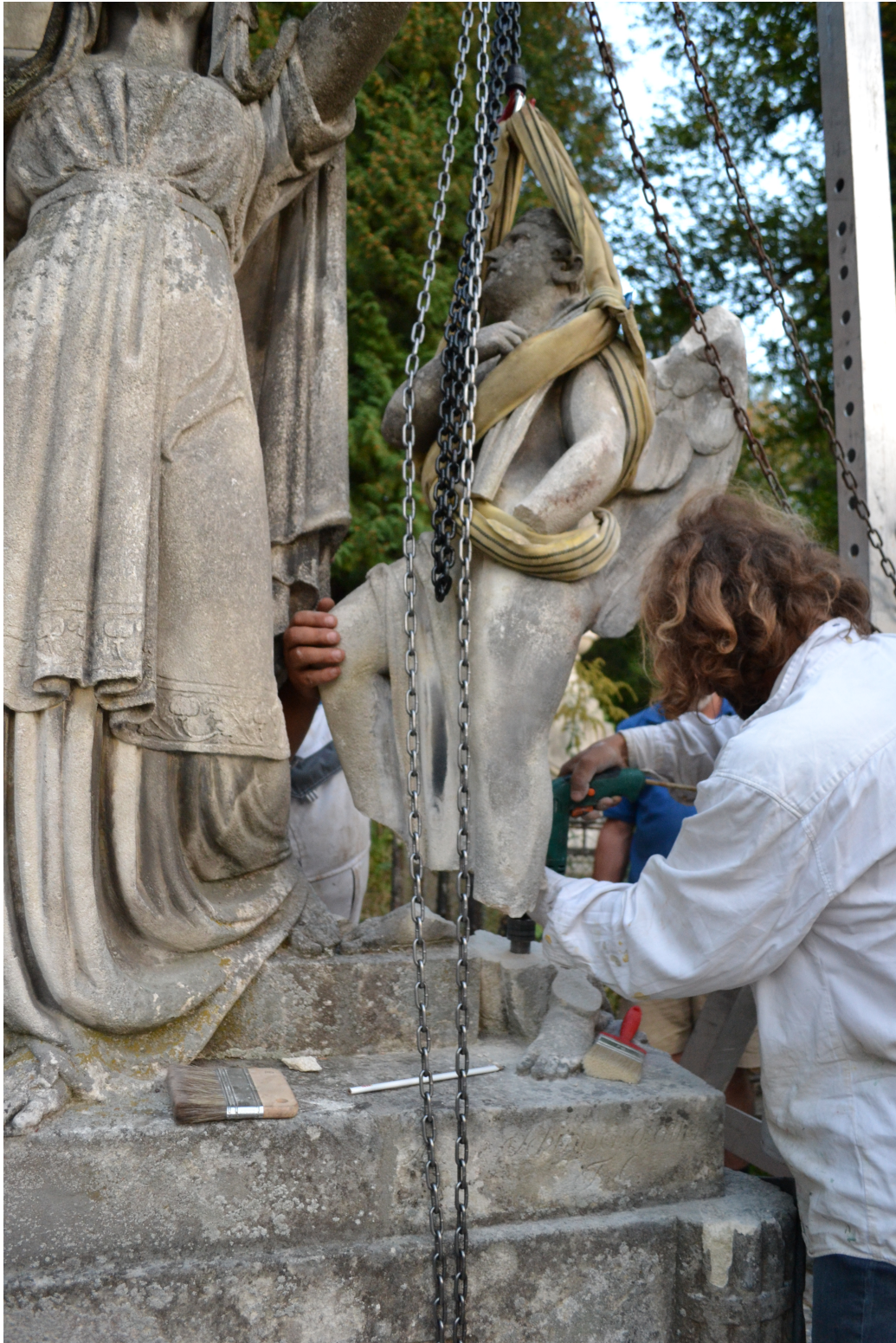
Fot. 13 Obiekt w trakcie prac interwencyjnych
