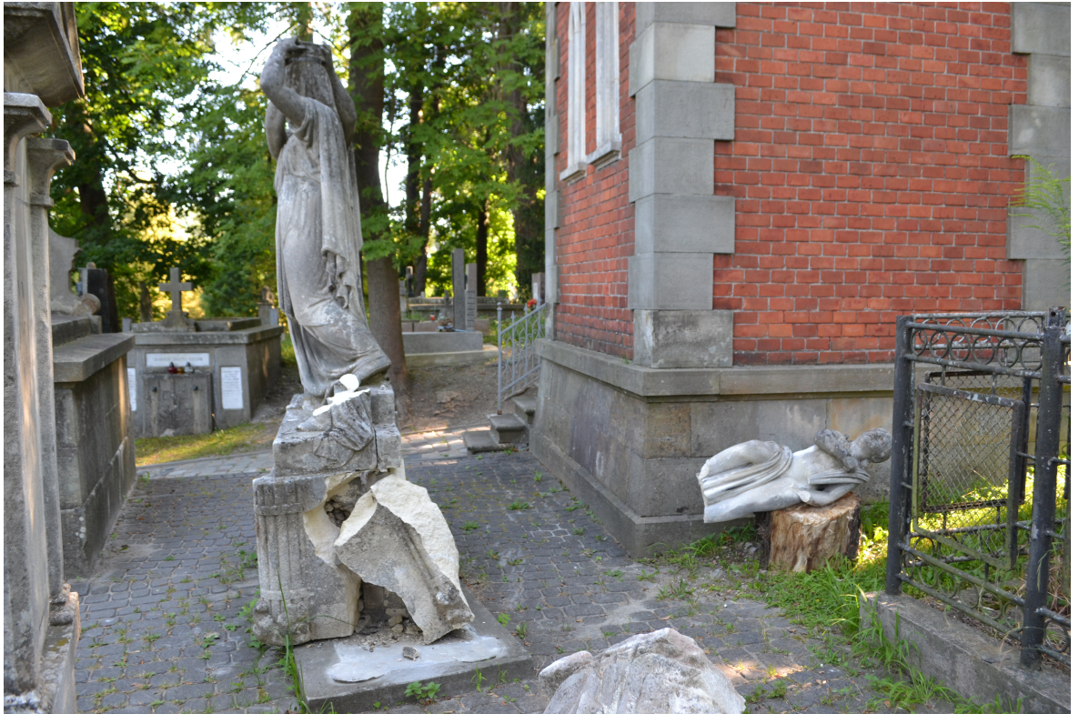
Fot. 7 Obiekt przed pracami interwencyjnymi, stan po uszkodzeniu przez drzewo
