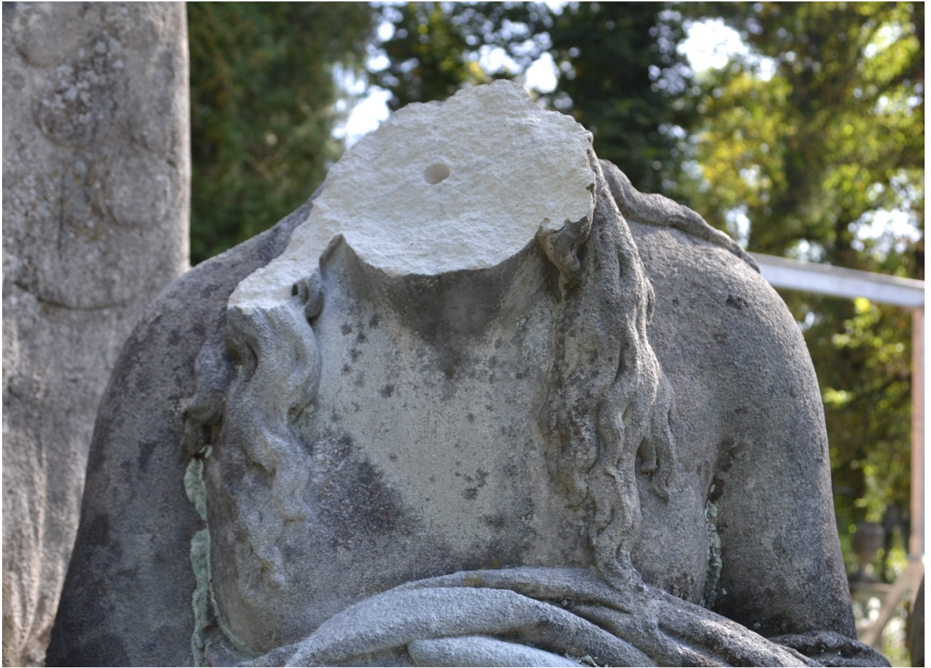
Fot. 5 Obiekt w trakcie prac interwencyjnych, wykonanie otworu pod konstrukcje z włókna szklanego
