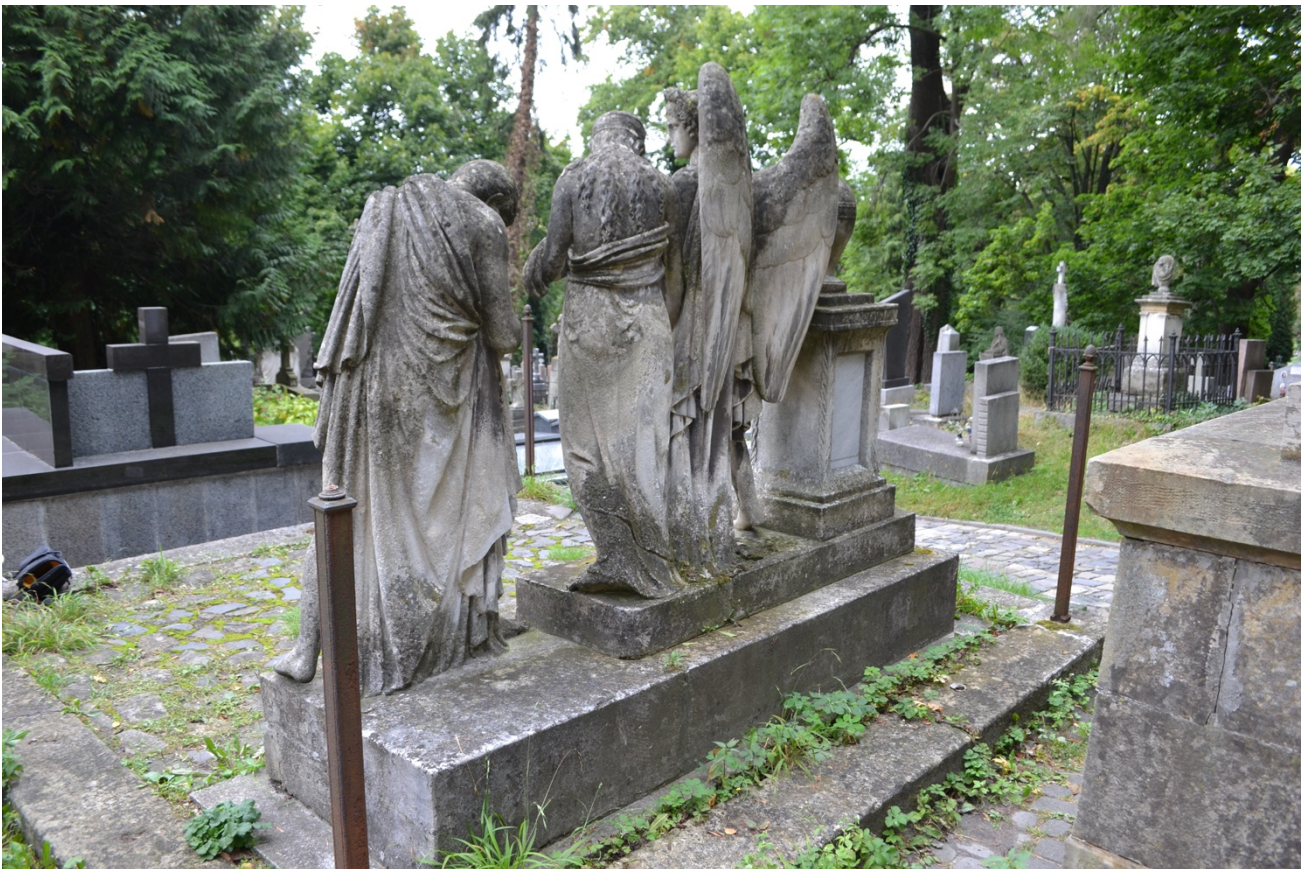
Fot. 10 Obiekt w trakcie prac interwencyjnych, wykonanie kitów zabezpieczających
