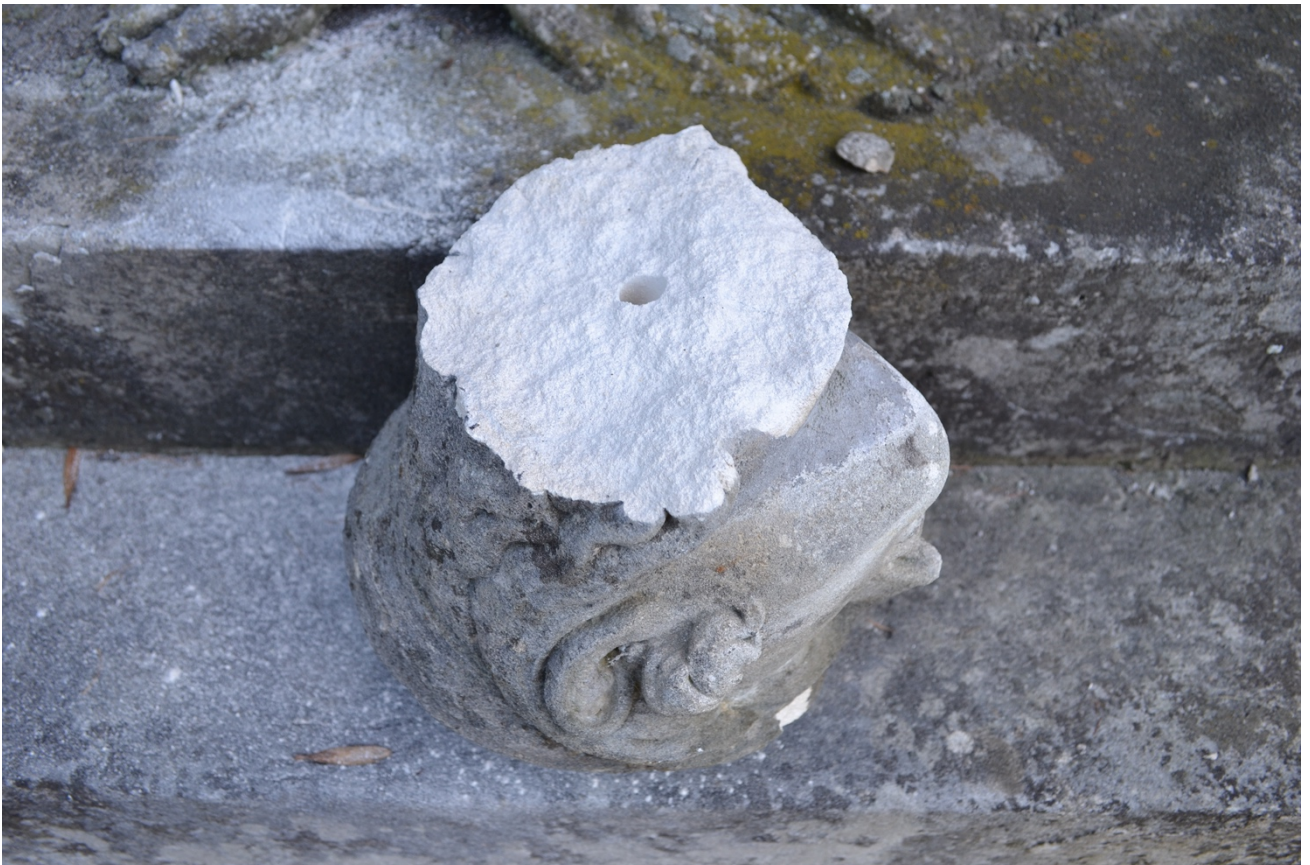
Fot. 6 Obiekt w trakcie prac interwencyjnych, wykonanie otworu pod konstrukcje z włókna szklanego
