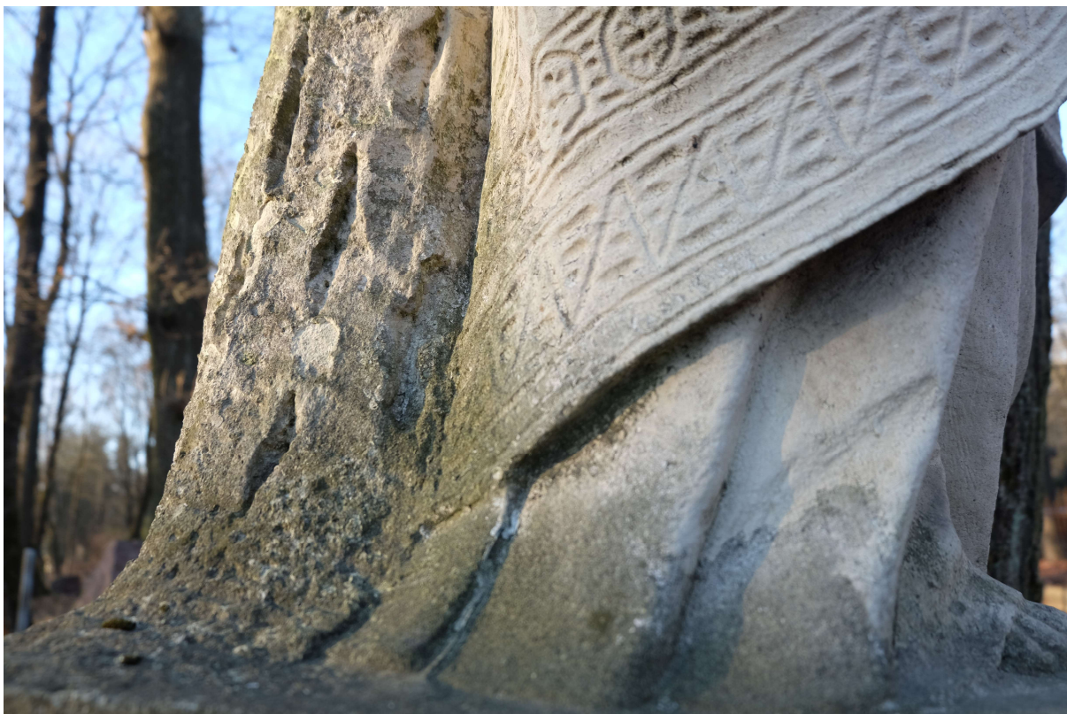
Fot nr 10. Nagrobek Wandy i Konstantego Czerwińskich z cmentarza św. Michała w Rydze, Łotwa. Fragment wapiennej rzeźby z widoczną warstwą barwną i nawarstwieniami biologicznymi. Listopad 2020 r.
