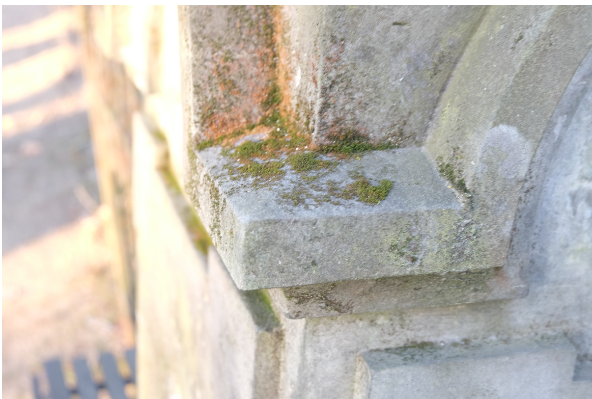
Fot nr 6. Nagrobek Wandy i Konstantego Czerwińskich z cmentarza św. Michała w Rydze, Łotwa. Fragment cokołu z widocznymi nawarstwieniami organiczne, biologiczne i mikrobiologiczne. Listopad 2020 r.
