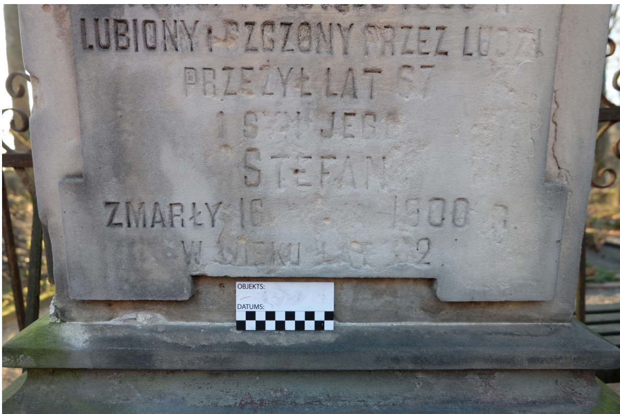
Fot nr 9. Nagrobek Wandy i Konstantego Czerwińskich z cmentarza św. Michała w Rydze, Łotwa. Fragment cokołu z widocznymi złuszczeniami i dezintegracją granularną. Listopad 2020 r.
