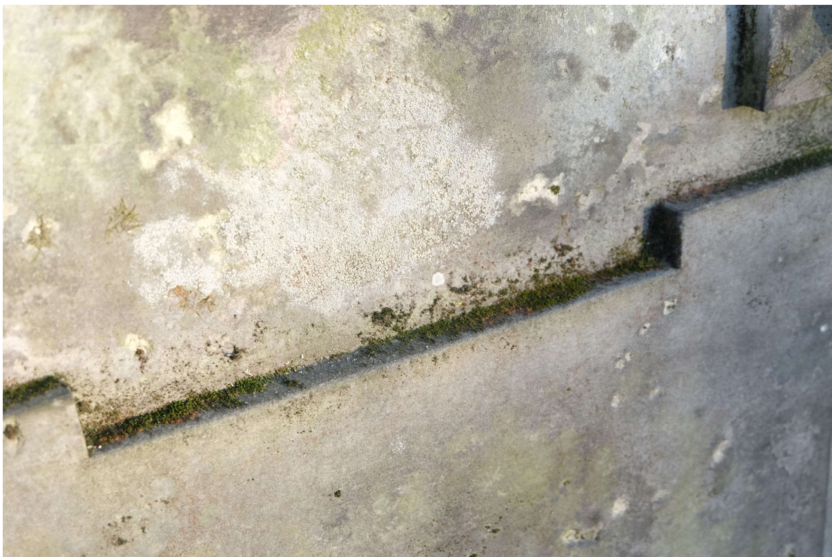
Fot nr 5. Nagrobek Wandy i Konstantego Czerwińskich z cmentarza św. Michała w Rydze, Łotwa. Fragment płyciny z widocznymi nawarstwieniami chemicznymi oraz biologicznymi (mchy). Listopad 2020 r.
