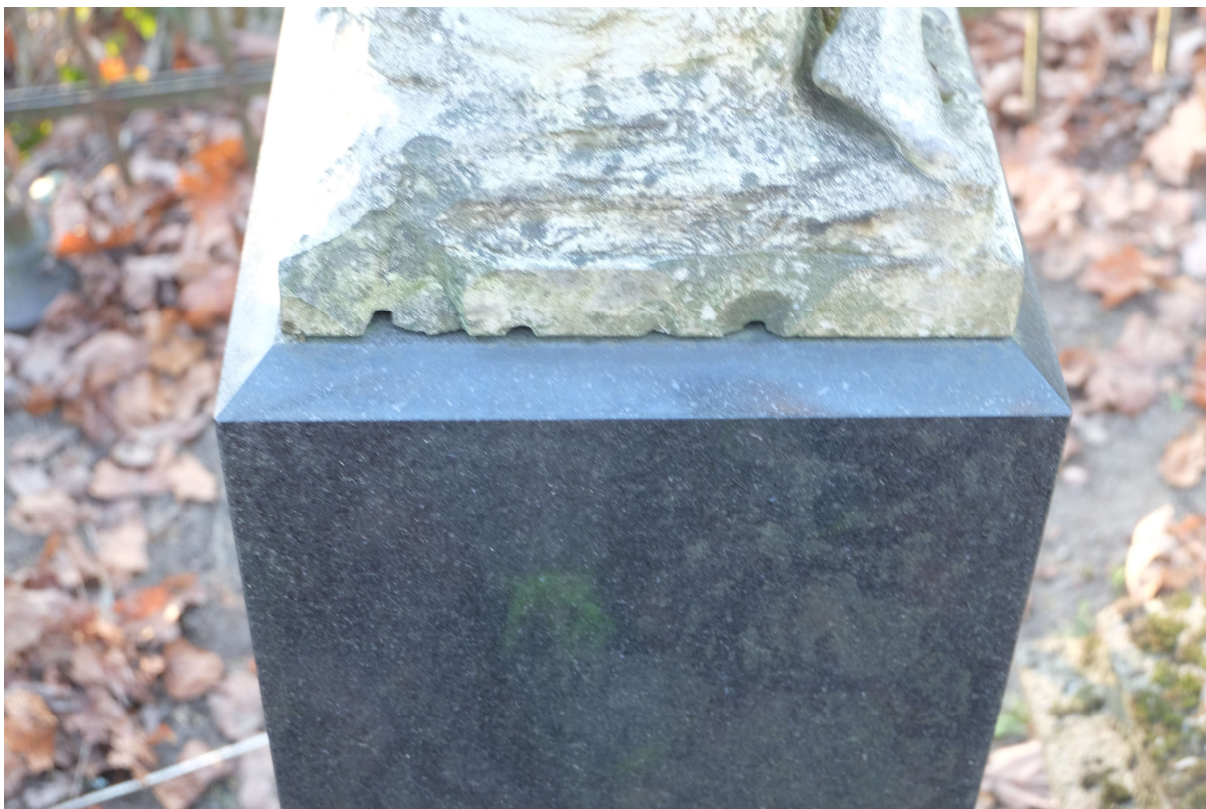
Fot 5. Nagrobek Koci i Lali Szyksznisówien z cmentarza św. Michała w Rydze, na Łotwie. Widoczne ubytki formy. Listopad 2020 r.
