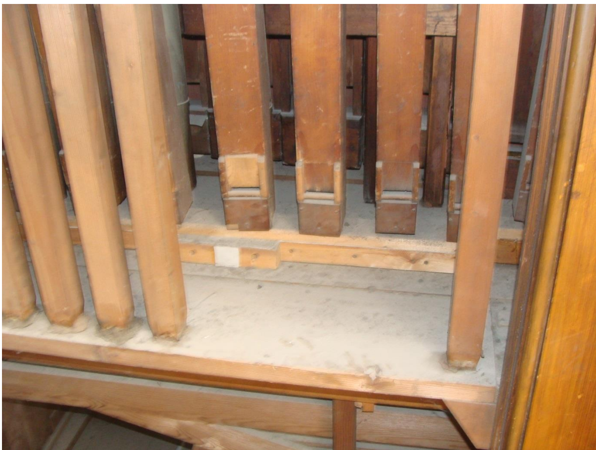
il. 25. Sekcja klawiatury nożnej, na pierwszym planie konduktu do Pryncypału
