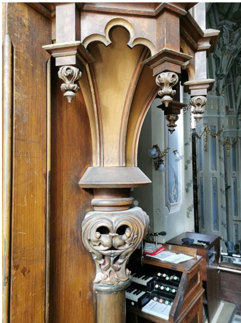
Zniszczenia powierzchni szafy i prospektu. Partie malowane.
