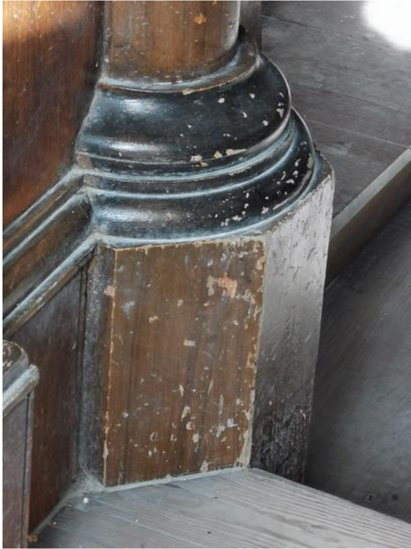
Zniszczenia powierzchni szafy i prospektu.
