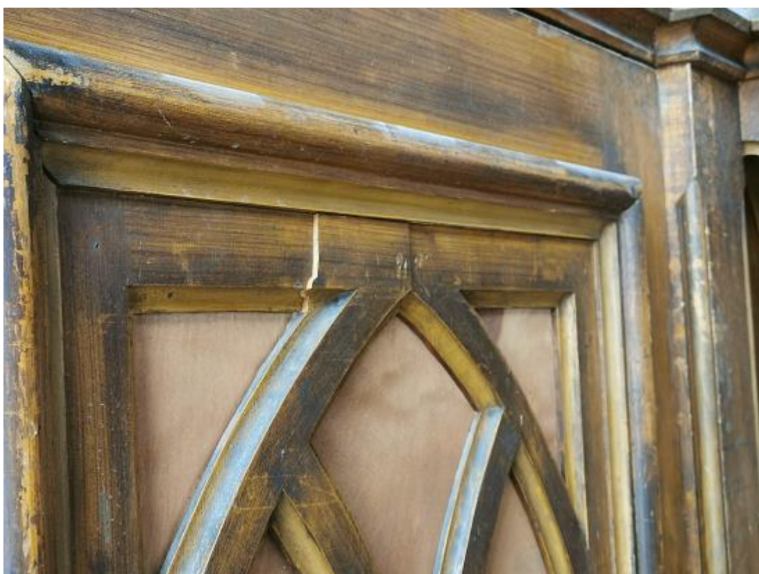
Zniszczenia powierzchni szafy i prospektu.
