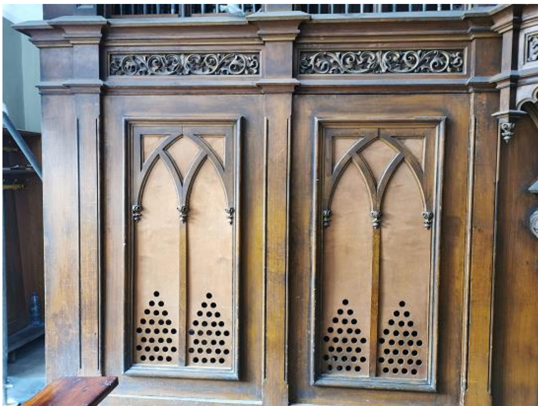
Wtórne płyciny drzwi szafy /przeznaczone do wymiany.
