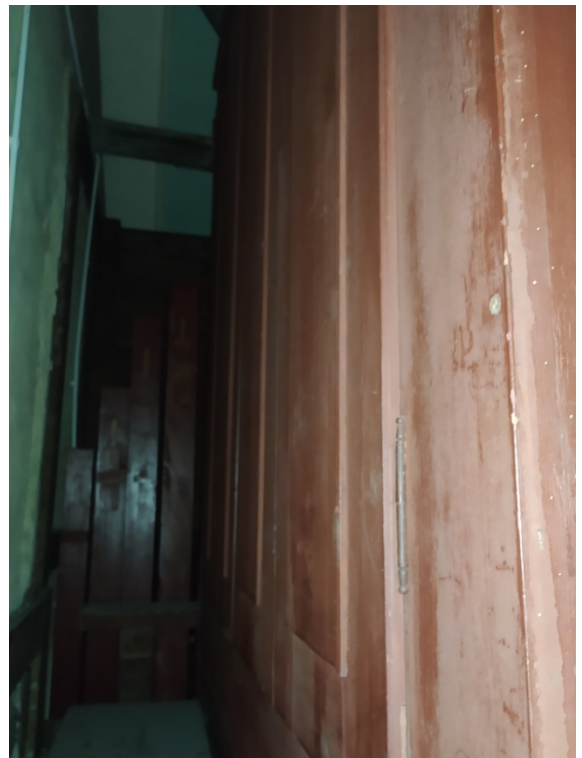
38. Tylna ściana szafy ekspresyjnej.
