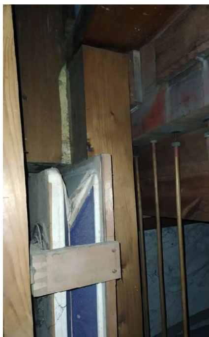
44. Amortyzator pionowy.
