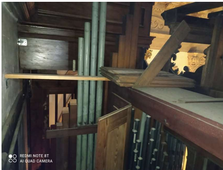
65. Dach szafy ekspresyjnej i zdeponowane po lewej stronie trzy przednie płyciny.
