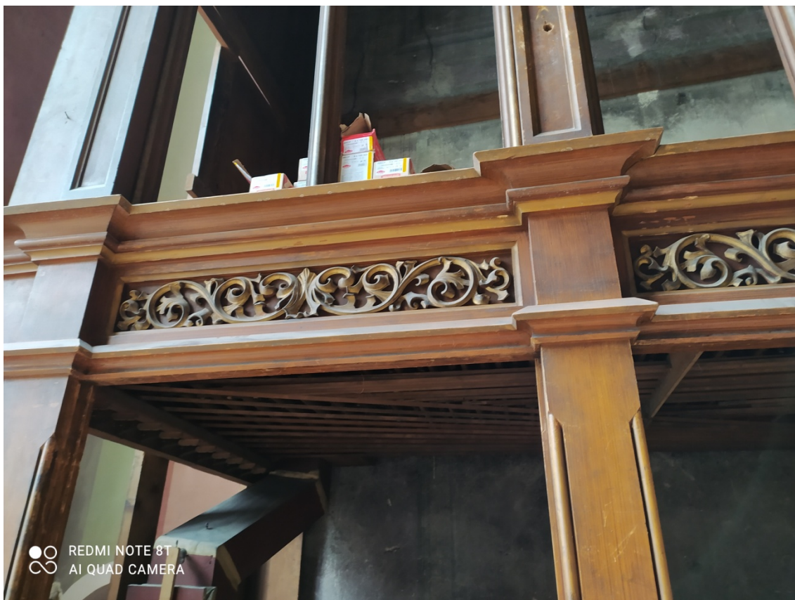
96. i 97. Cokół szafy – miejsce sekcji II manualu po demontażu piszczałek i płytin.
