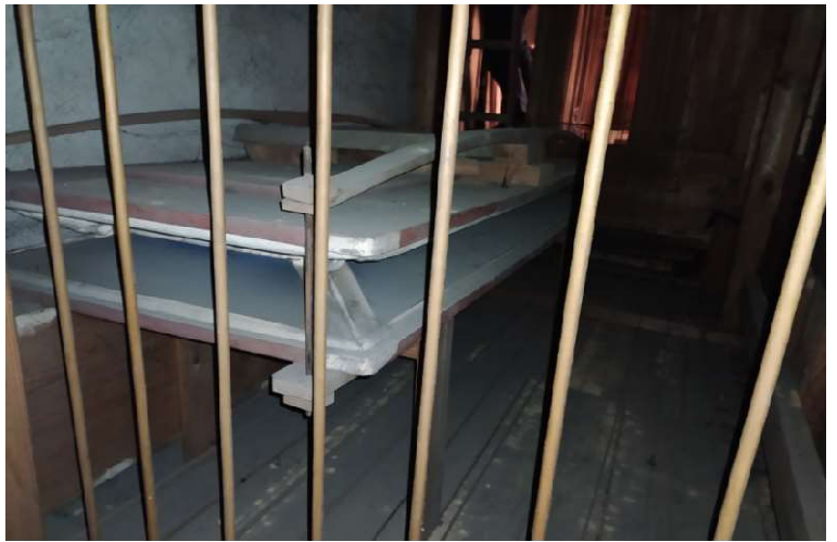
43. Amortyzator poziomy w szafie manualów. Widok od strony kanałów pionowych.
