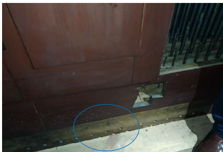
68. Sposób zamontowania szafy względem wiatrownicy. Ścianki szafy spoczywają na ramie wałków skrętnych.
