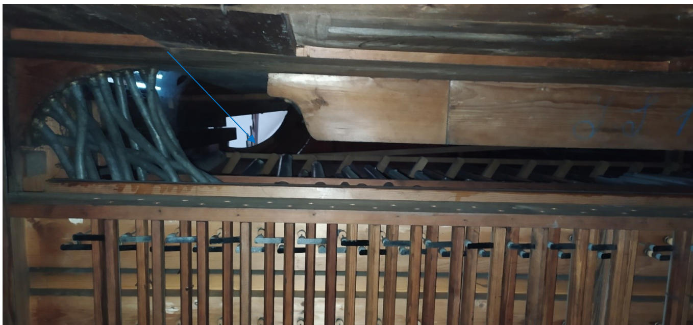
16. Fragment ramy wałków pod wiatrownicą II manualu. Powyżej widoczny mechanizm uchylonej szafy.
