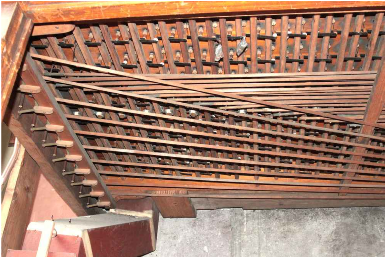
Widok detali Wałki tonowe wiatrownicy I Manuału oraz traktura rejestrowa
