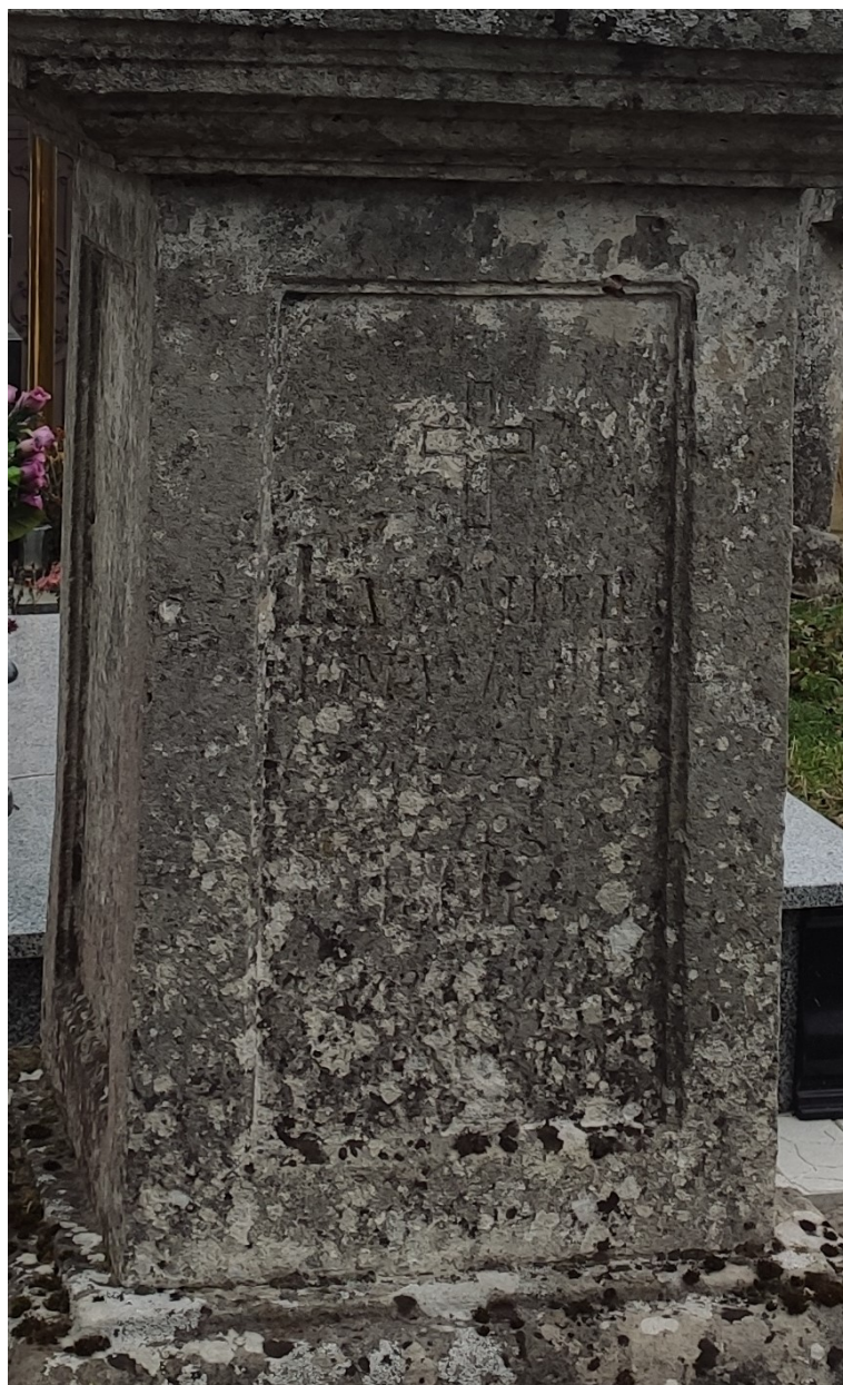
Fot. nr 12. Nagrobek Maryi Tomaszewicz z Cmentarza Bazyliańskiego w Krzemieńcu, Ukraina. Płycina z inskrypcją, lewy bok. Widoczne liczne kolonie mikroorganizmów (szczególnie mchy i porosty), ubytki warstwy powierzchniowej. Stan z grudnia 2020 roku.
