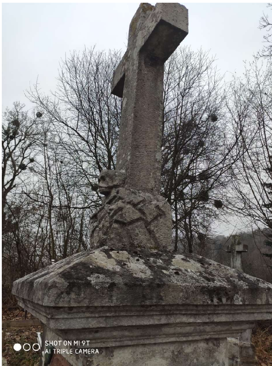
Fot. nr 4. Nagrobek Maryi Tomaszewicz z Cmentarza Bazyliańskiego w Krzemieńcu, Ukraina. Widoczna górna część nagrobka z prawej strony. Stan z grudnia 2020 roku.
