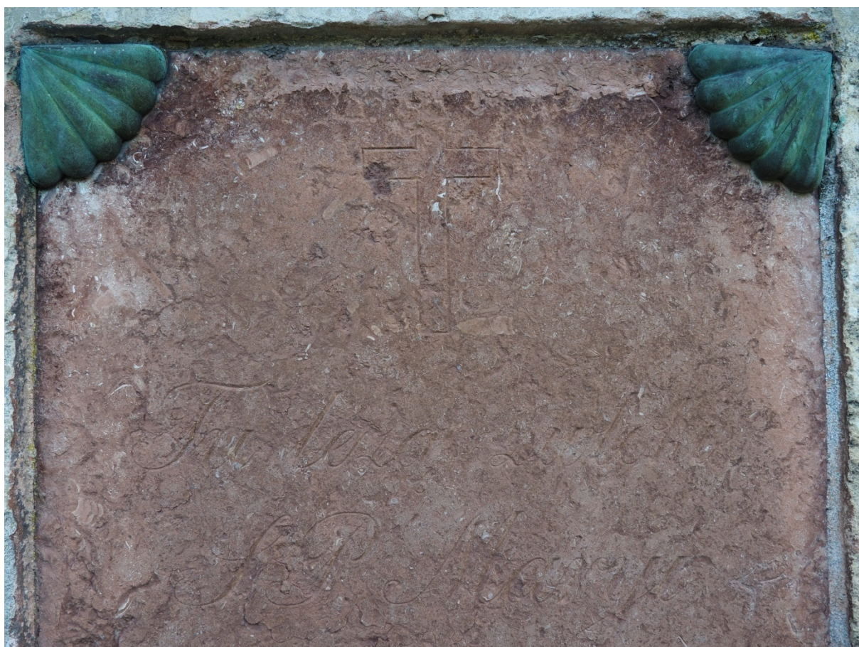
Fot. nr 8. Nagrobek Maryi Tomaszewicz z Cmentarza Bazyliańskiego w Krzemieńcu, Ukraina. Górna część płyty inskrypcyjnej z wapienia zbitego, front. Widoczna utrata poleru, ubytki warstwy powierzchniowej, zwiędzelina, zielone nawarstwienia chemiczne na elementach metalowych. Stan z października 2020 roku.
