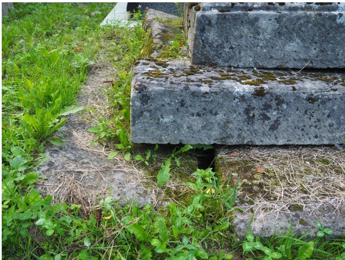
Fot. nr 16. Nagrobek Maryi Tomaszewicz z Cmentarza Bazyliańskiego w Krzemieńcu, Ukraina. Fragment stopni podstawy, lewy bok. Widoczne przesunięcia bloków kamiennych, liczne kolonie mikroorganizmów (szczególnie mchy i porosty). Stan z października 2020 roku.
