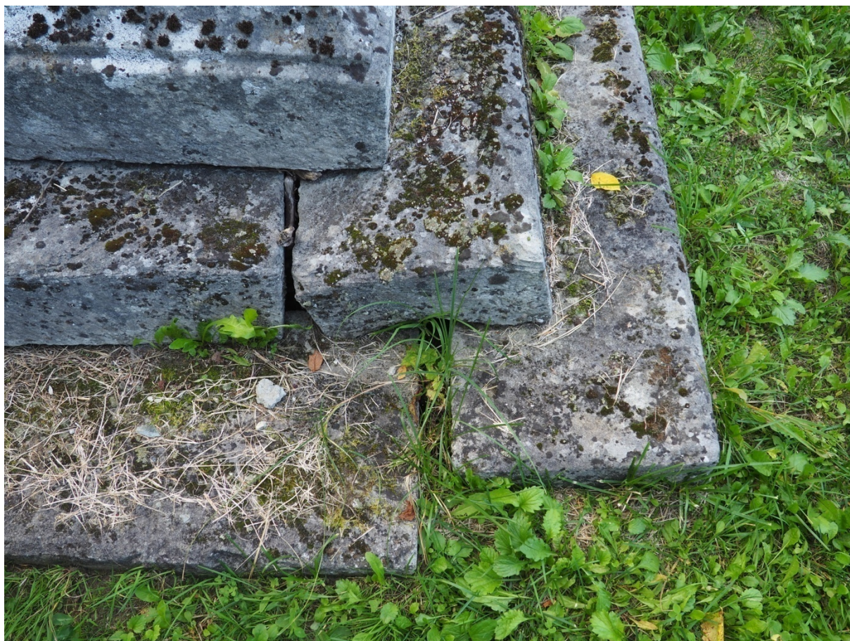
Fot. nr 15. Nagrobek Maryi Tomaszewicz z Cmentarza Bazyliańskiego w Krzemieńcu, Ukraina. Fragment stopni podstawy, tył. Widoczne przesunięcia bloków kamiennych, liczne kolonie mikroorganizmów (szczególnie mchy i porosty). Stan z października 2020 roku.
