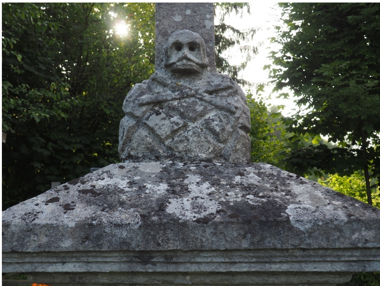
Fot. nr 14. Nagrobek Maryi Tomaszewicz z Cmentarza Bazyliańskiego w Krzemieńcu, Ukraina. Fragment z e skałkami i czaszką. Widoczne liczne kolonie mikroorganizmów (szczególnie mchy i porosty), ubytki warstwy powierzchniowej. Stan z października 2020 roku.
