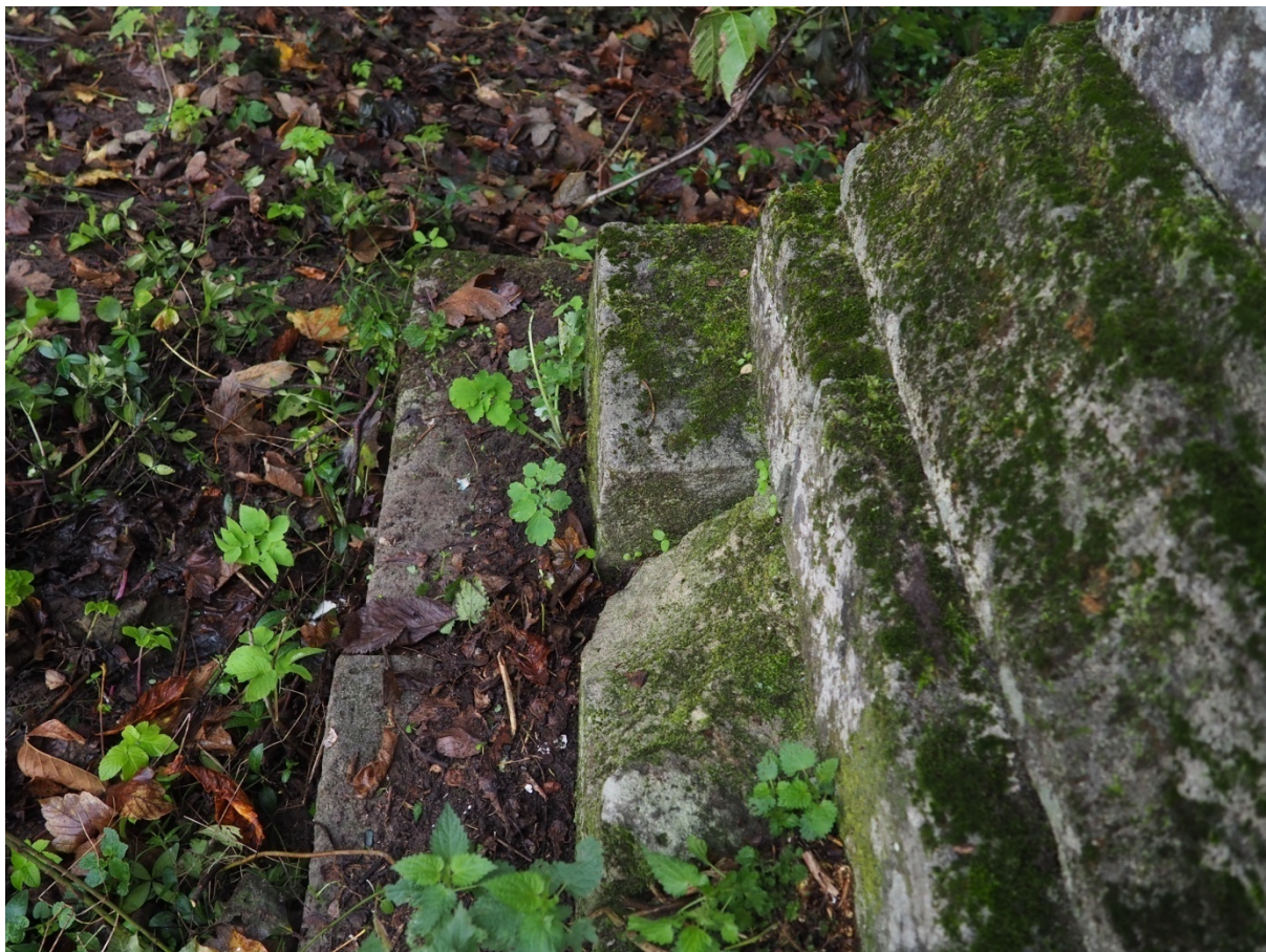
Fot. nr 12. Nagrobek Kamilli Malindowskiej- Cholodeckiej z Cmentarza Bazyliańskiego w Krzemieńcu, Ukraina. Fragment podstawy z prawej strony, widoczne nawarstwienia biologiczne (liczne skupiska mchów) oraz ubytek materiału skalnego. Stan z października 2020 roku.
