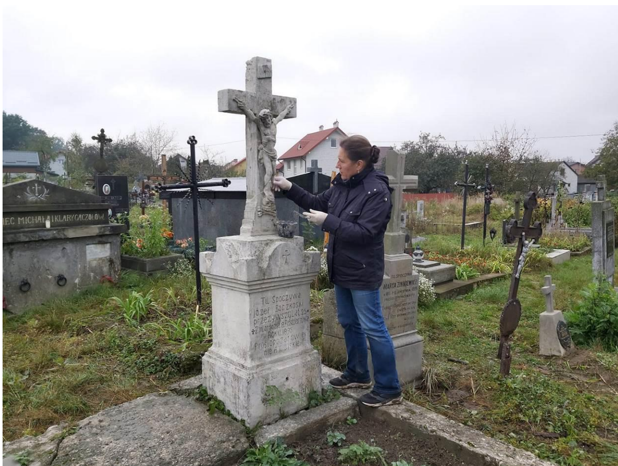
Fot. 30 Konserwatorskie uzupełnianie ubytków przez Jolę
