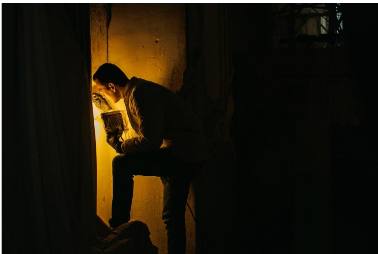
Fot. 20. Poszerzanie odkrywek warstw barwnych po prawej stronie portalu, w lewej nawie kościoła. Fot. Wawrzyniec Skoczylas.
