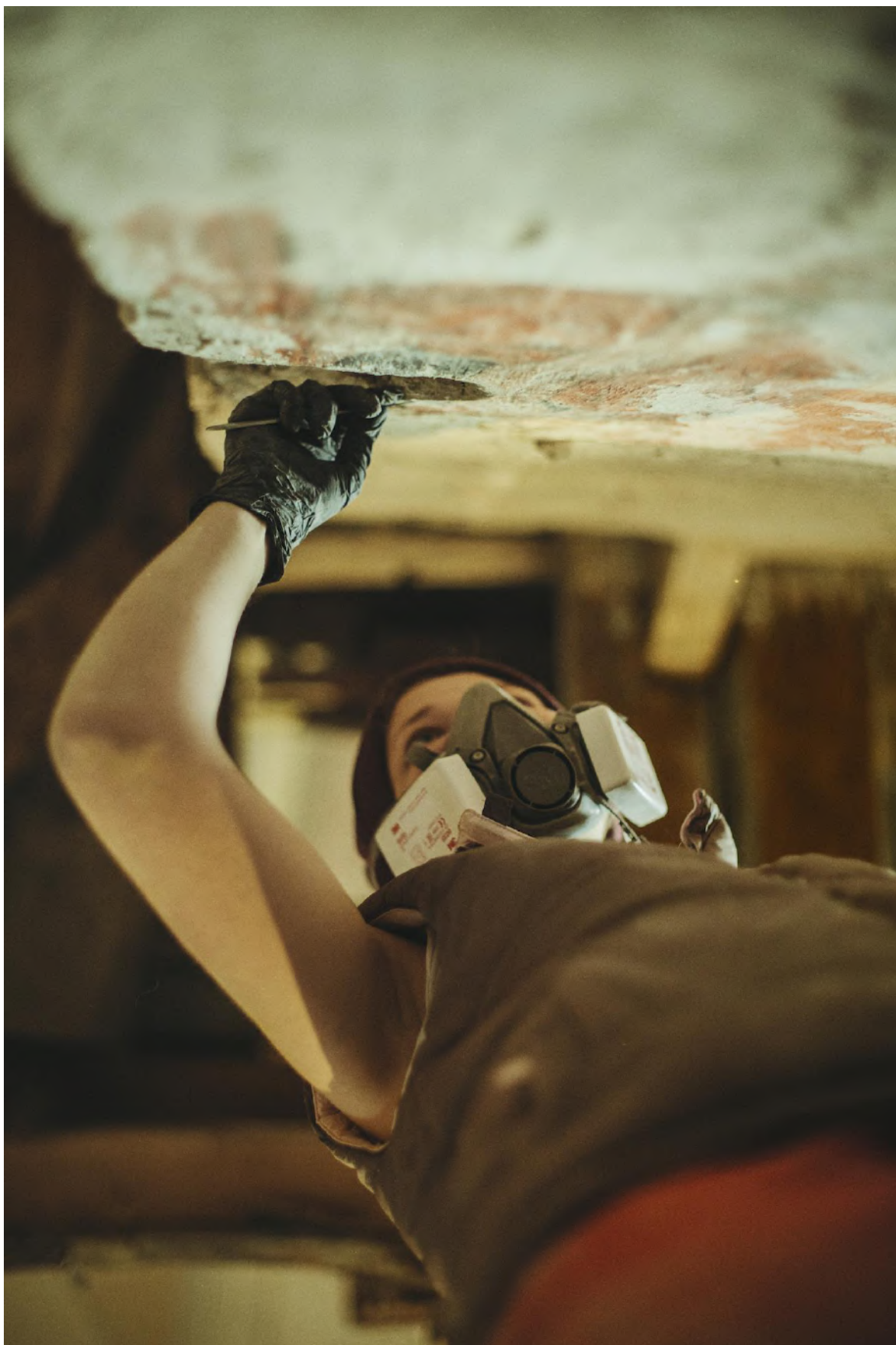
Fot. 48. Wykonywanie odkrywki na zachodniej ścianie filara w prawej nawie kościoła, pod chórem. Fot. Wawrzyniec Skoczylas.
