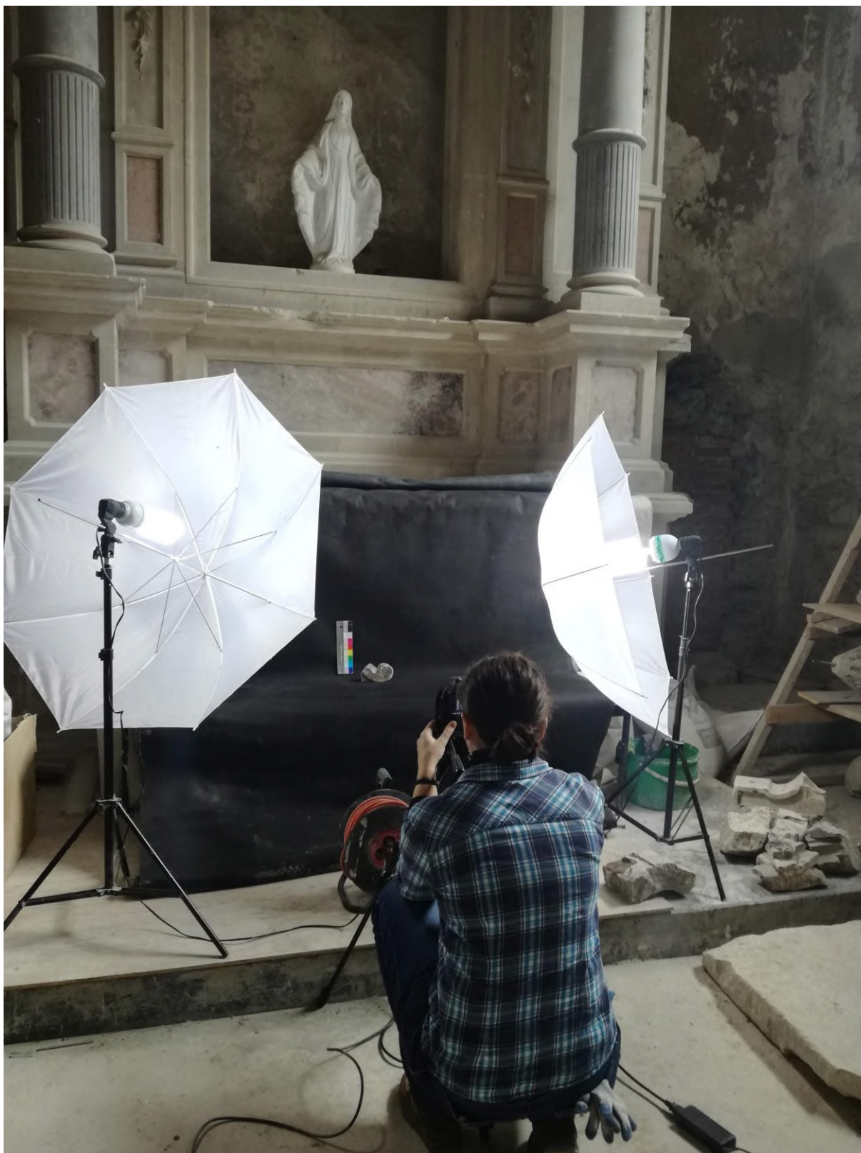
Fot. 11. Prace inwentaryzacyjne przy alabastrowych fragmentach ołtarza głównego. Fot. Anna Kudzia.
