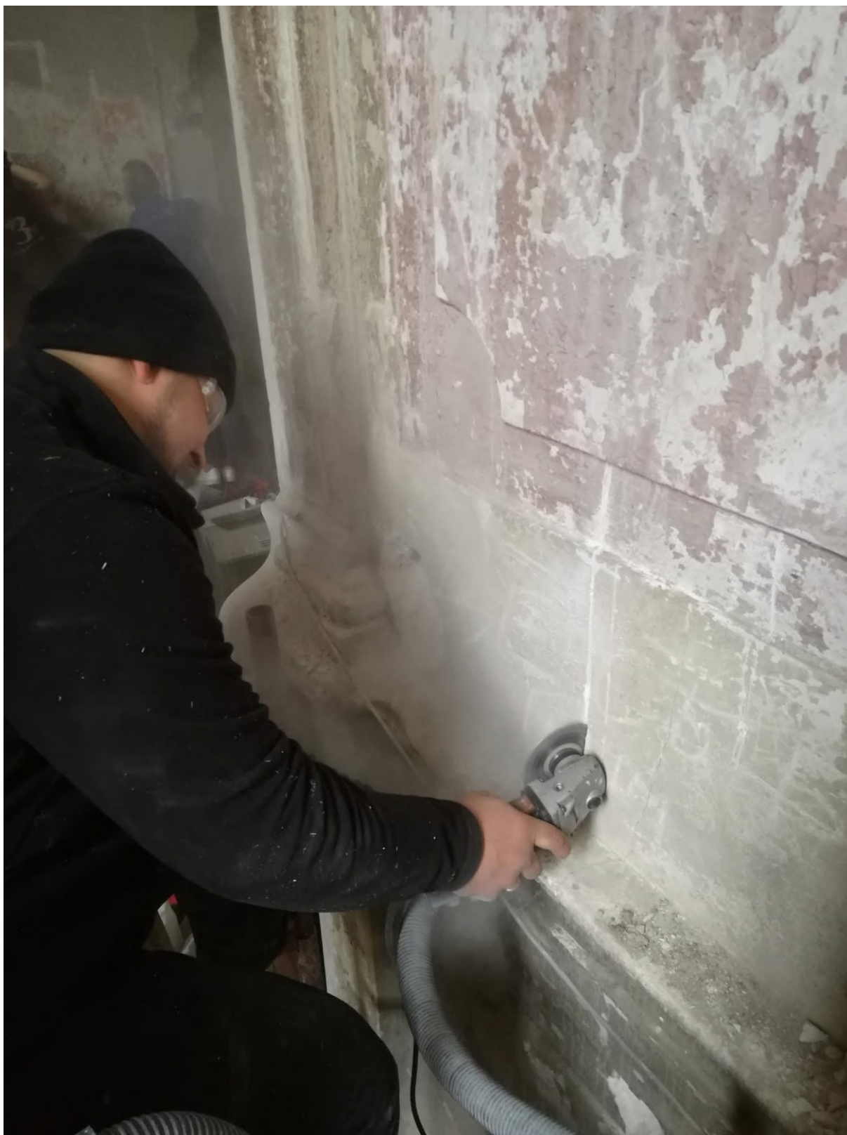
Fot. 46. Nacinanie grubego tynku szlifierką kątową w celu wykonania odkrywek na południowej ścianie filara w prawej nawie kościoła. Fot. Anna Kudzia.
