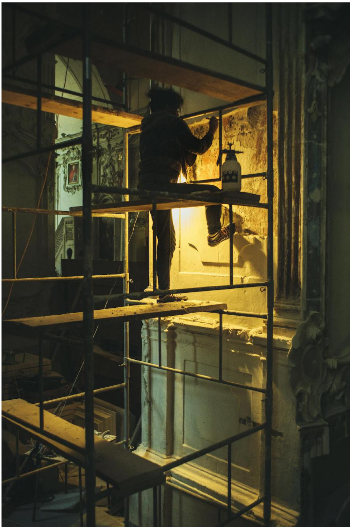
Fot. 18. Oczyszczanie odkrywek na północnej ścianie filara w lewej nawie, z pozostałości pobiał i wtórnych warstw, które nie usunięte mogłyby ulec stwardnieniu utrudniając w przyszłości zabiegi oczyszczania. Fot. Wawrzyniec Skoczylas.
