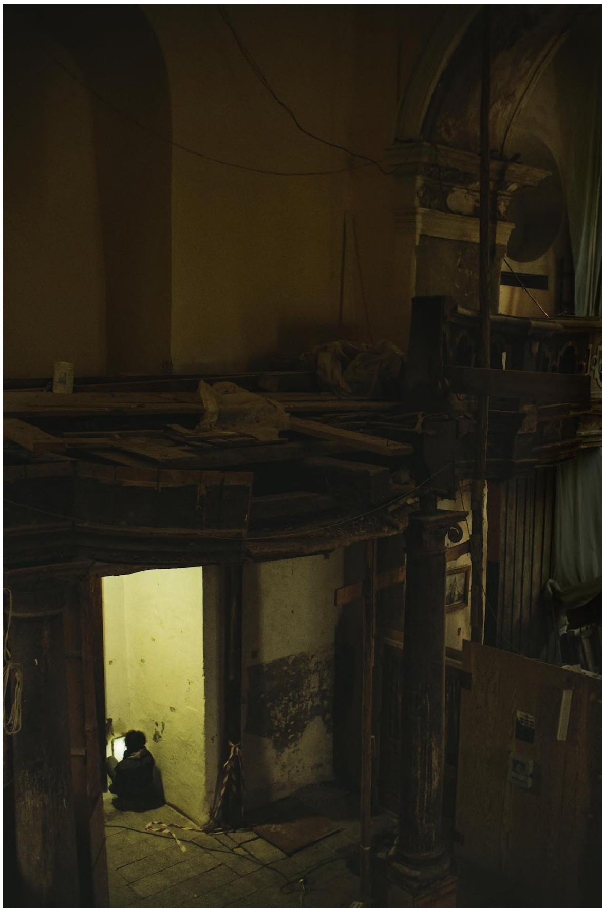
Fot. 66. Widok na zniszczony chór nad wejściem do kościoła, gdzie wykonano sondy schodkowe warstw barwnych i tynków. Fot. Wawrzyniec Skoczylas.
