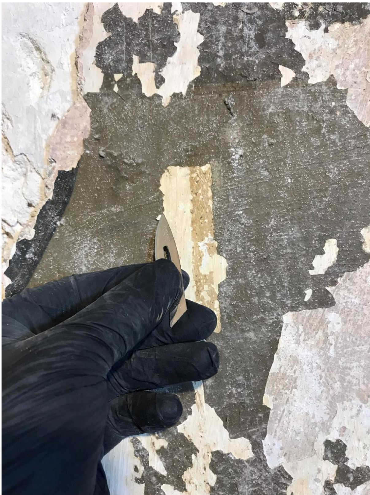
Fot. 60. Wykonywanie sondy schodkowej warstw barwnych po lewej stronie ołtarza kamiennego, w kaplicy Matki Bożej Różańcowej (z początku XVII wieku).
