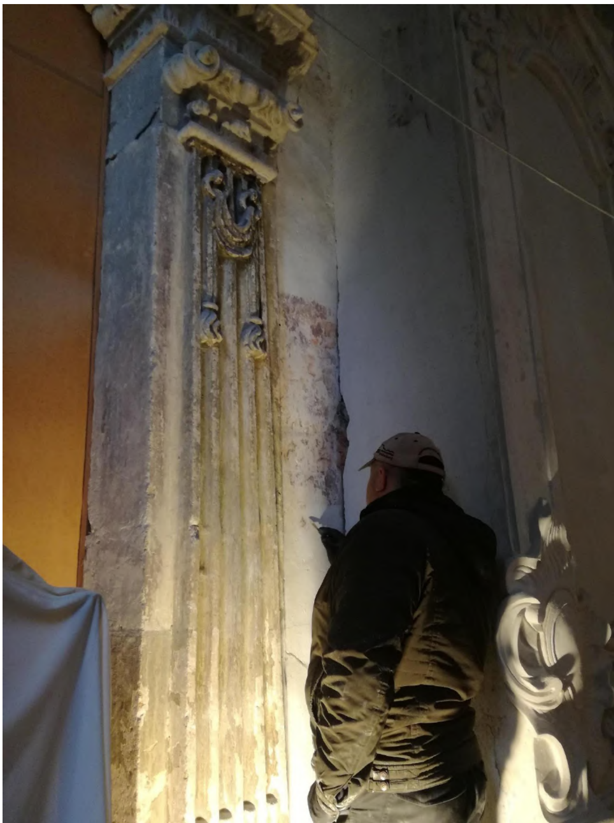
Fot. 22. Oczyszczanie odkrywek warstw barwnych po prawej stronie portalu, w lewej nawie kościoła, z pozostałości pobiał i wtórnych warstw, które nie usunięte mogłyby ulec karbonatyzacji utrudniając w przyszłości zabiegi oczyszczania. Fot. Anna Kudzia.
