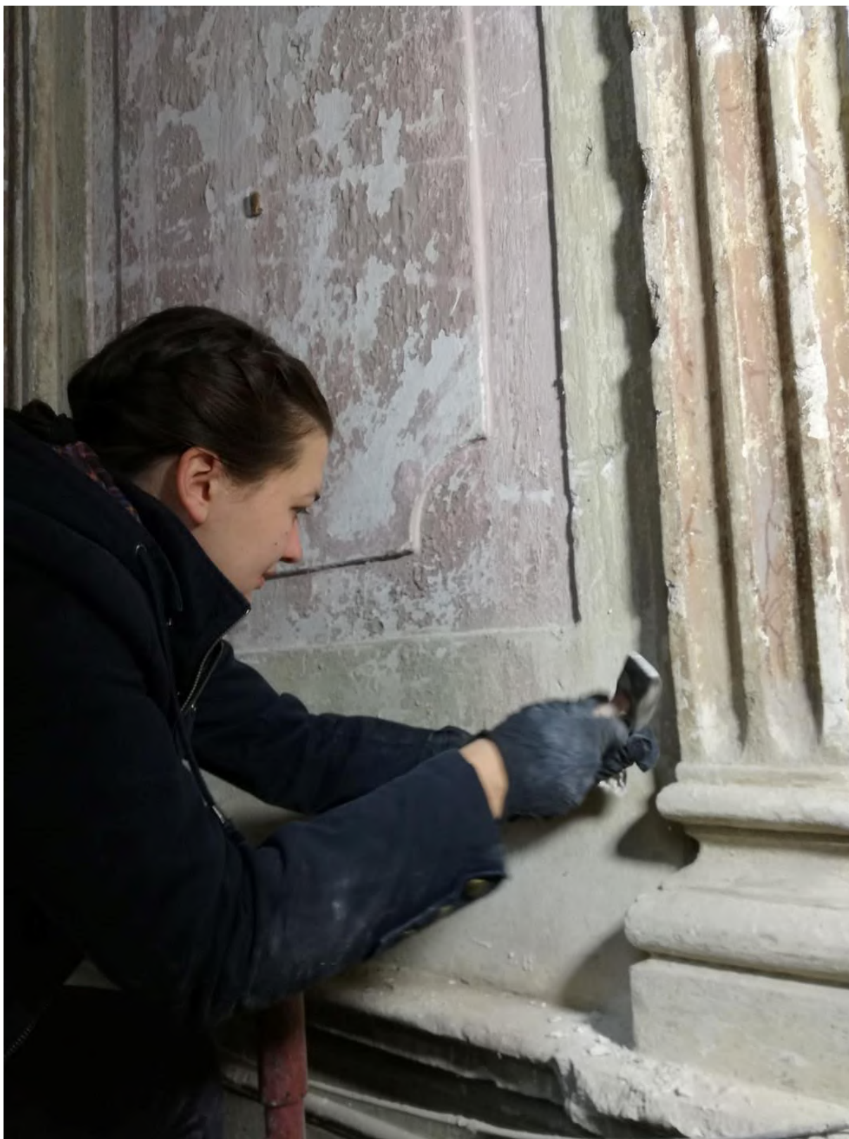
Fot. 44. Wykonywanie odkrywek na południowej ścianie filara w prawej nawie kościoła. Fot. Anna Kudzia.
