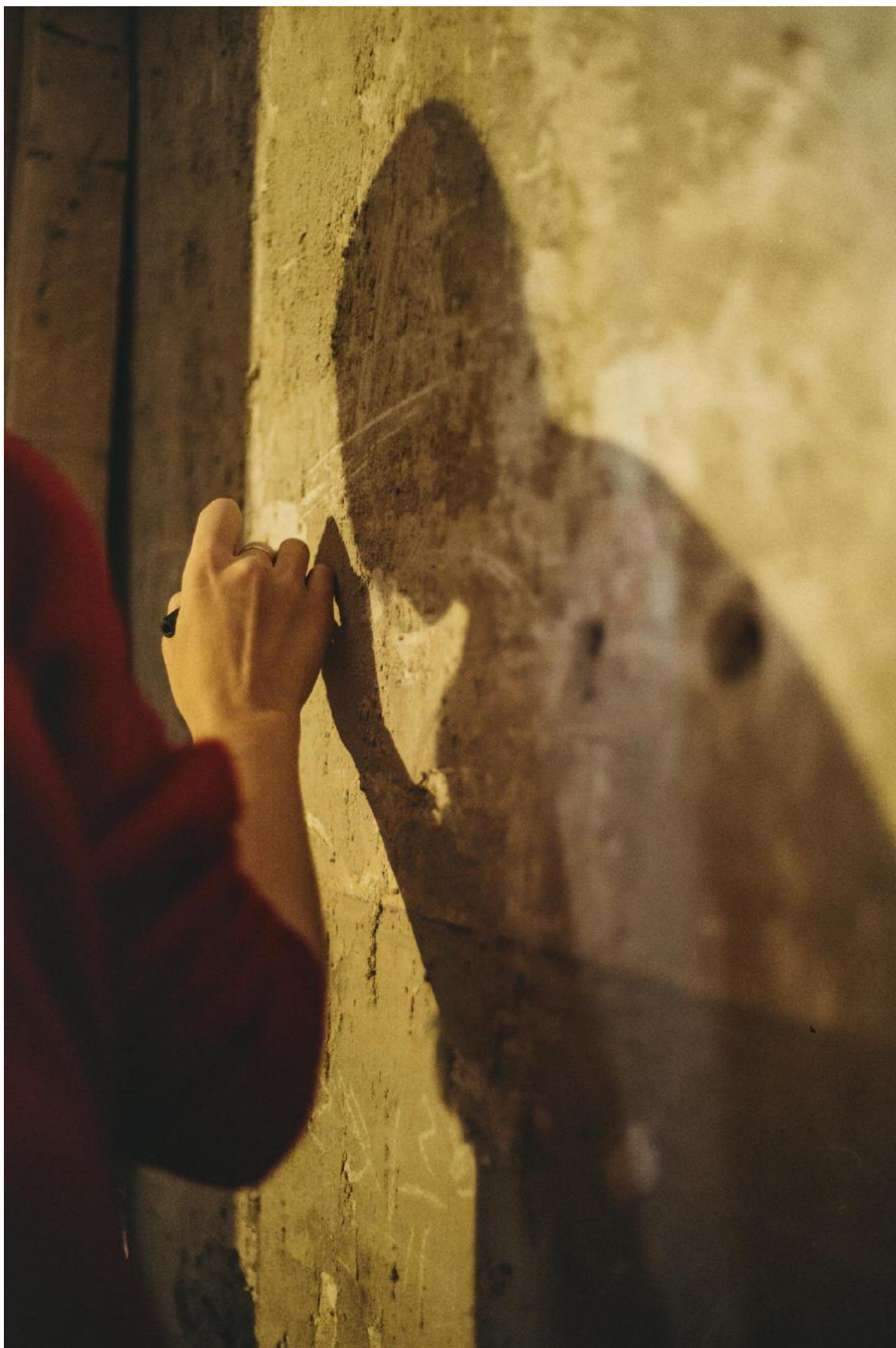
Fot. 52. Wykonywanie odkrywki na zachodniej ścianie filara w prawej nawie kościoła, pod chórem. Fot. Wawrzyniec Skoczylas.
