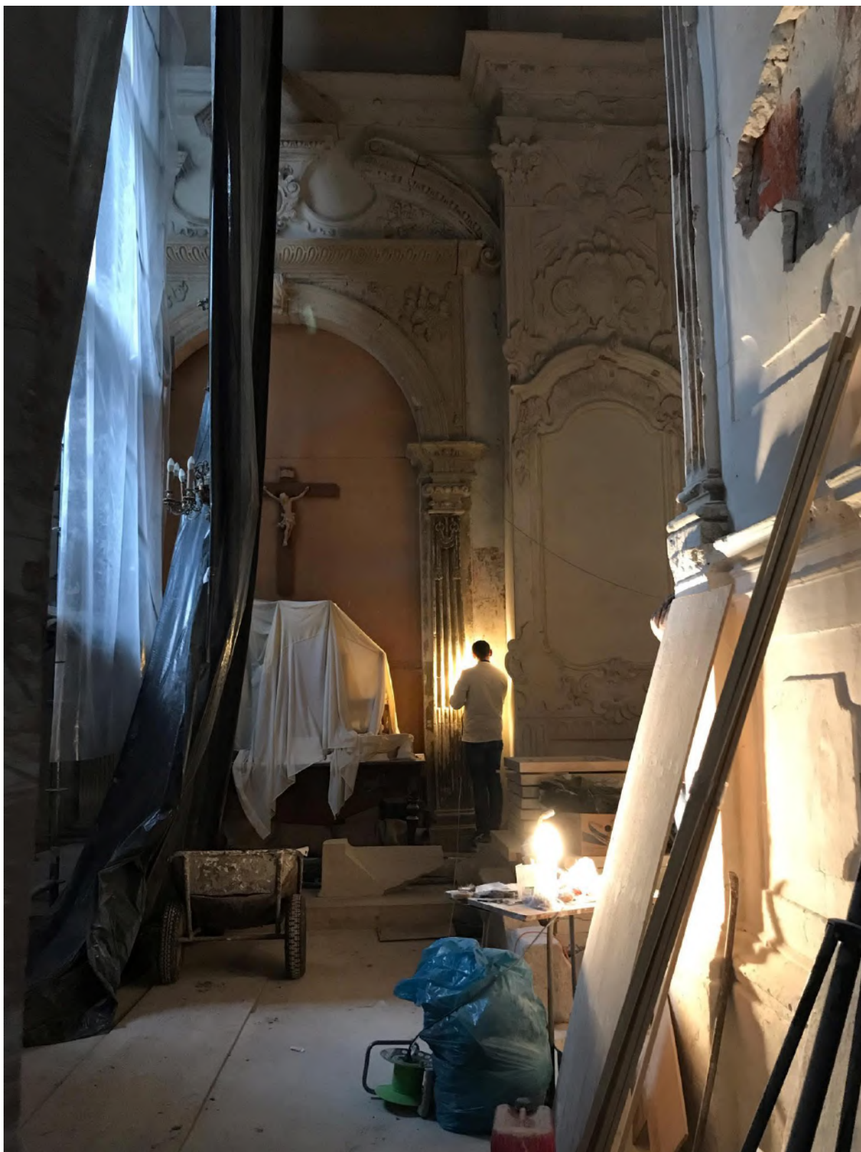
Fot. 21. Prace przy warstwach barwnych po prawej stronie portalu, w lewej nawie kościoła. Fot. Anna Kudzia.
