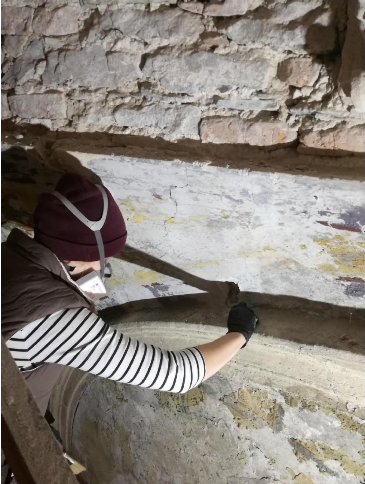
Fot. 33. Wykonywanie odkrywek schodkowych na wschodniej ścianie kaplicy Chrystusa Ukrzyżowanego. Fot. Anna Kudzia.
