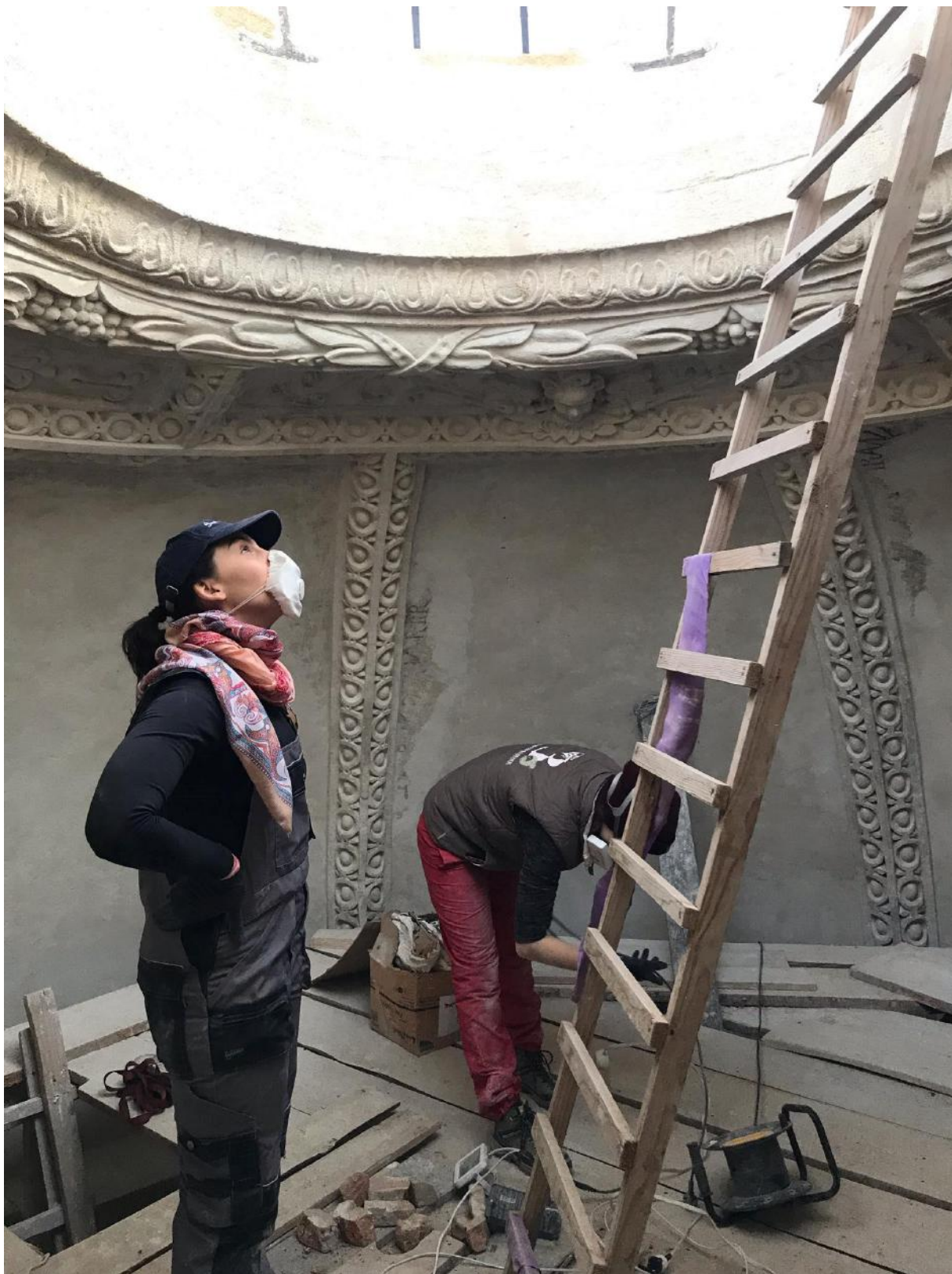
Fot. 6. Przygotowanie do prac inwentaryzacyjnych na sklepieniu kaplicy Chrystusa Ukrzyżowanego (pierwsza połowa XVII wieku). Fot. Anna Kudzia.
