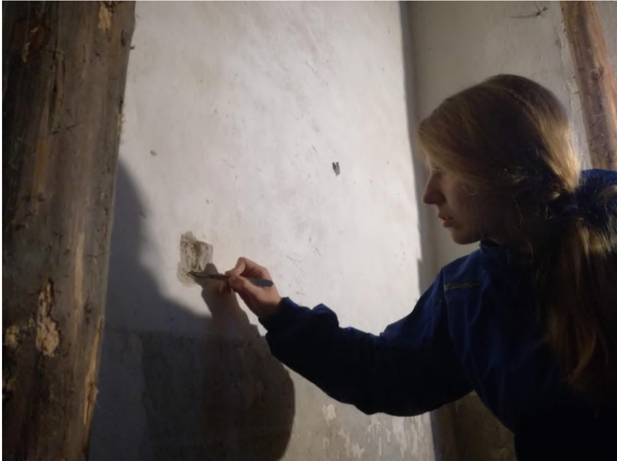
Fot. 3. Praktyczny pokaz wykonywania sondy schodkowej na zabytkowej ścianie kościoła, przy wejściu do nawy głównej z kruchty, ukazującej układ warstw tynkarskich i malarskich na ścianie. Fot. Anna Kudzia.
