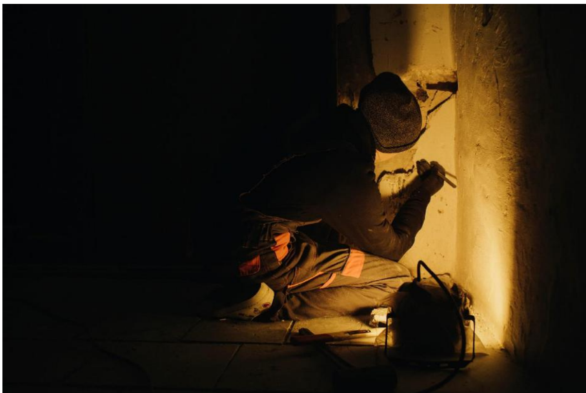
Fot. 65. Wykonywanie sondy po lewej stronie od drzwi wejściowych pod chórem. Fot. Wawrzyniec Skoczylas.
