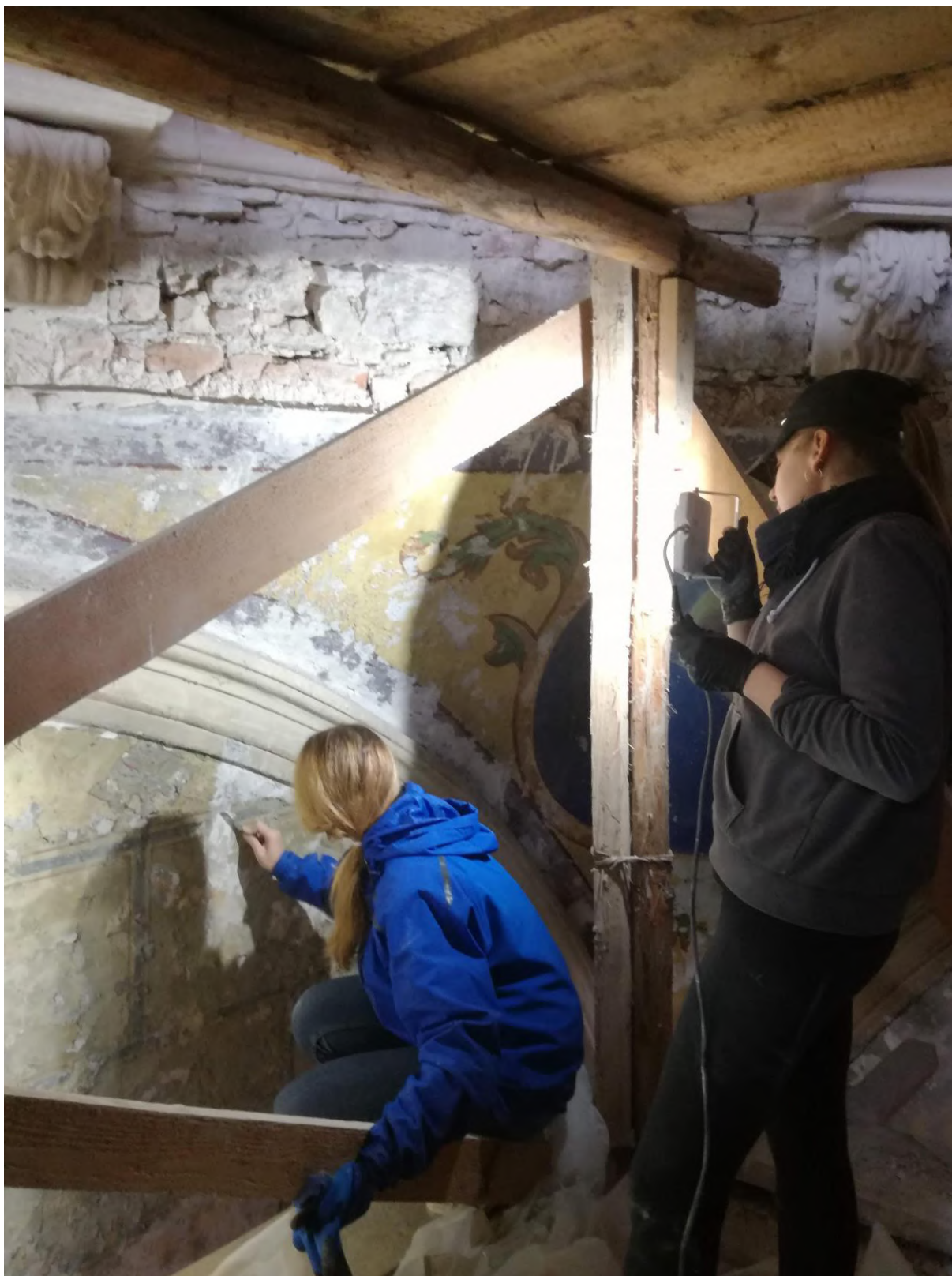
Fot. 4. Praktyczny pokaz wykonywania odkrywek schodkowych na ścianie wschodniej kaplicy Chrystusa Ukrzyżowanego (pierwsza połowa XVII wieku). Fot. Anna Kudzia.
