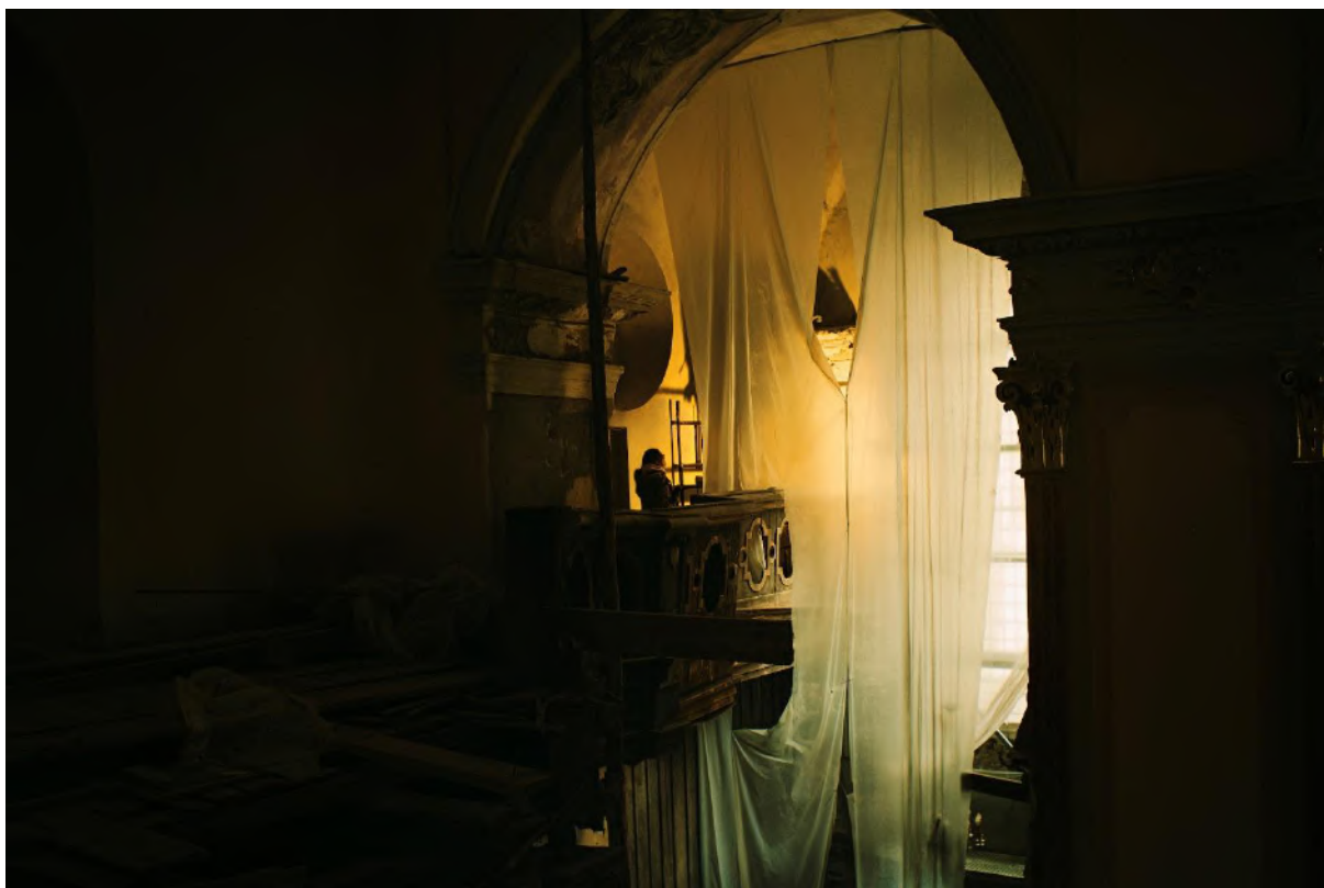
Fot. 19. Widok na lewą nawę kościoła oraz zdestruowany chór. Fot. Wawrzyniec Skoczylas.
