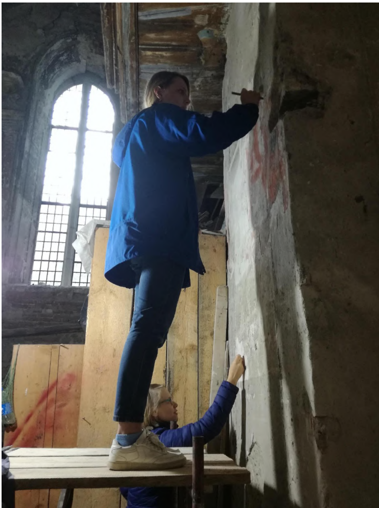
Fot. 54. Odkrywanie i oczyszczanie odnalezionego malowidła, na zachodniej ścianie filara w prawej nawie kościoła, pod chórem. Fot. Anna Kudzia.
