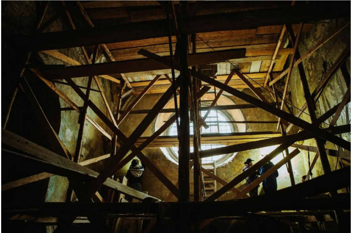
Fot. 27. Wykonywanie odkrywek na północnej ścianie kaplicy Chrystusa Ukrzyżowanego (początek XVII wieku). Fot. Wawrzyniec Skoczylas.
