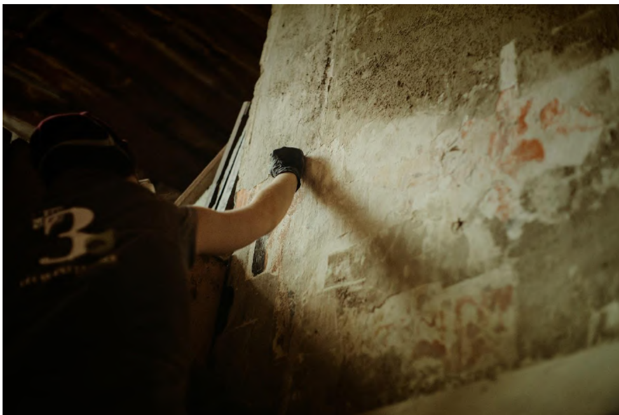
Fot. 50. Wykonywanie odkrywki na zachodniej ścianie filara w prawej nawie kościoła, pod chórem. Fot. Wawrzyniec Skoczylas.
