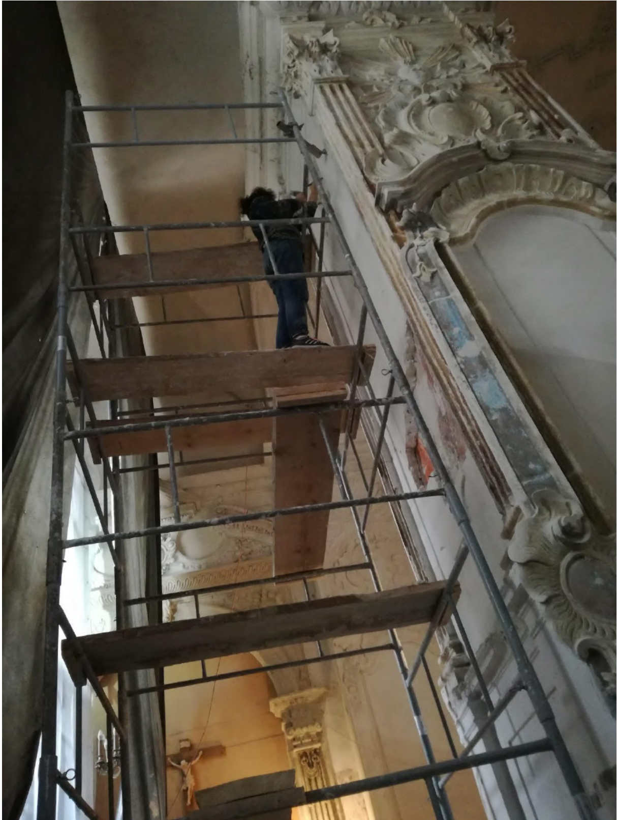
Fot. 26. Wykonywanie odkrywki na północnej ścianie filara w lewej nawie, w wyższych partiach północnej ściany filara w lewej nawie, w celu sprawdzenia zakresu pola kompozycji.
