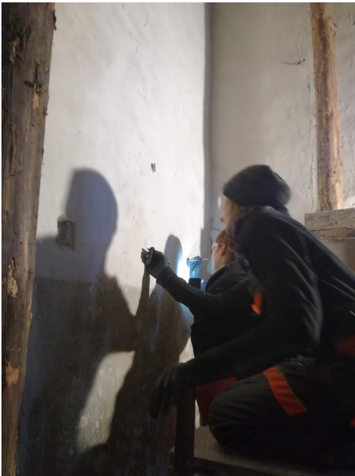
Fot. 69. Wykonywanie sondy i odkrywek stratygraficznych warstw barwnych oraz tynków po lewej stronie od drzwi wejściowych pod chórem. Fot. Anna Kudzia
