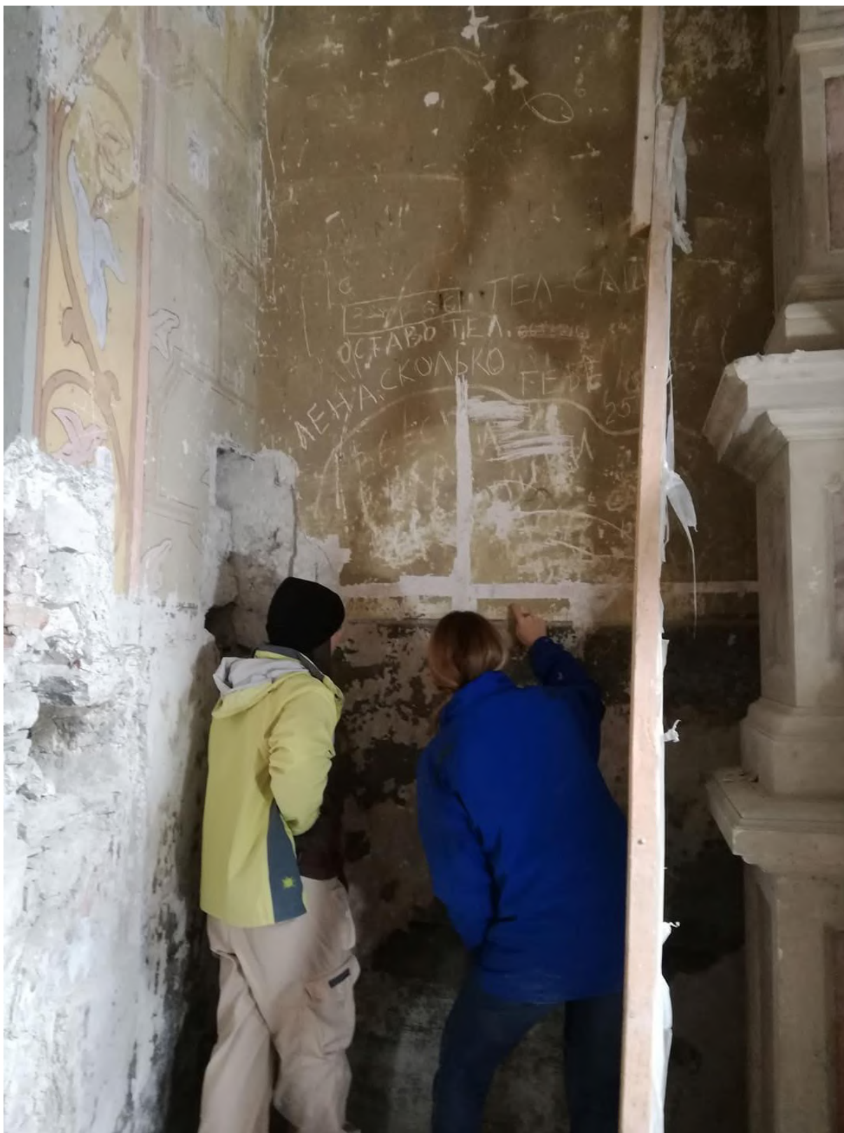
Fot. 61. Wykonywanie odkrywki pasowej i krzyżowej po lewej stronie ołtarza kamiennego, w kaplicy Matki Bożej Różańcowej (z początku XVII wieku). Fot. Anna Kudzia.
