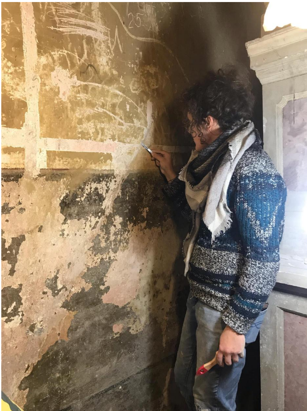
Fot. 62. Wykonywanie odkrywki pasowej i krzyżowej po lewej stronie ołtarza kamiennego, w kaplicy Matki Bożej Różańcowej (z początku XVII wieku). Fot. Andriej Savchuk.
