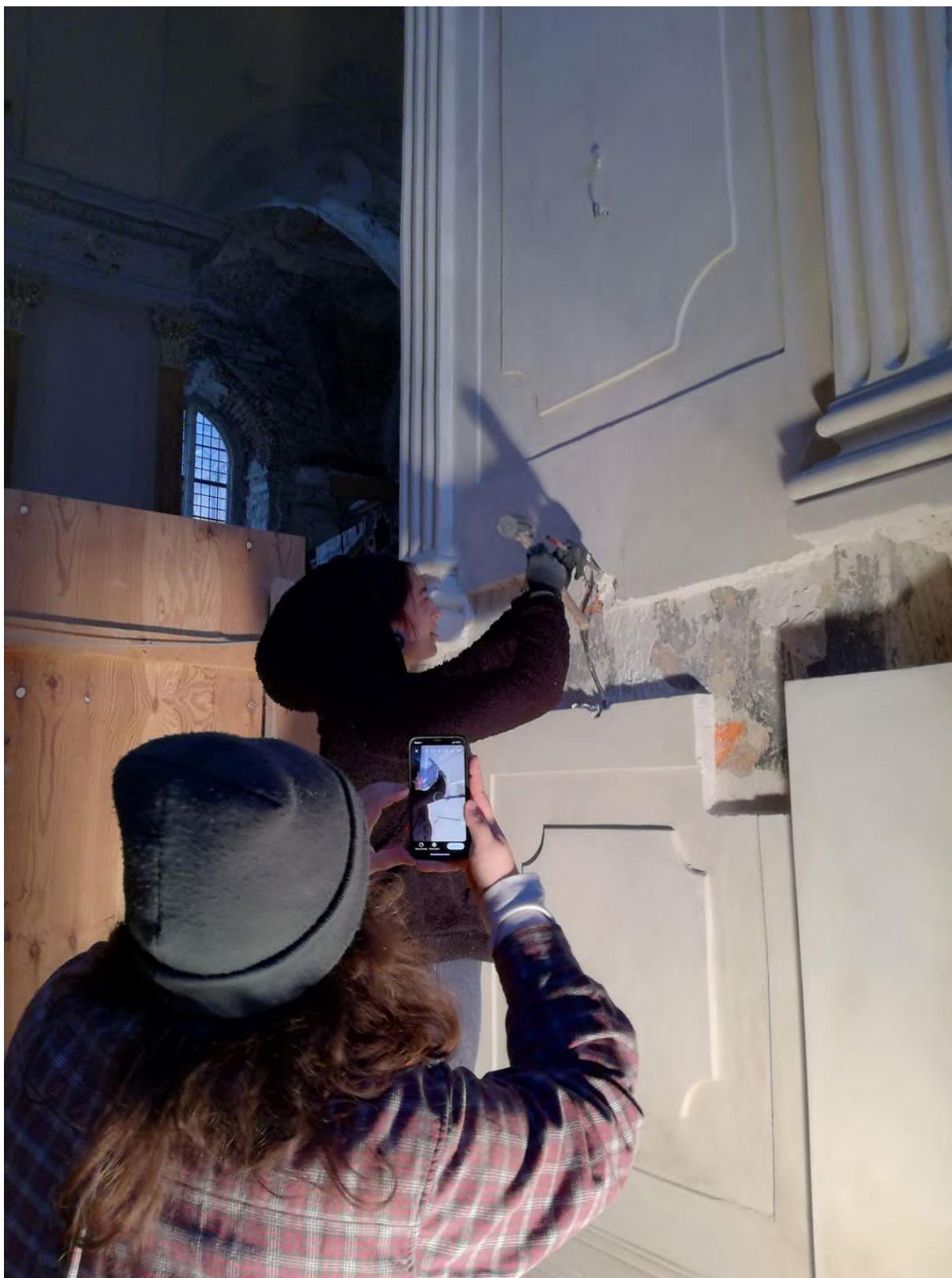
Fot. 23. Poszerzanie odkrywek warstw barwnych na wschodniej ścianie filara w lewej nawie w celu podjęcia próby identyfikacji kompozycji. Fot. Anna Kudzia.
