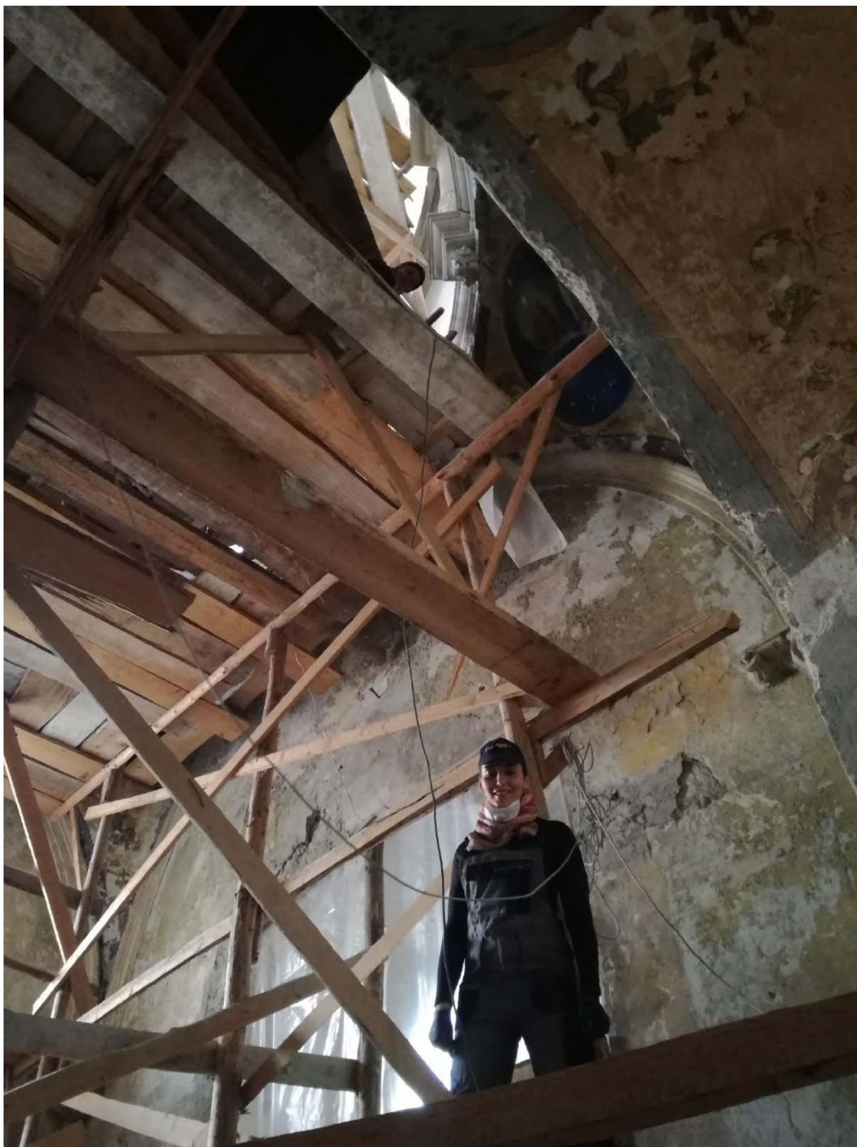
Fot. 37. Prace organizacyjne -rozkładanie elektryki w celu wykonania zdjęć inwentaryzacyjnych w kaplicy Ukrzyżowanego (początek XVII wieku). Fot. Anna Kudzia.
