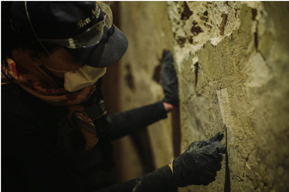
Fot. 29. Wykonywanie odkrywek na północnej ścianie kaplicy Chrystusa Ukrzyżowanego (początek XVII wieku). Fot. Wawrzyniec Skoczylas.
