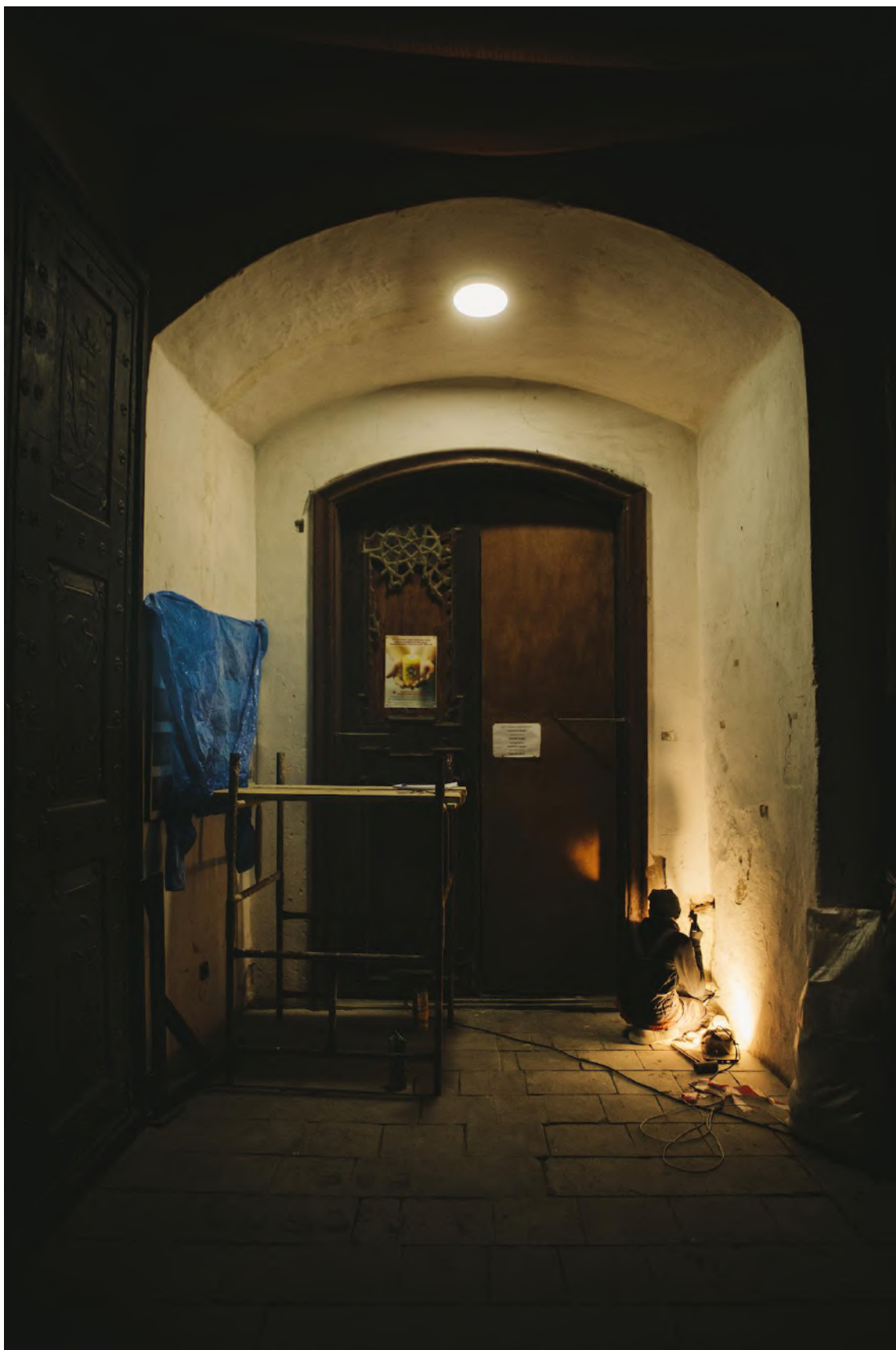
Fot. 67. Wykonywanie sondy i odkrywek stratygraficznych warstw barwnych i tynków po lewej stronie od drzwi wejściowych pod chórem. Fot. Wawrzyniec Skoczylas.
