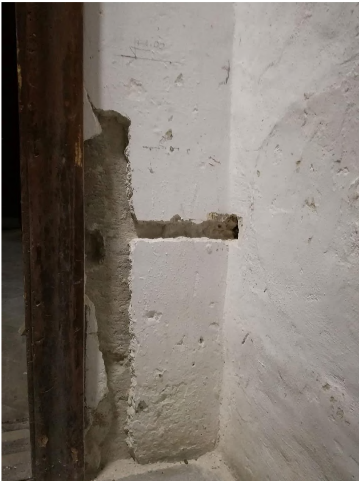
Fot. 70. Odkrywka pasowa wykonana w celu rozpoznania przebiegu płyt wapiennych, będących częścią oryginalnego portalu kamiennego. Fot. Anna Kudzia
