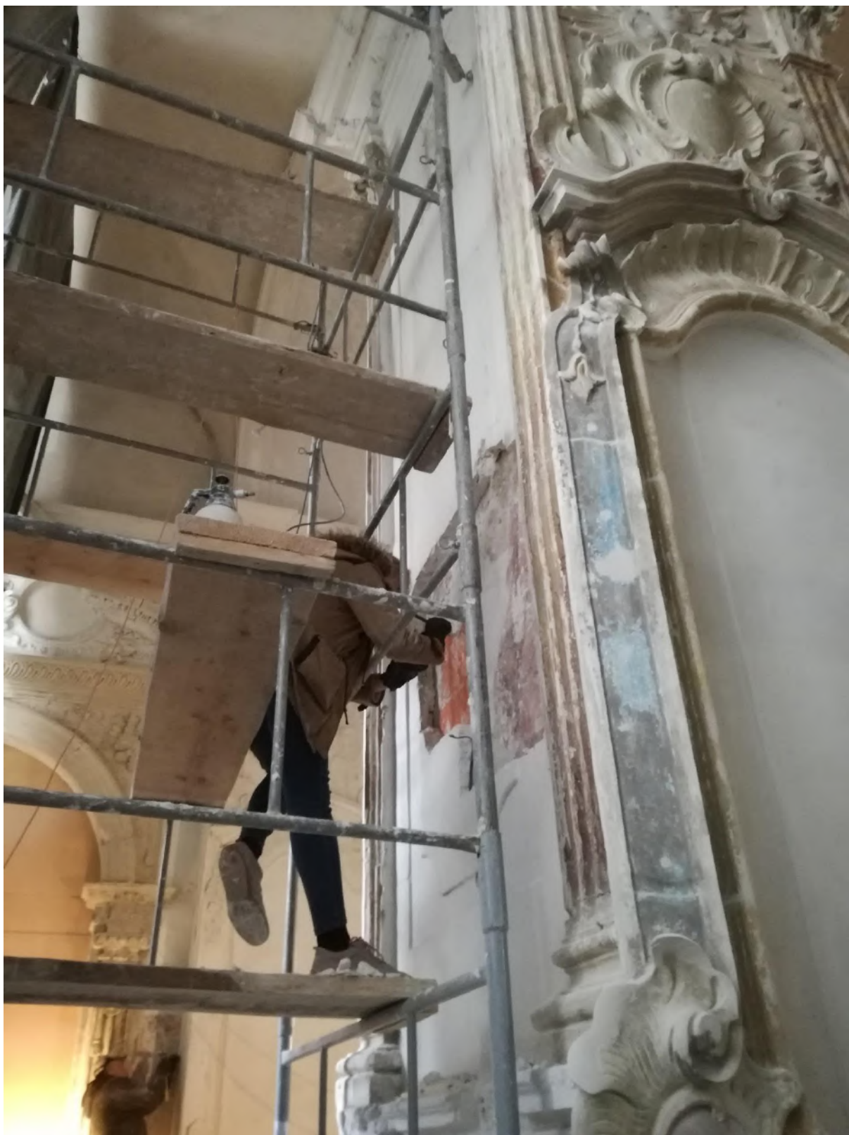
Fot. 25. Oczyszczanie odkrywek na północnej ścianie filara w lewej nawie, z pozostałości pobiał i wtórnych warstw, które nie usunięte mogłyby ulec karbonatyzacji utrudniając w przyszłości zabiegi oczyszczania. Fot. Anna Kudzia.
