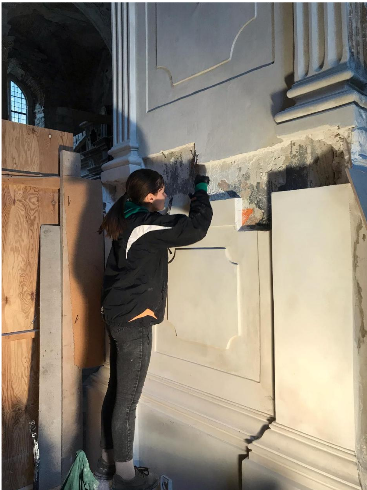
Fot. 24. Oczyszczanie odkrywek warstw barwnych na wschodniej ścianie filara w lewej nawie, z pozostałości pobiał i wtórnych warstw, które nie usunięte mogłyby ulec karbonatyzacji utrudniając w przyszłości zabiegi oczyszczania. Fot. Anna Kudzia.
