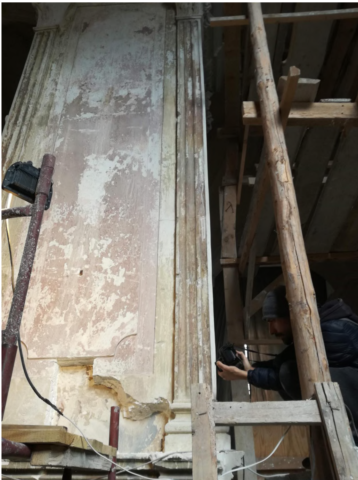
Fot. 47. Dokumentacja fotograficzna odkrywki na południowej ścianie filara w prawej nawie kościoła. Fot. Anna Kudzia.
