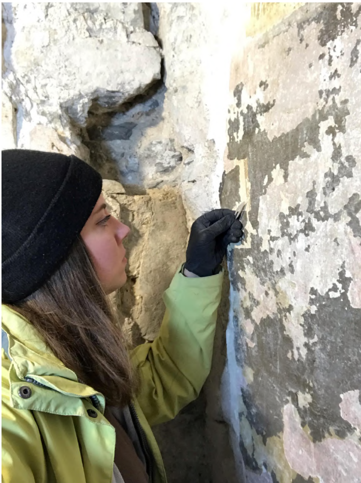
Fot. 59. Wykonywanie sondy schodkowej warstw barwnych po lewej stronie ołtarza kamiennego, w kaplicy Matki Bożej Różańcowej (z początku XVII wieku).
