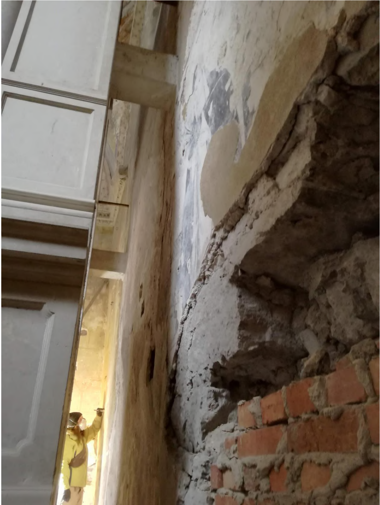
Fot. 63. Wykonywanie odkrywki po lewej stronie ołtarza kamiennego w kaplicy Matki Bożej Różańcowej (z początku XVII wieku) na ścianie z malowidłem ukazującym Katarzynę Sieneńską.
