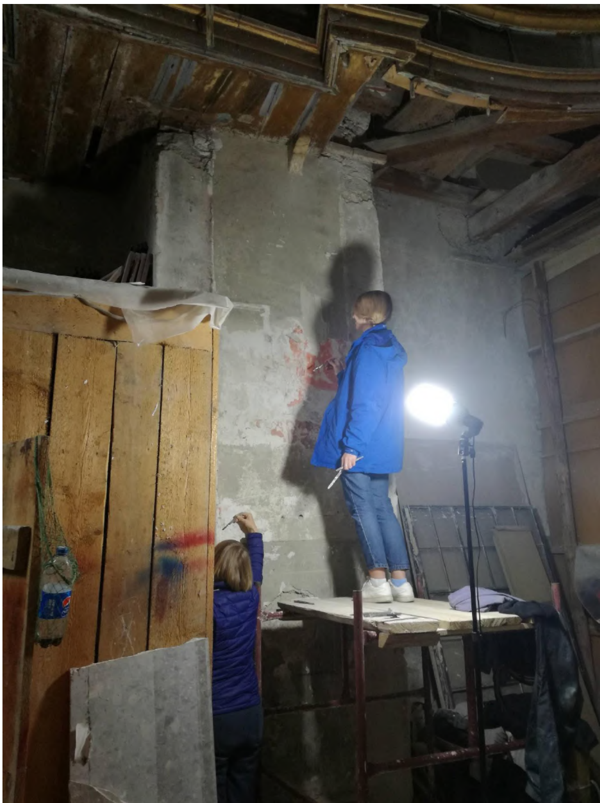
Fot. 53. Odkrywanie i oczyszczanie odnalezionego malowidła na zachodniej ścianie filara w prawej nawie kościoła pod chórem. Fot. Anna Kudzia.
