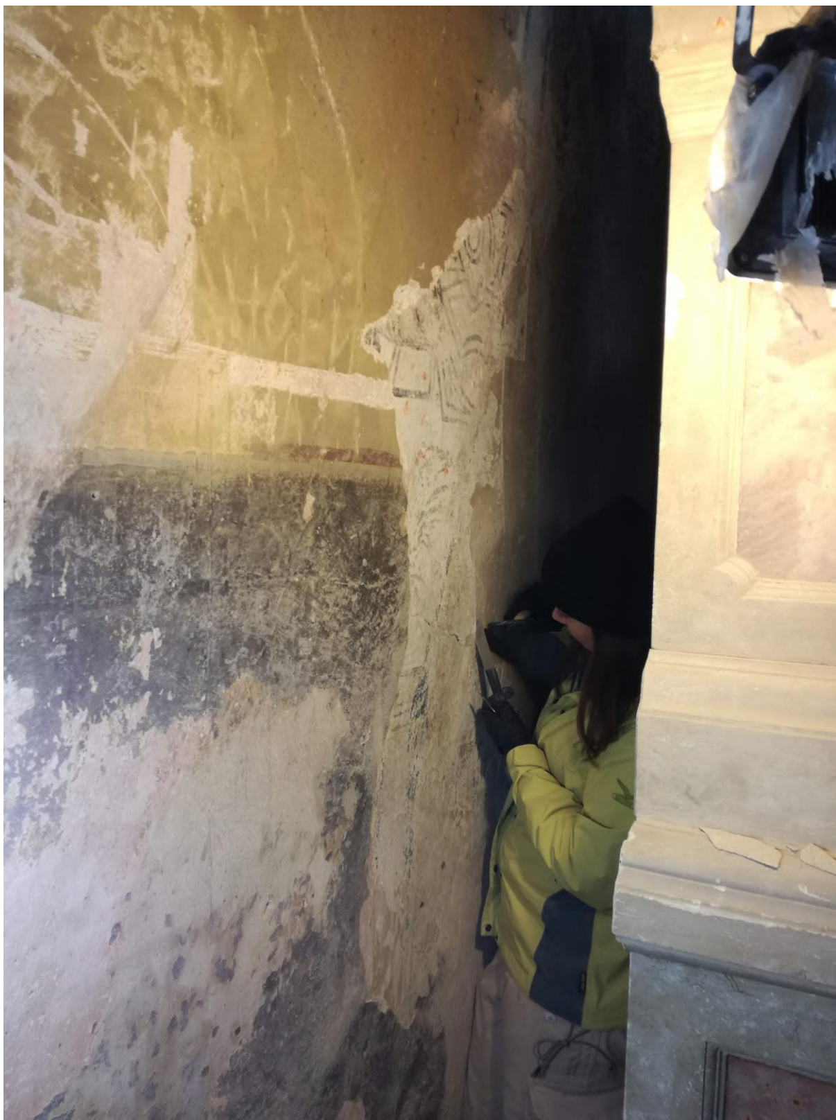
Fot. 64. Poszerzanie odkrywkę po lewej stronie ołtarza kamiennego w kaplicy Matki Bożej Różańcowej (z początku XVII wieku), w celu określenia zakresu malowideł na ścianie wschodniej kaplicy. Fot. Anna Kudzia.
