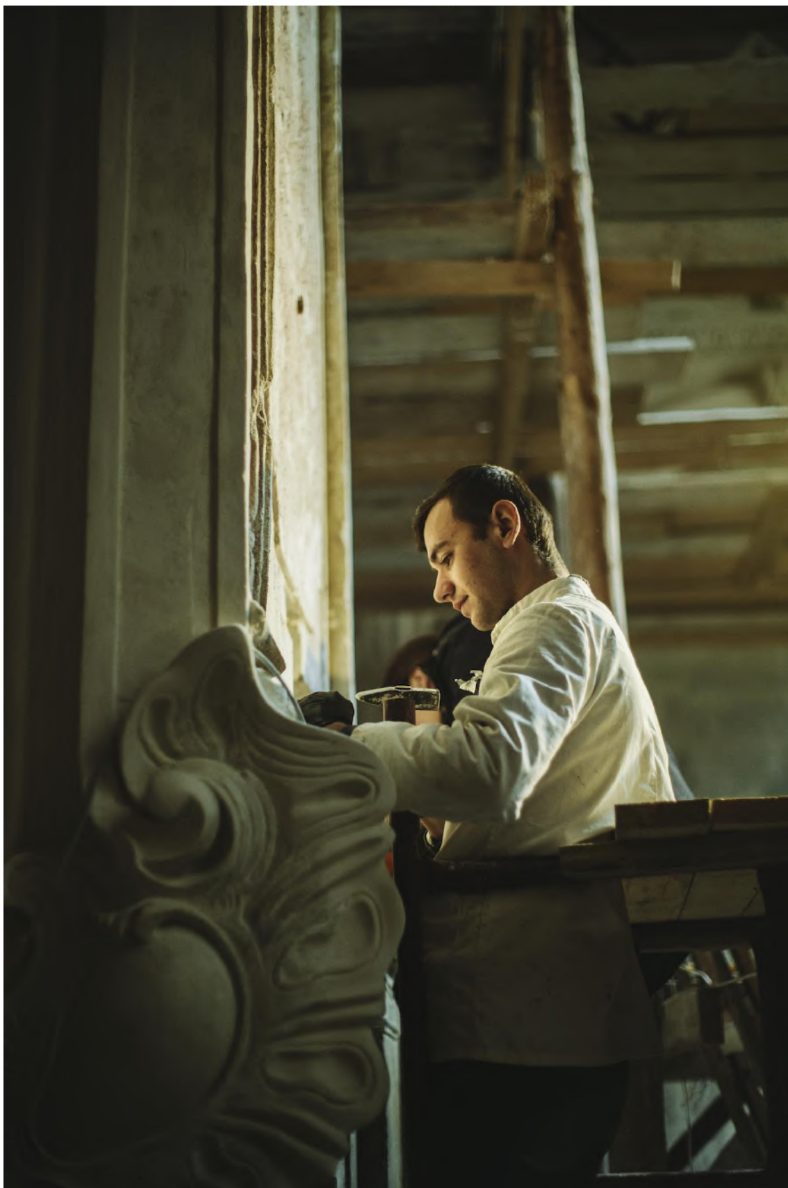
Fot. 41. Wykonywanie odkrywek na południowej ścianie filara w prawej nawie kościoła. Fot. Wawrzyniec Skoczylas.
