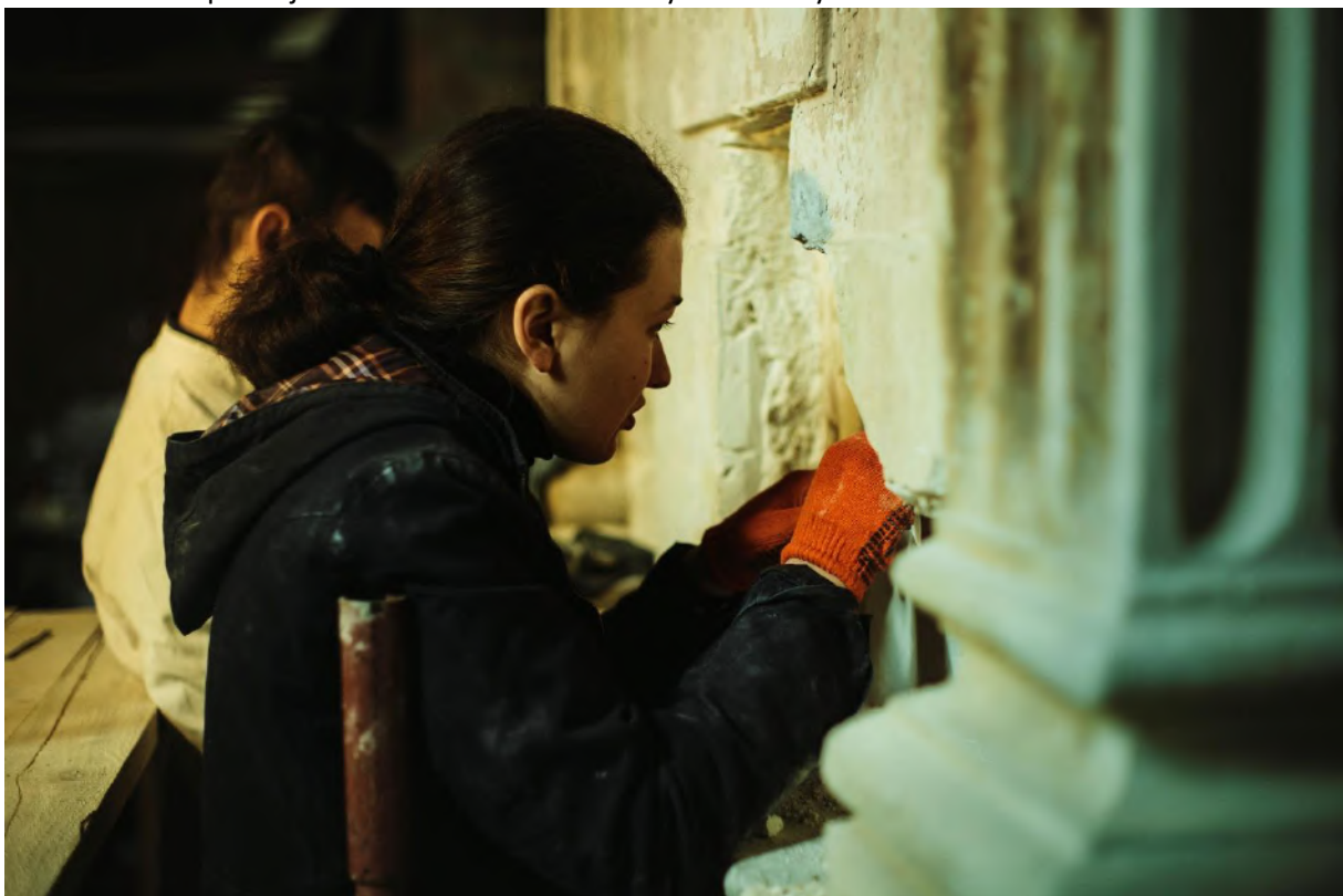
Fot. 43. Nacinanie grubego tynku szlifierką kątową w celu wykonania odkrywek na południowej ścianie filara w prawej nawie kościoła. Fot. Wawrzyniec Skoczylas.
