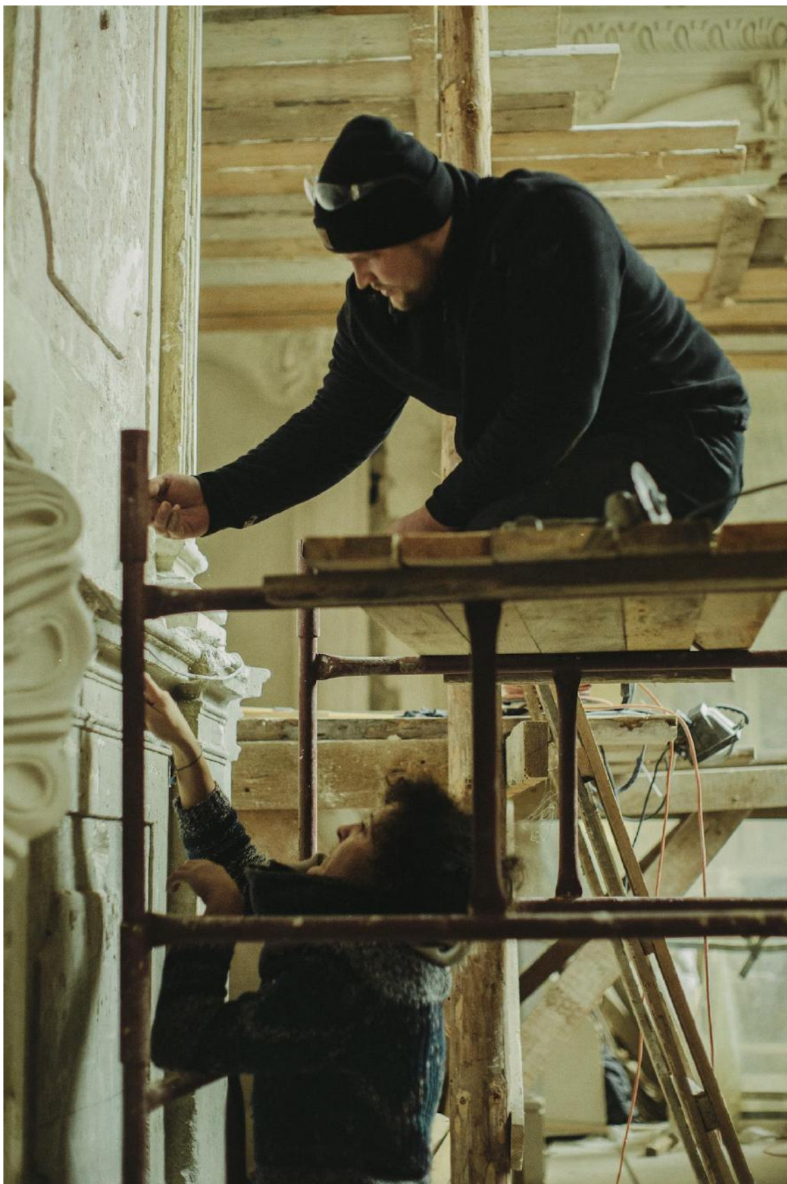
Fot. 39. Określanie miejsc wykonywania odkrywek na południowej ścianie filara, w prawej nawie kościoła. Fot. Wawrzyniec Skoczylas.
