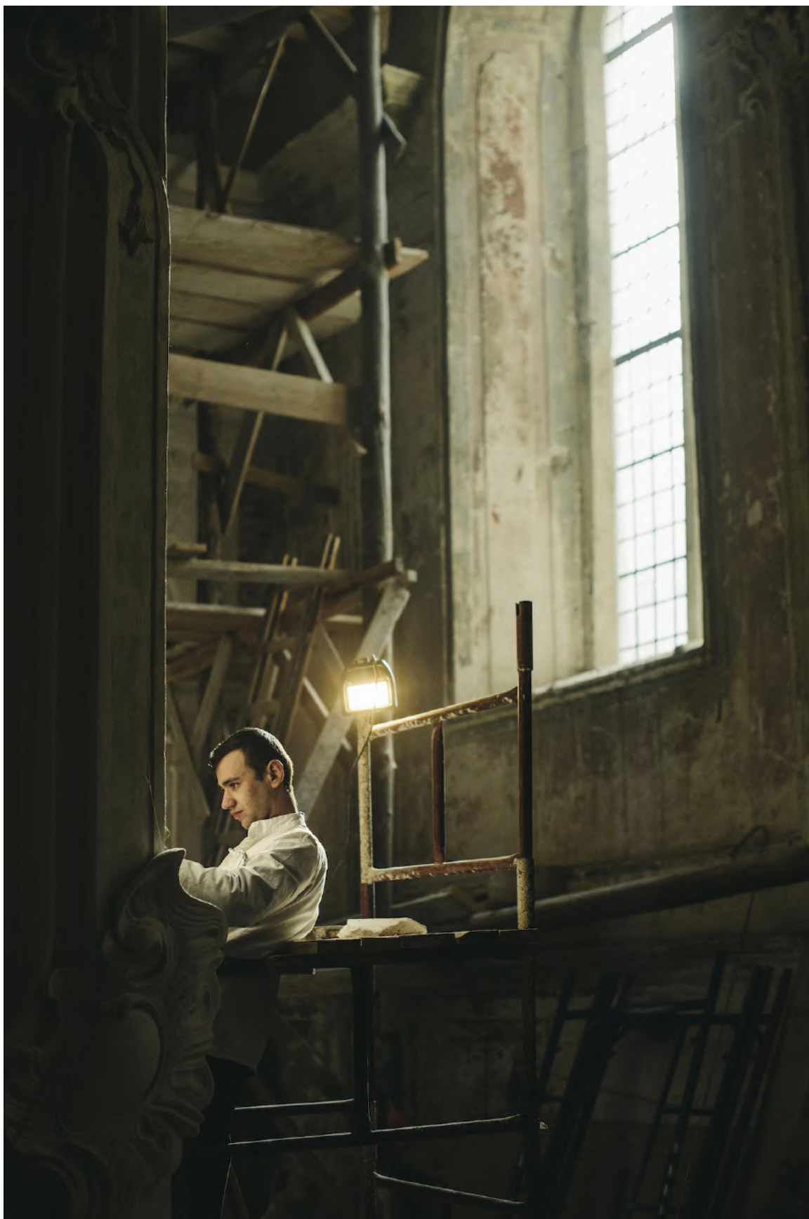
Fot. 40. Wykonywanie odkrywek na południowej ścianie filara w prawej nawie kościoła. Fot. Wawrzyniec Skoczylas.
