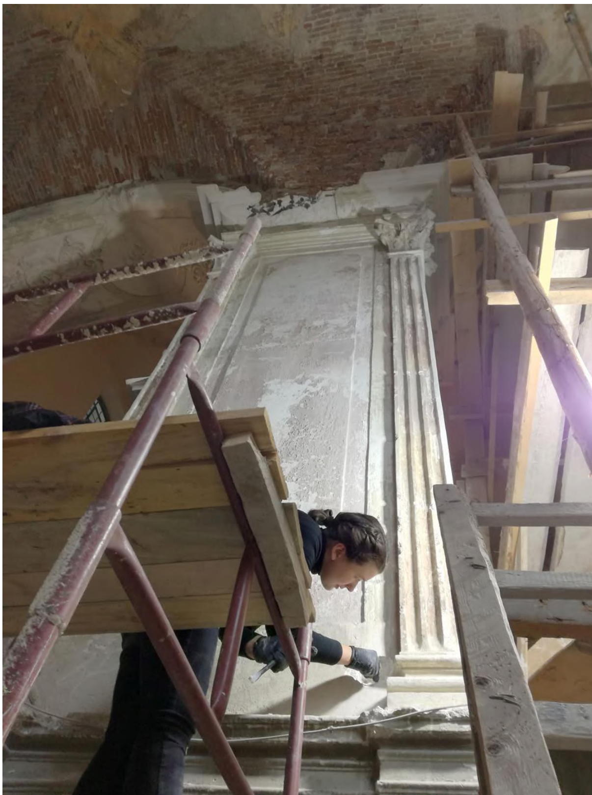
Fot. 45. Wykonywanie odkrywek na południowej ścianie filara w prawej nawie kościoła. Fot. Anna Kudzia.
